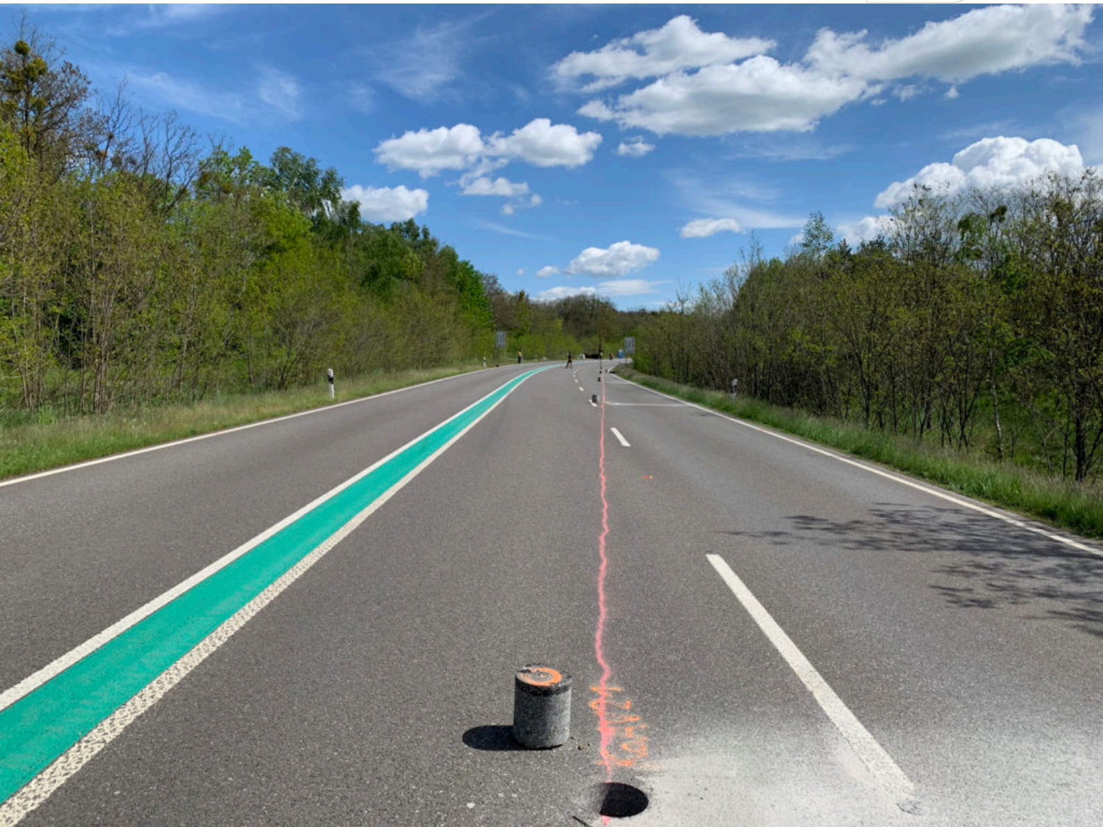
Die rote Linie zeigt den Verlauf der untertägigen Strecke unter der B 169 Impressionen von den Arbeiten an B 169
