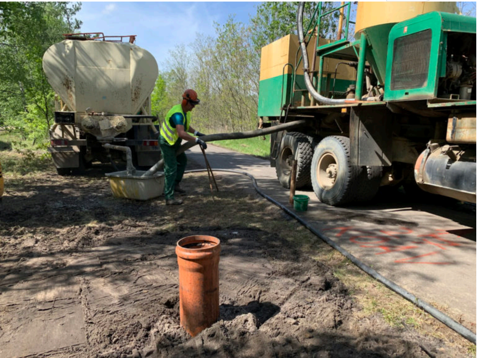
Nach Kernbohrung wurde verrohrt
