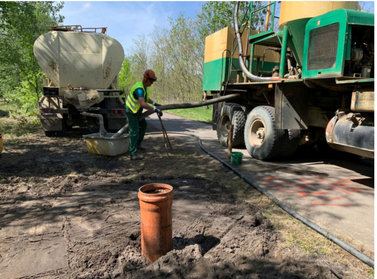
Nach Kernbohrung wurde verrohrt
