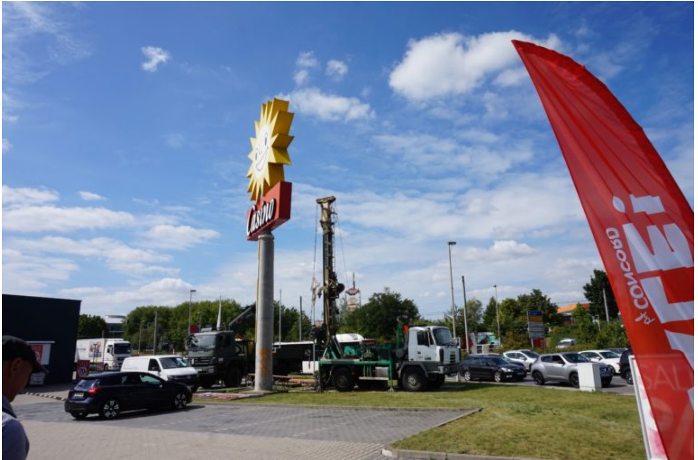
Bohrerkundungsprogramm im Abstrom der Grundwassereinigungsanlage Schedewitz
