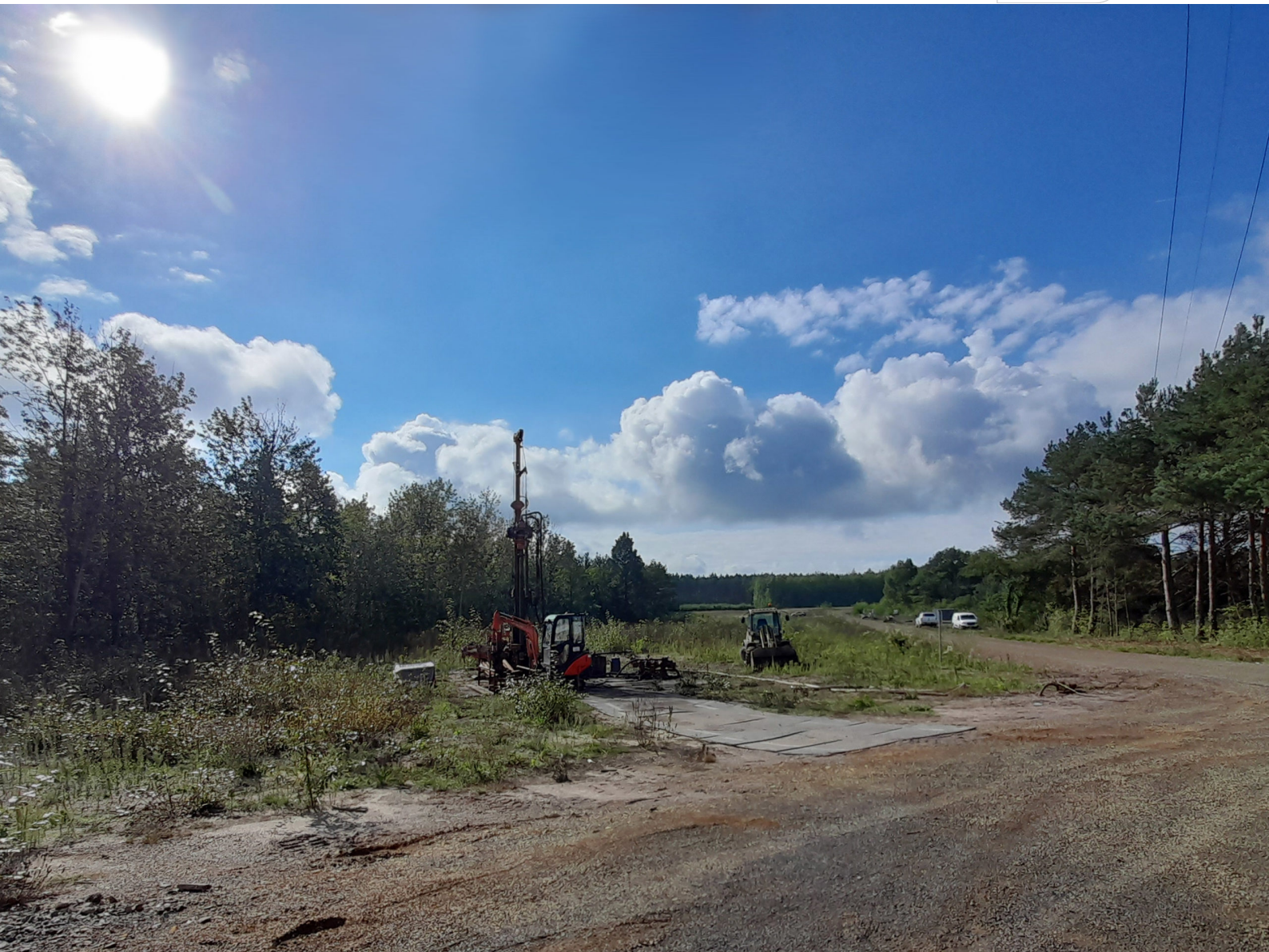
Filterbrunnenverwahrung auf der Brückenfeldkippe
