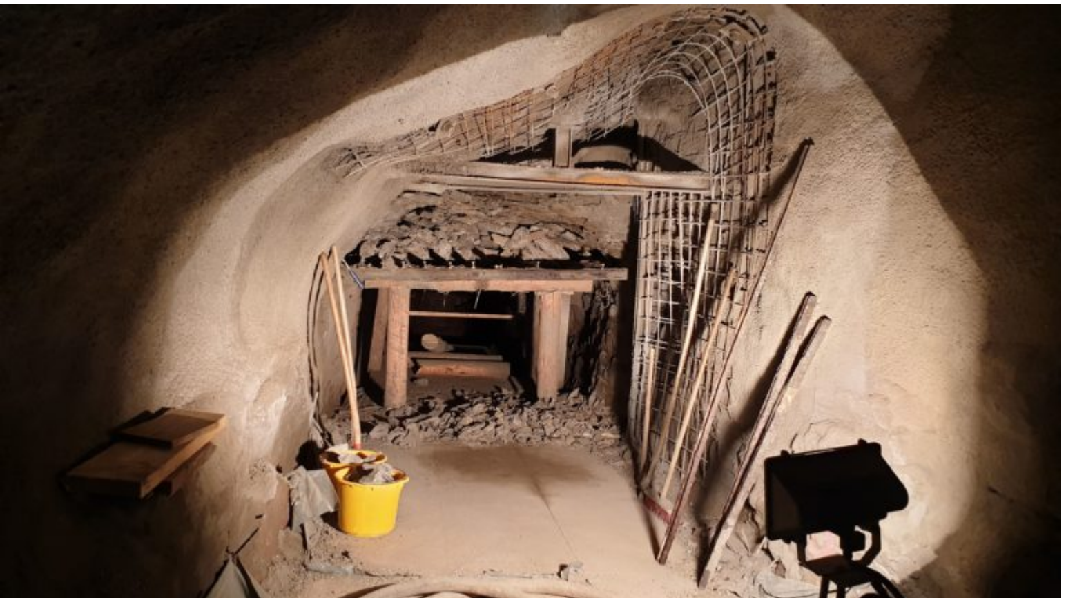
Hergestellter Ausbau in Blickrichtung Schlüsselstollen
