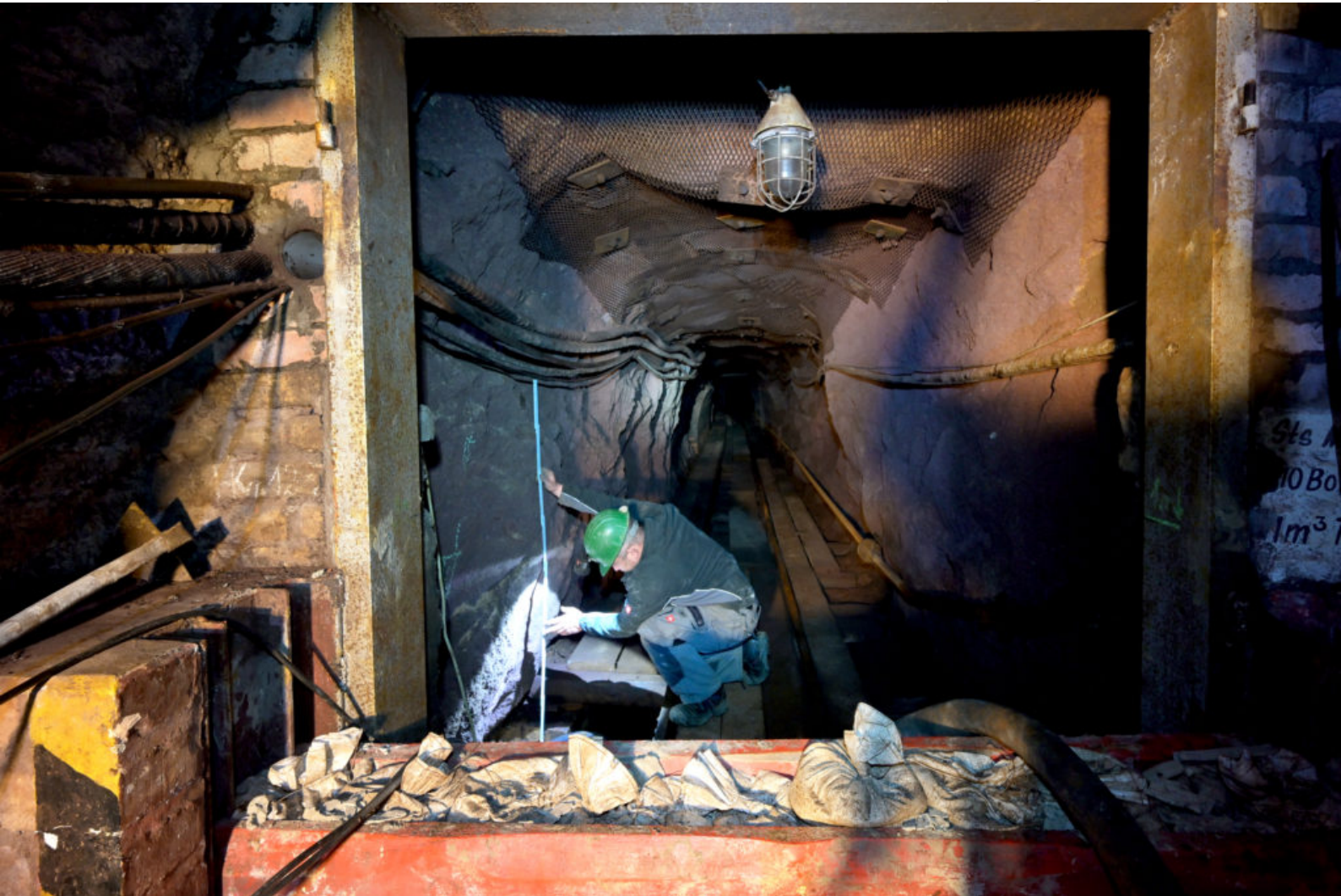
Pegelmessung im Areal des temporären Damms
