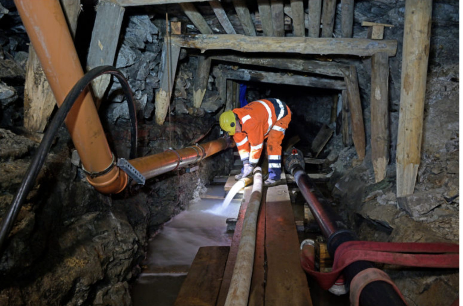
Ableitung des Wassers in Segen-Gottes-Stollen.
