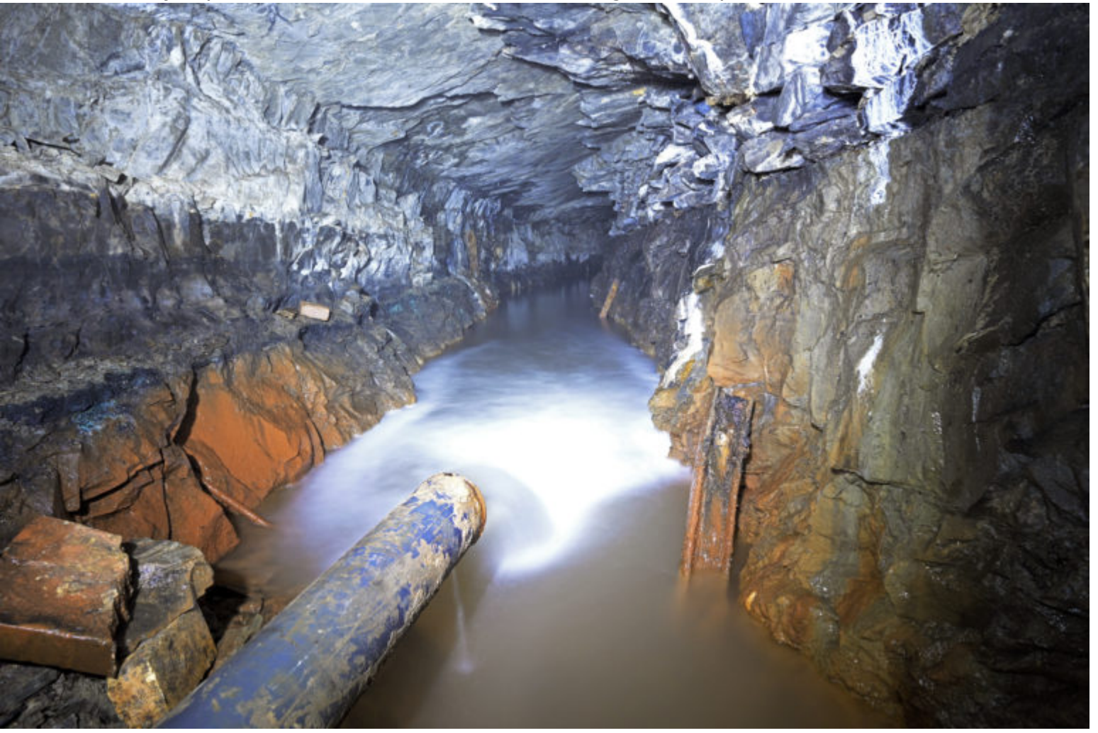
Das überschüssige Wasser wird in den Seegen-Gottes-Stolln gehoben.
