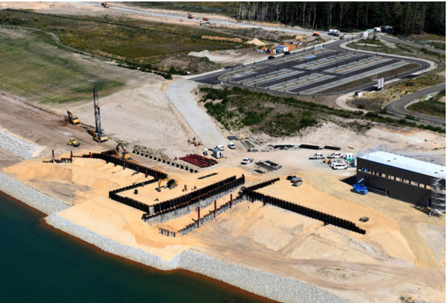
Sanierungsstützpunkt im Bau
