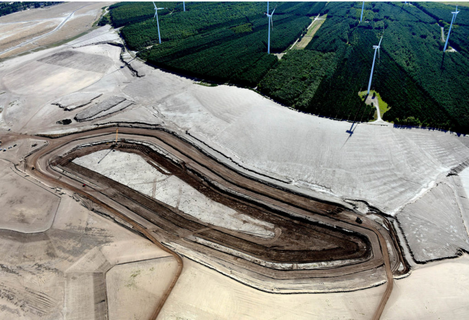
Verichtung der Inselufer im künftigen Cottbuser Ostsee
