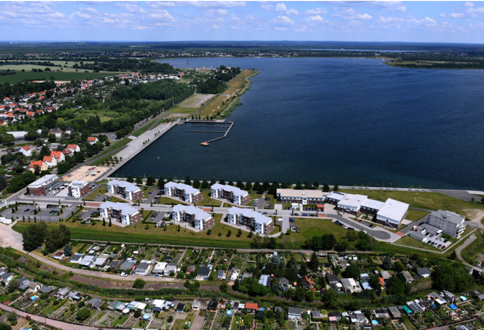
Wohnbebauung an der Goitzsche
