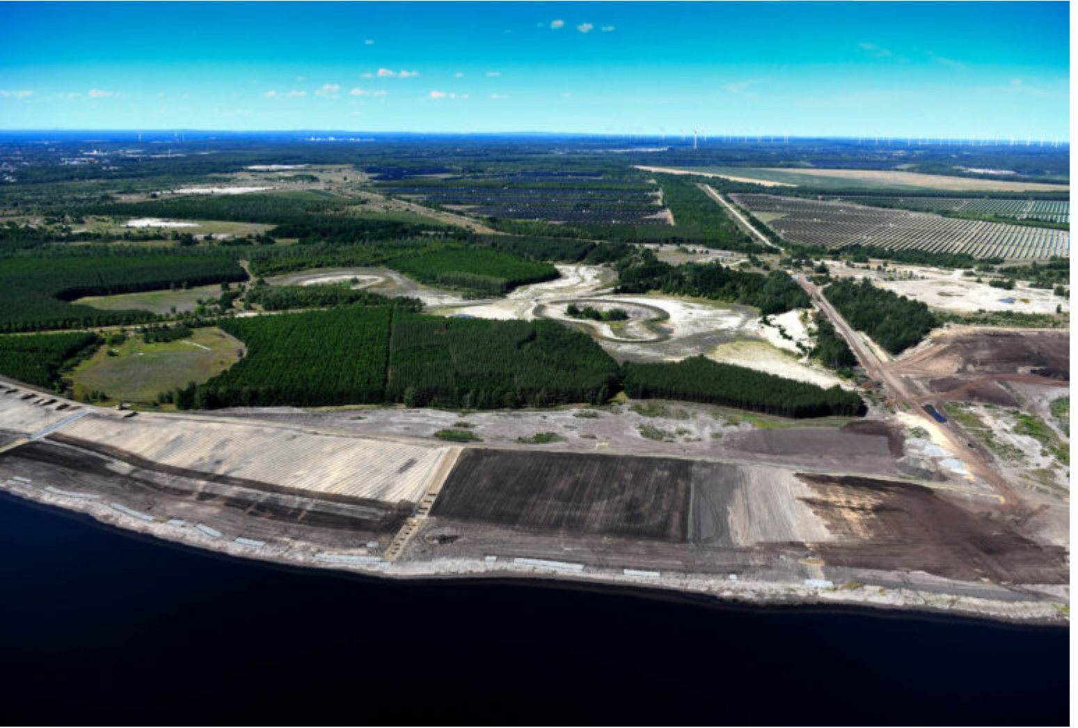
Böschungssicherung RL Meuro
