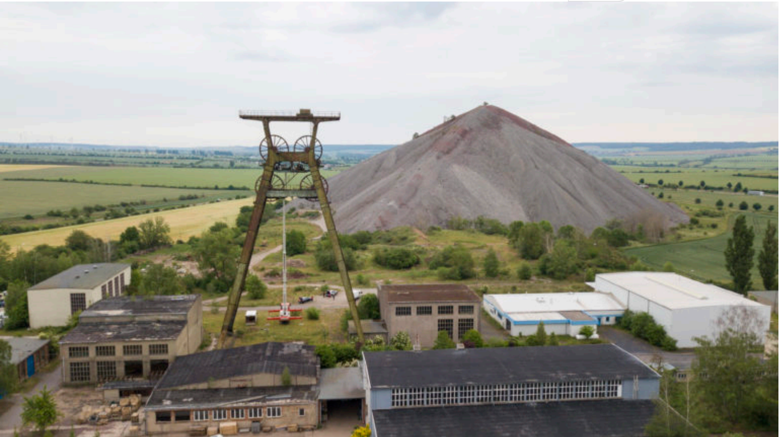
Fördergerüst Bernard Koenen Schacht II mit den ehem. Schachtgebäuden und der Spitzkegelhalde
