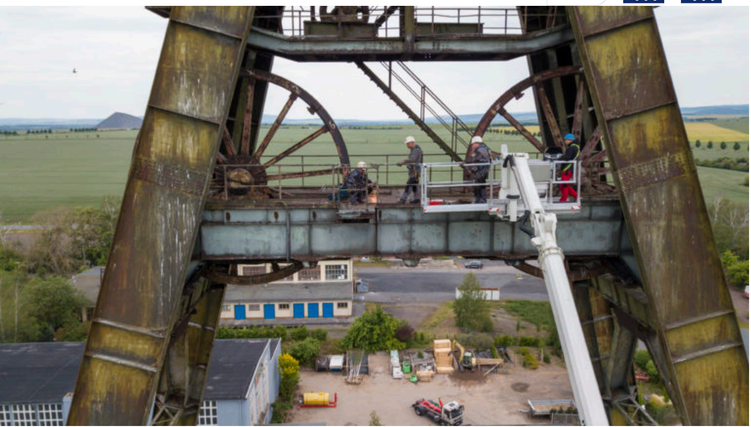
Sicherungsarbeiten auf der unteren Seilscheibenbühne des Fördergerüsts Nienstedt
