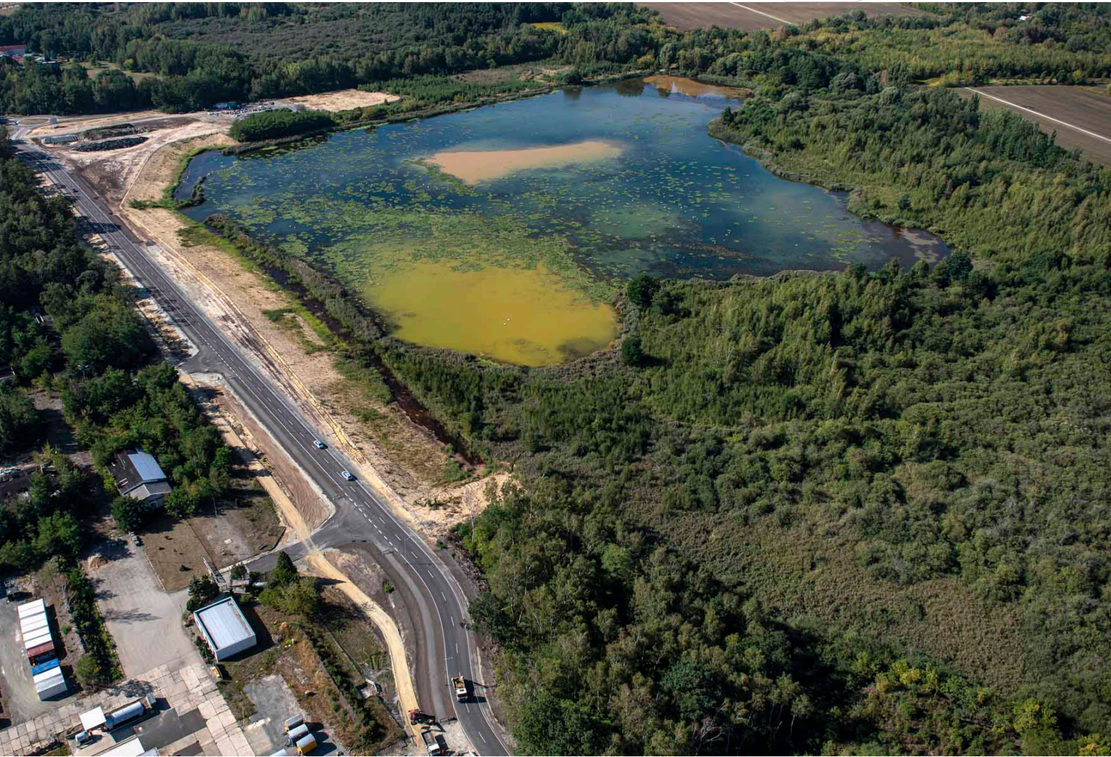
Ortrander Str. in Lauchhammer – 2019 während der Sanierungsarbeiten
