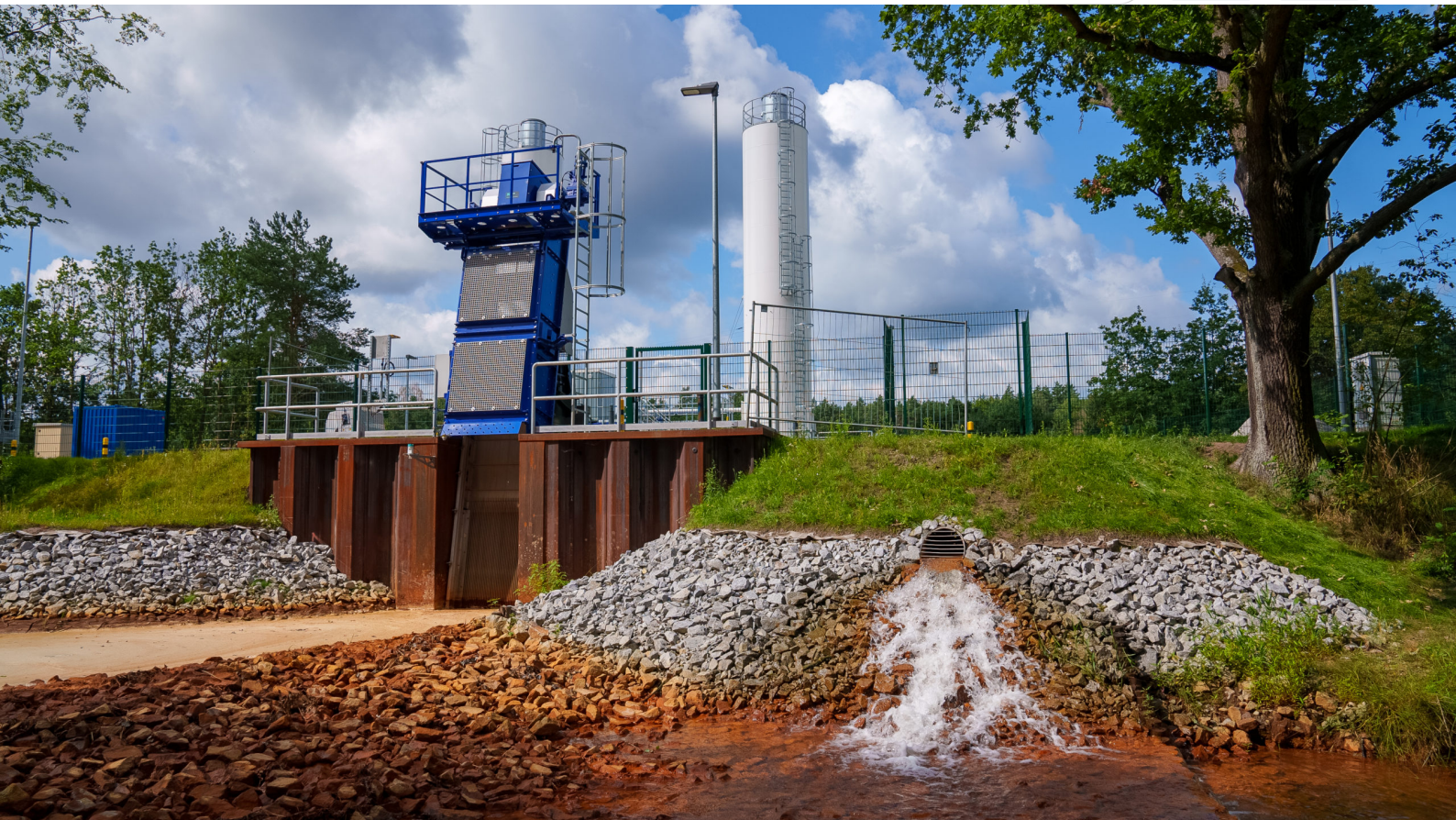
Zu- und Ablauf der MWBA Ruhlmühle
