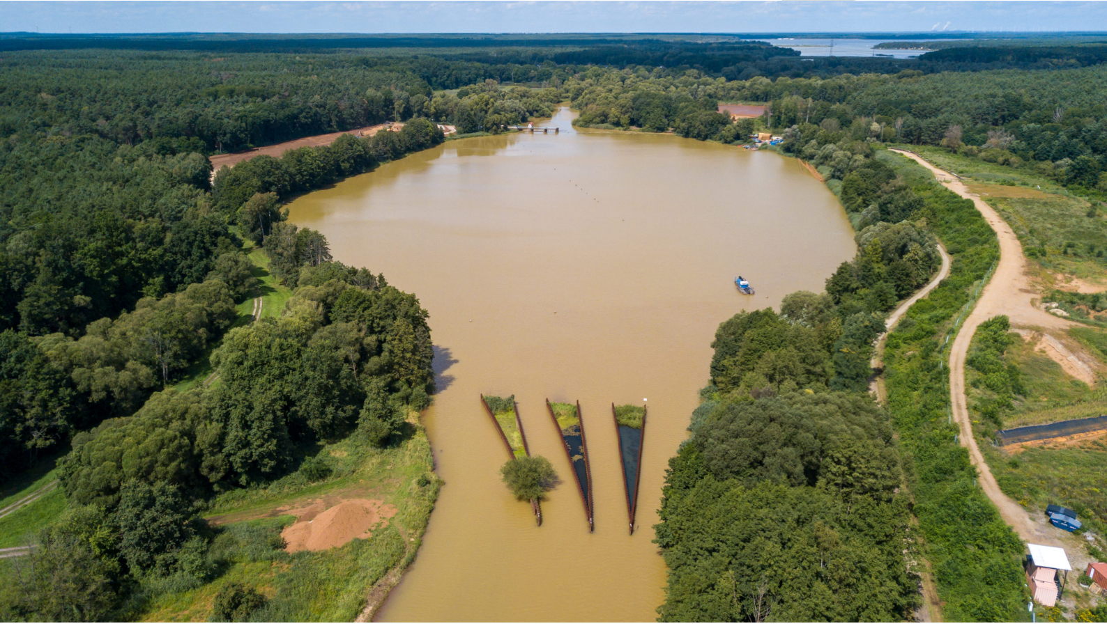
Blick auf die Vorsperre Bühlow
