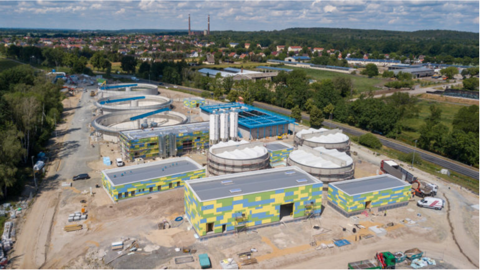
Die im Bau befindliche LMBV-Wasserbehandlungsanlage Plessa (Juni 2022)
