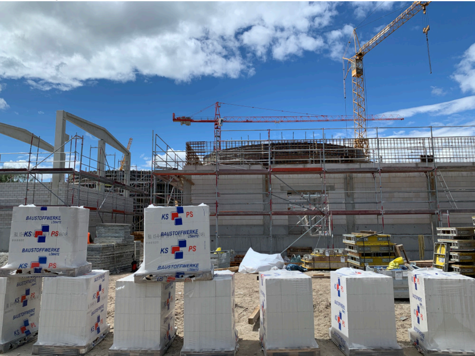
Blick auf die Baustelle
