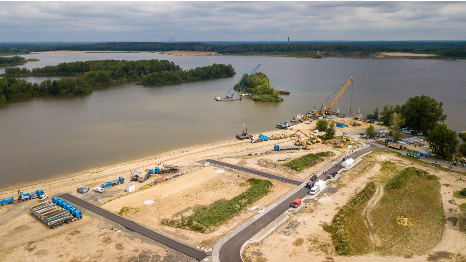
Baustelleninformationstag am Knappensee 2022
