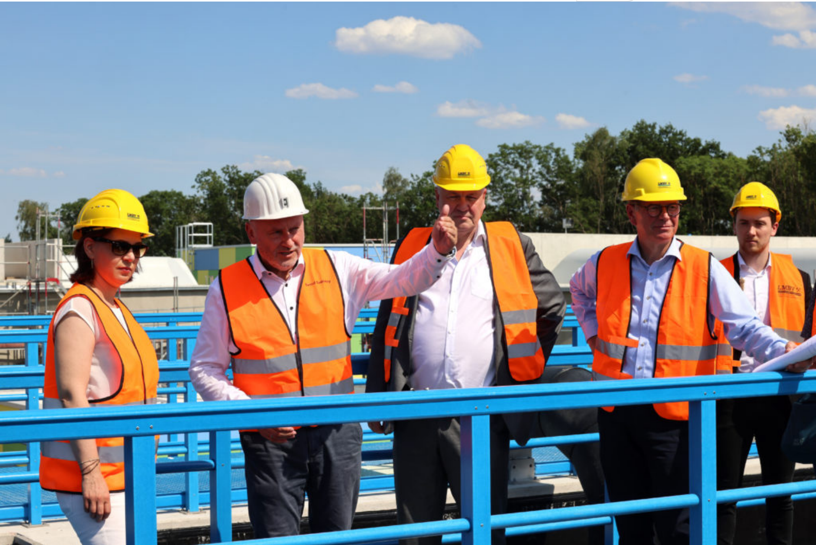
Erläuterungen zur LMBV-Baustelle Plessa
