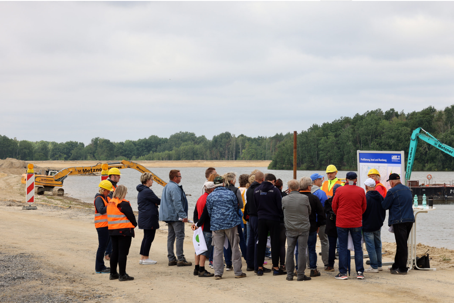
Baustelleninformationstag am Knappensee 2022
