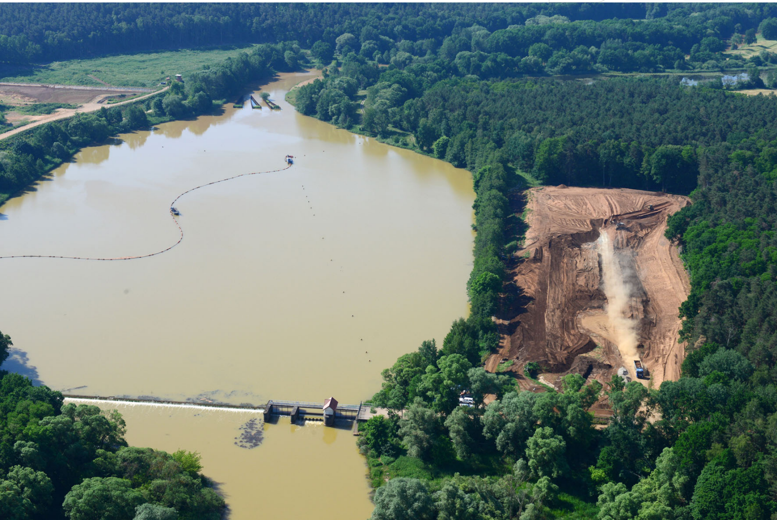
Sedimentationsbecken an der Vorsperre Bühlow
