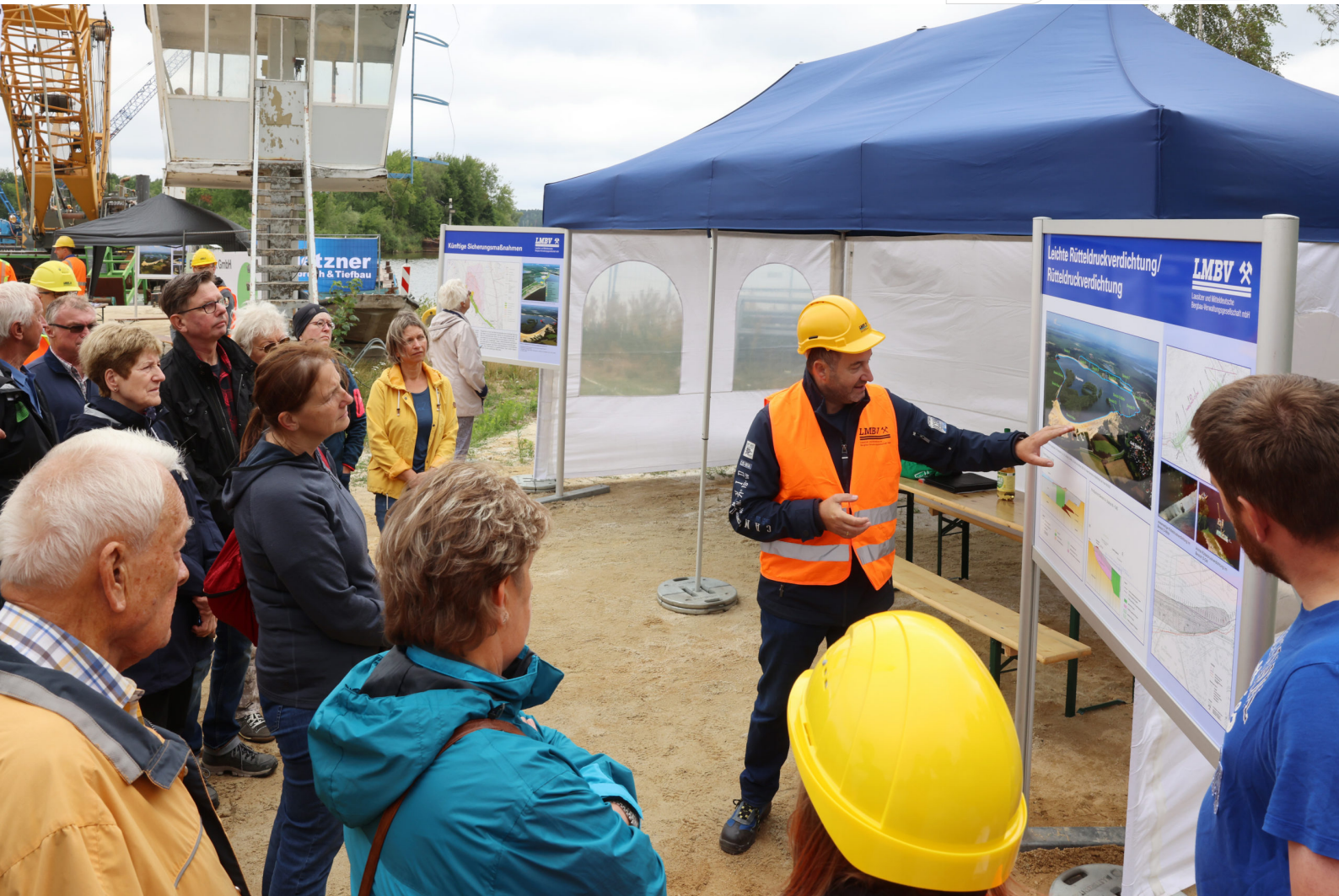
Baustelleninformationstag am Knappensee 2022
