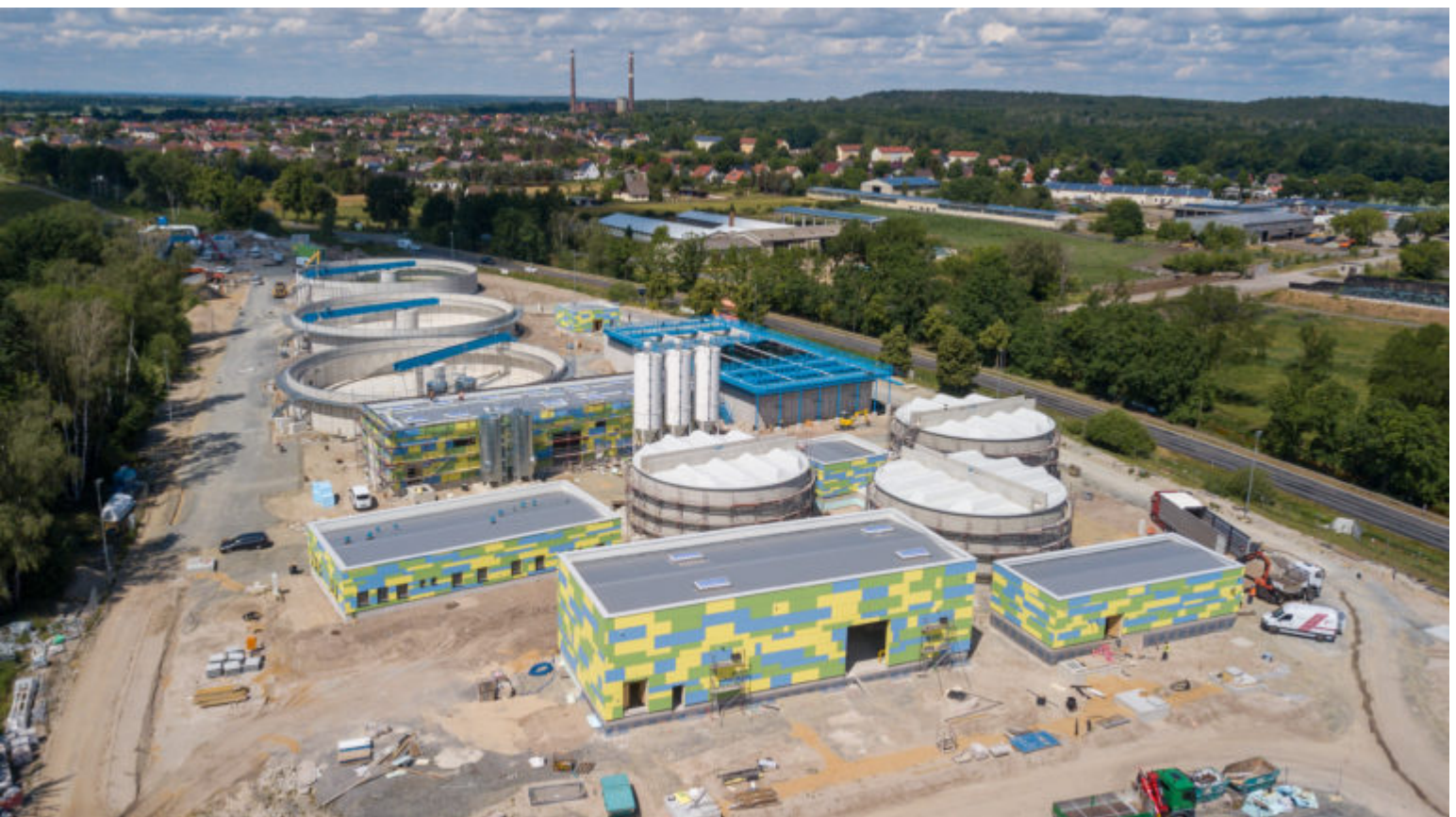
Die im Bau befindliche LMBV-Wasserbehandlungsanlage Plessa (Juni 2022)
