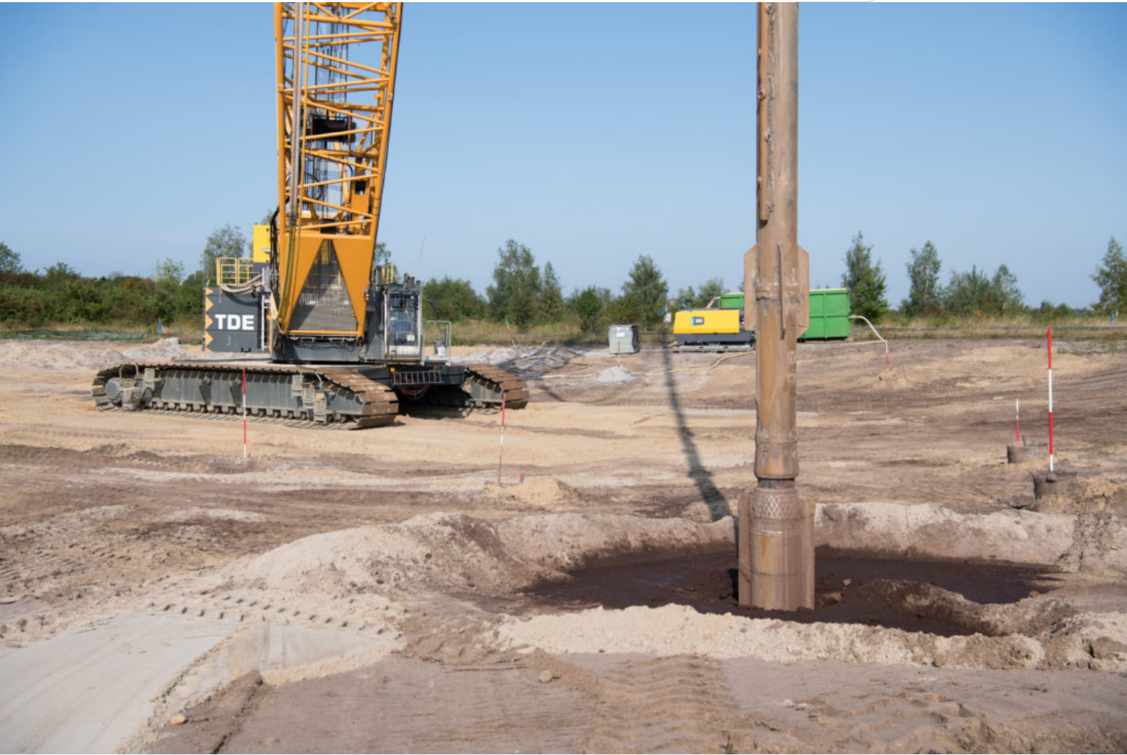
Rütteldruckverdichtung am Speicherbecken Borna
