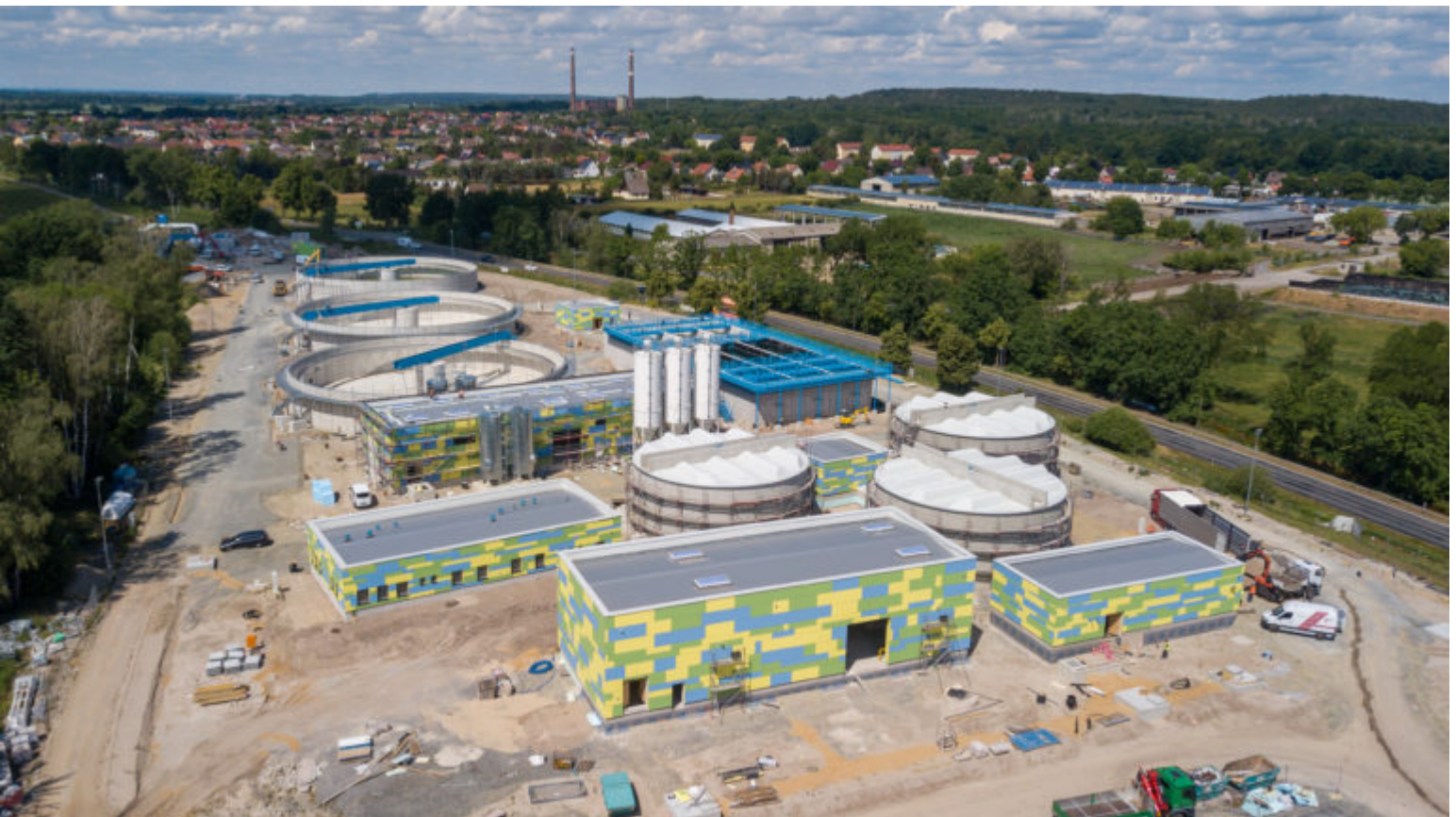
Die im Bau befindliche LMBV-Wasserbehandlungsanlage Pleßa (Juni 2022)
