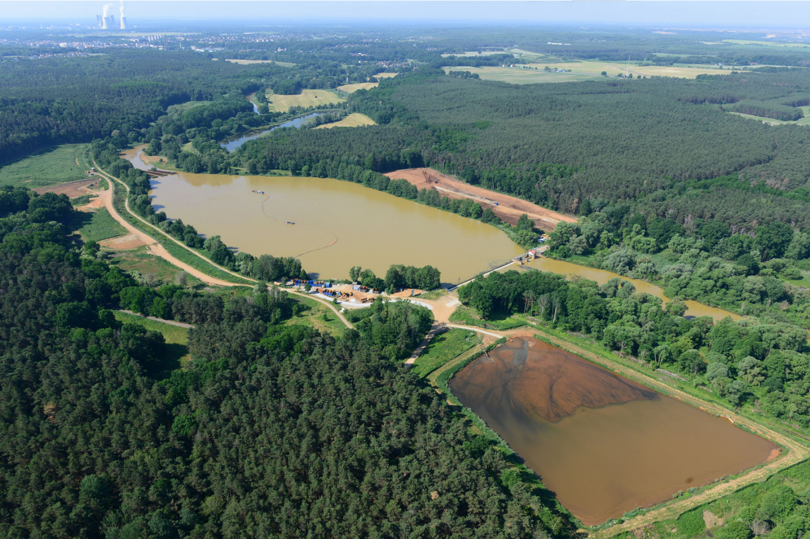
Sedimentationsbecken an der Vorsperre Bühlow
