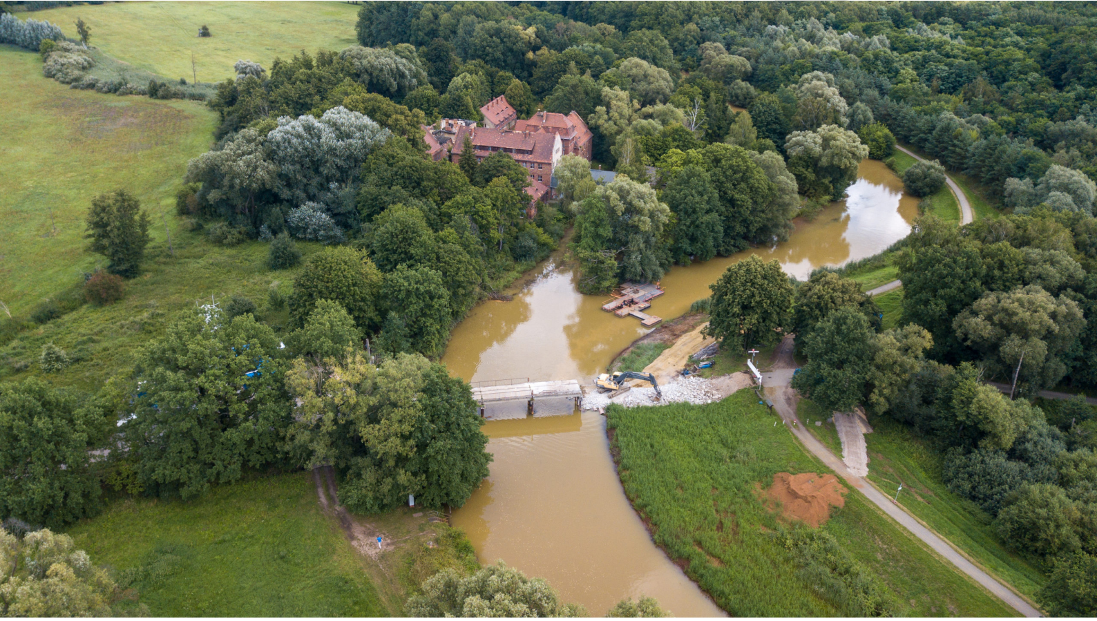
Ersatzneubau der Austragsleitung an der Konditionierungsanlage Wilhelmsthal
