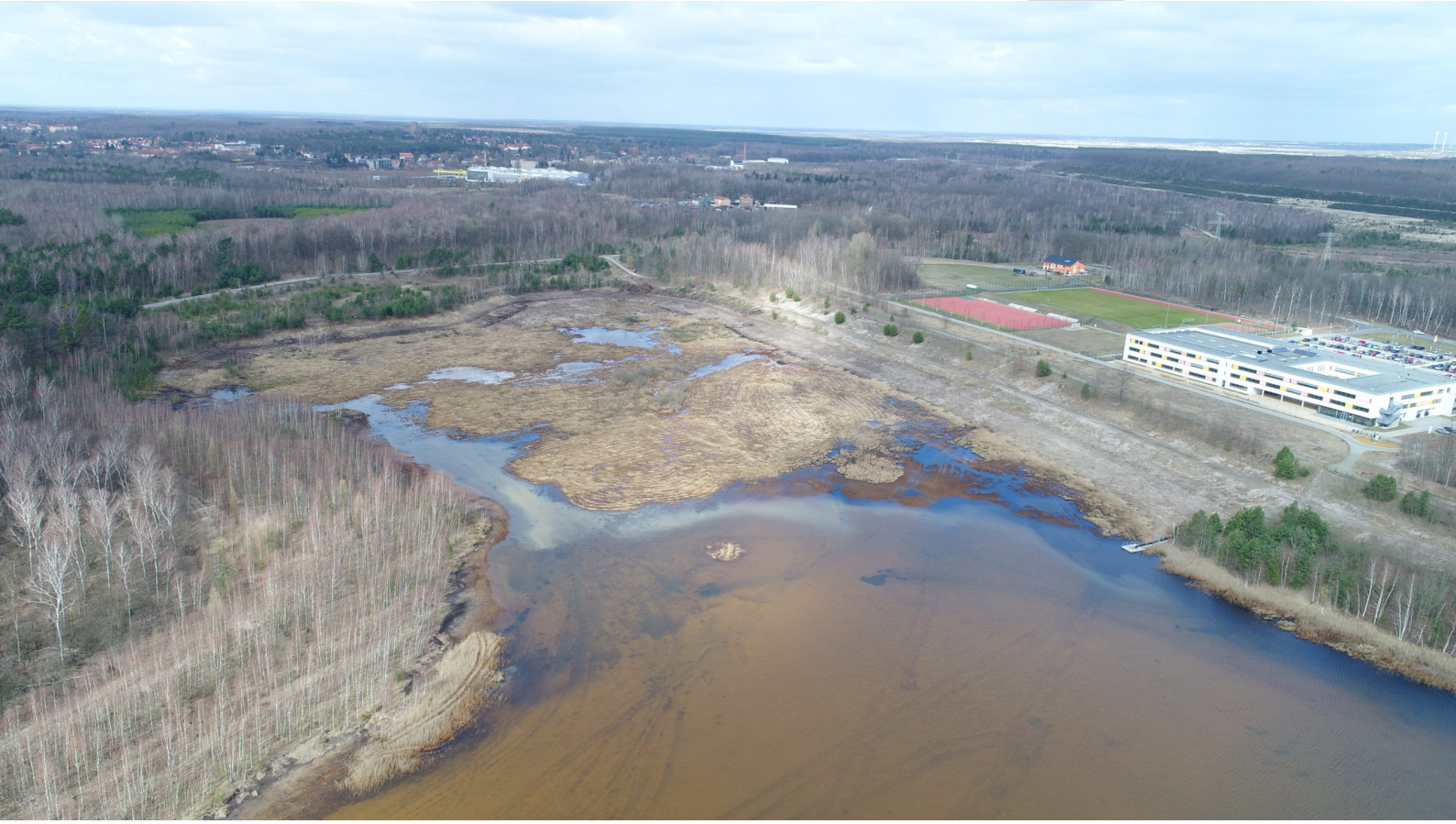
Kohleschlammfläche im RL 29 vor der Maßnahme
