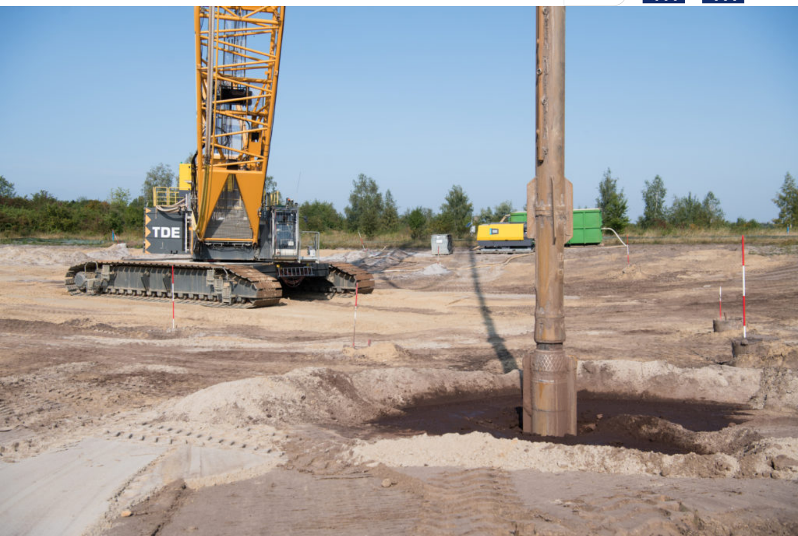
Rütteldruckverdichtung am Speicherbecken Borna
