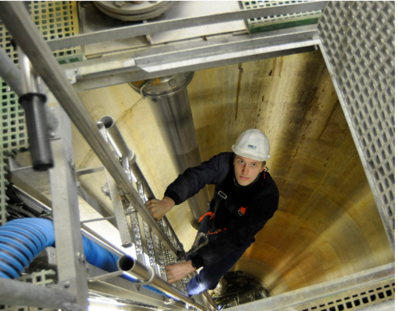
Kontrollbefahrung eines HBr | Foto: P. Radke
