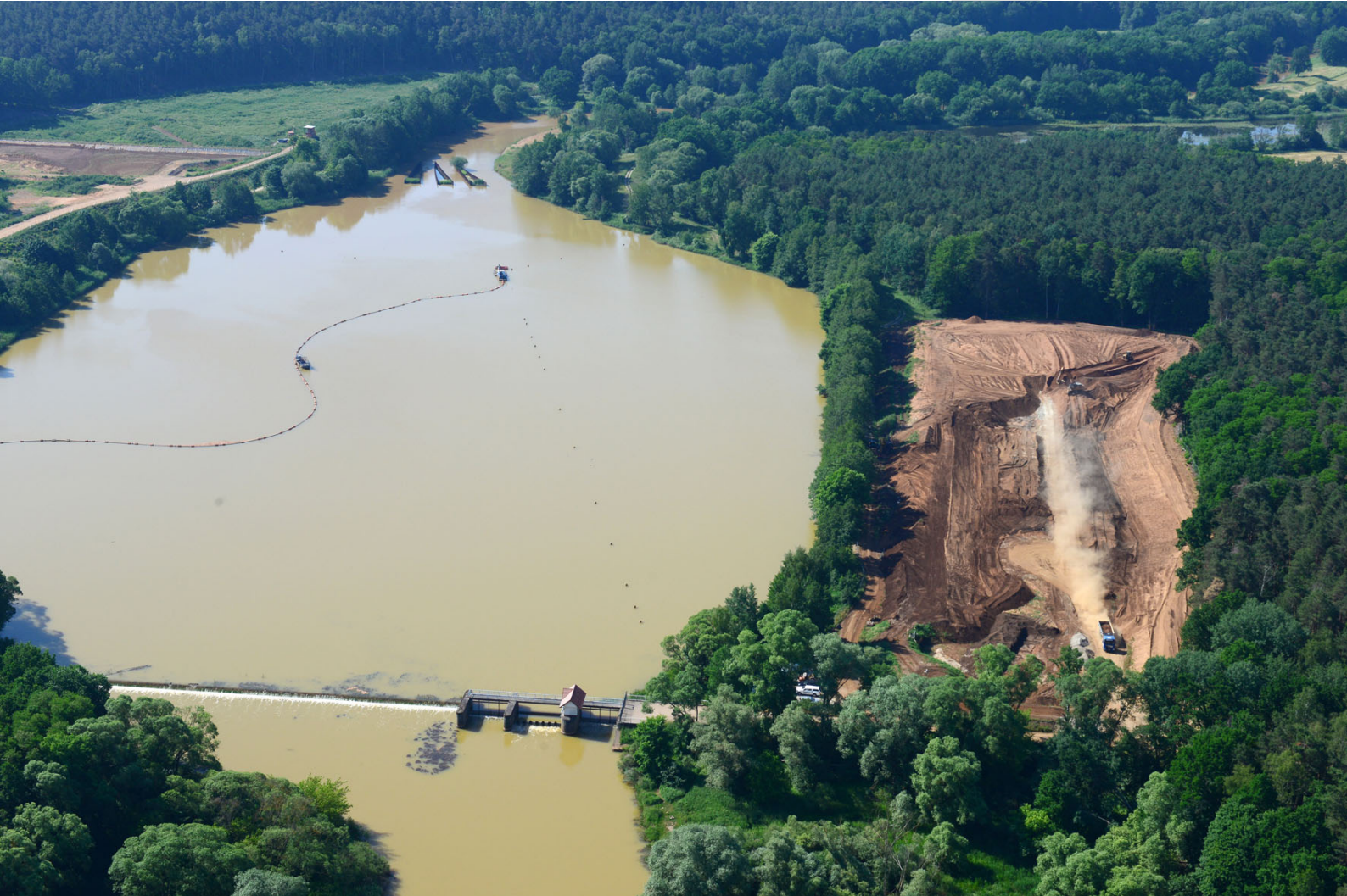
Sedimentationsbecken an der Vorsperre Bühlow
