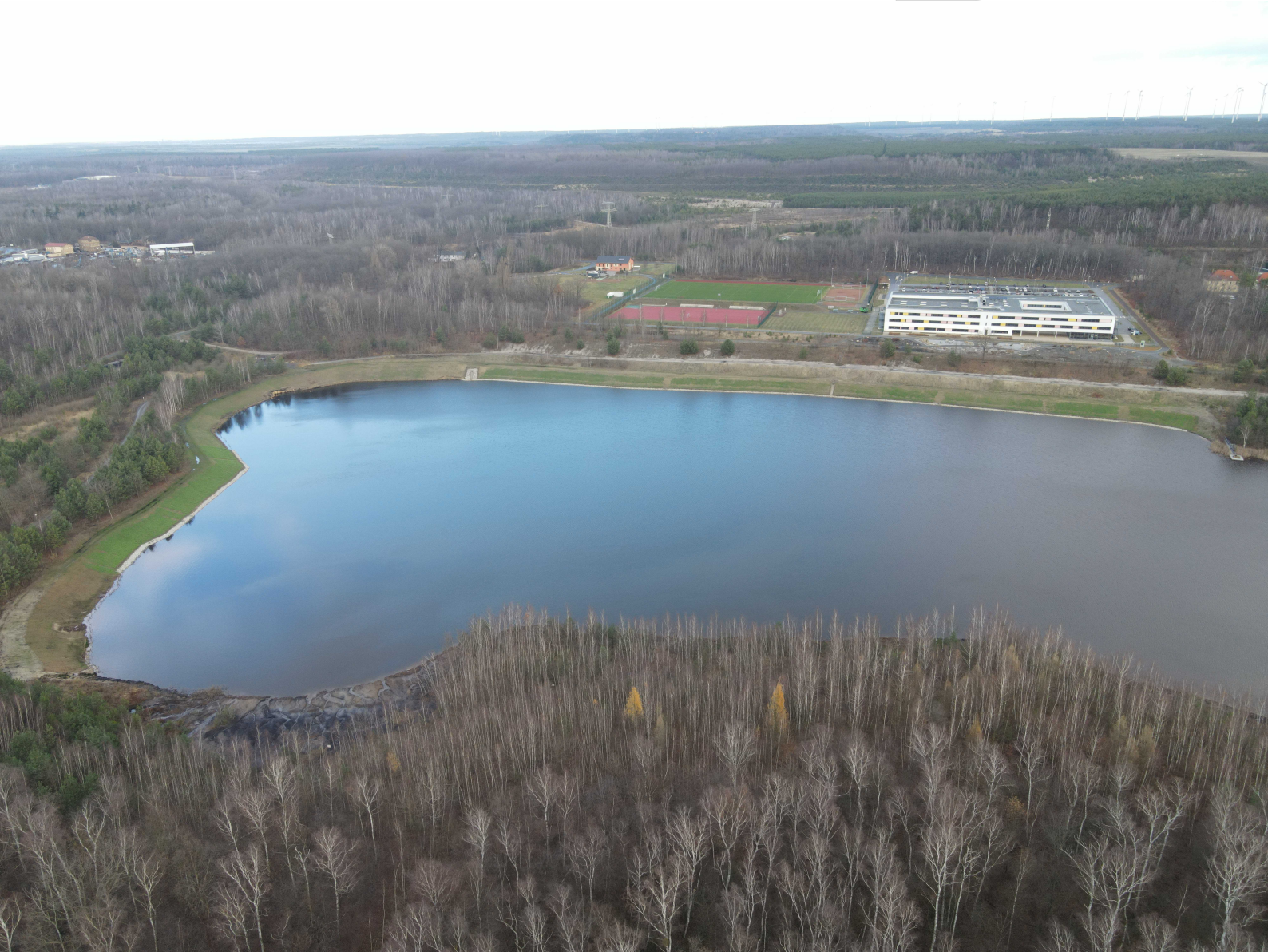
Kohleschlammfläche im Restloch 29 nach der Maßnahme
