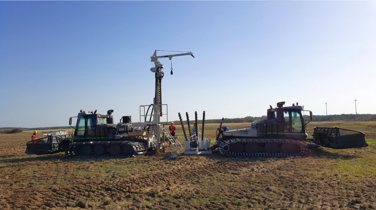
Schonende Sprengverdichtung / Foto: Dieter Kutzschbach
