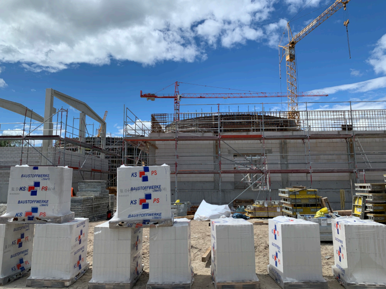
Blick auf die Baustelle
