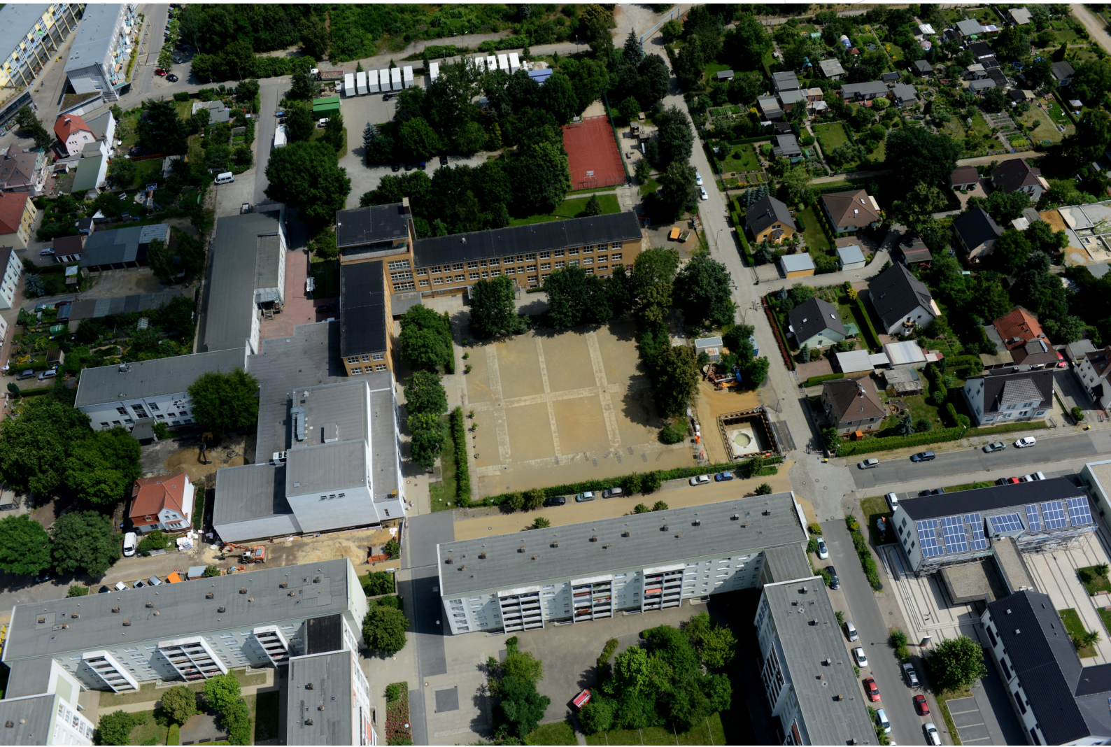
Blick auf Baugrube des HBr 3 | Foto: P. Radke | 2013
