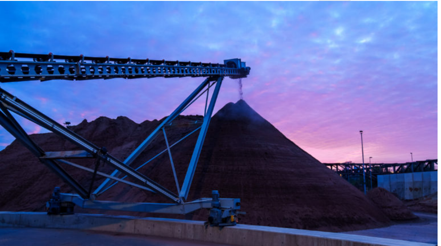
Abwurfanlage für gereinigten Boden
