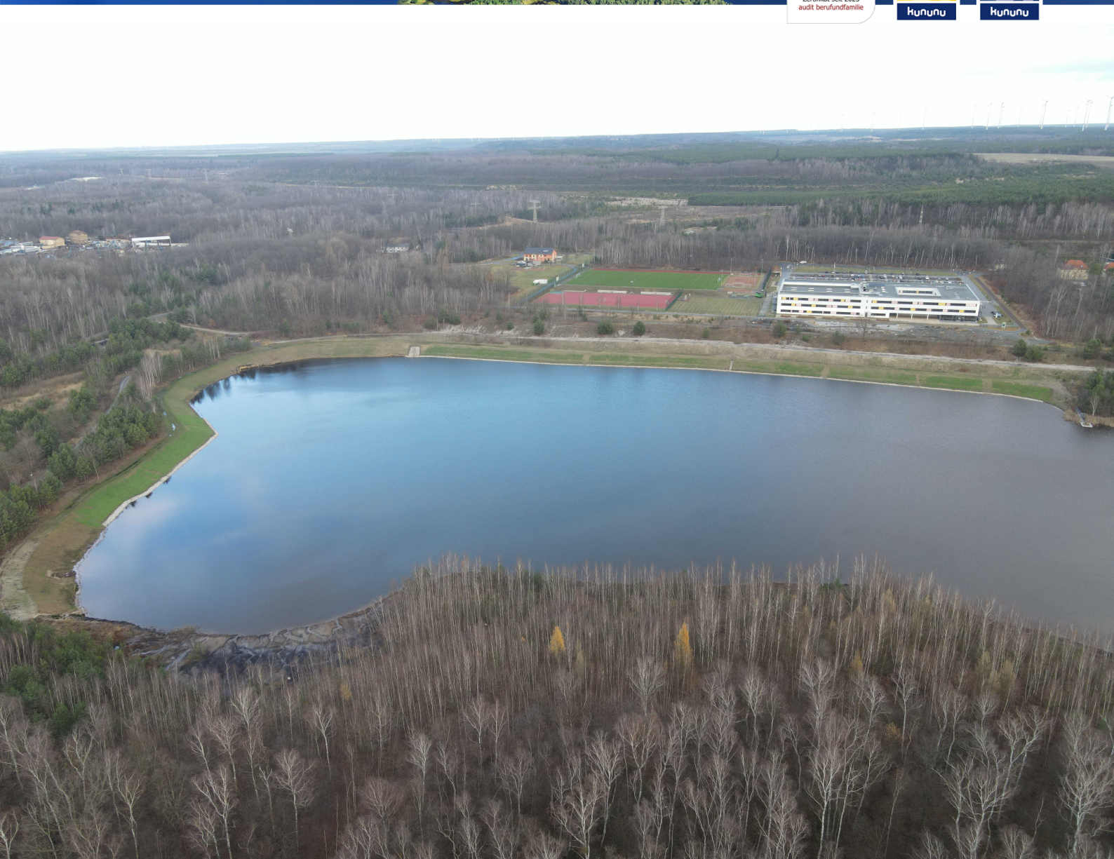
Kohleschlammfläche im Restloch 29 nach der Maßnahme
