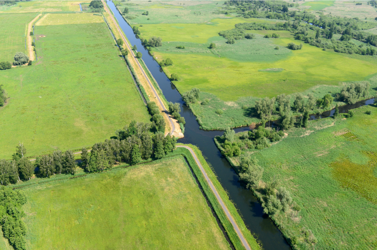
Einlaufbereich Ragower Kahnfahrt in die Hauptspree
