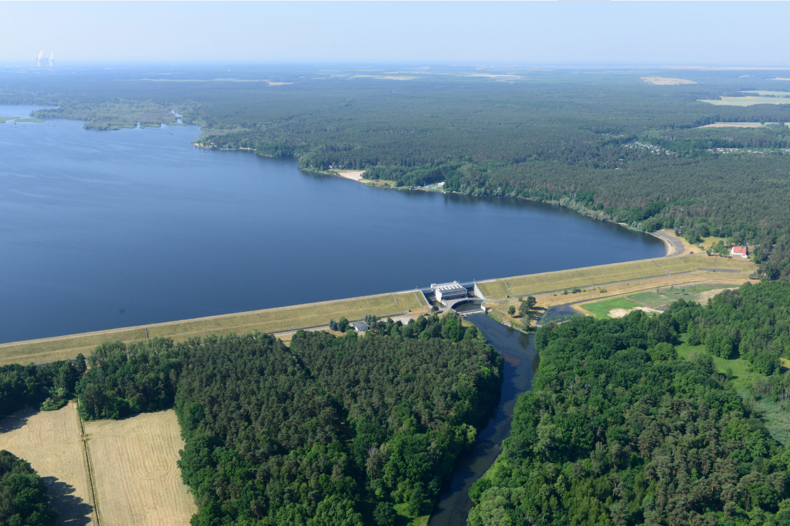
Talsperre Spremberg: Staumauer mit Auslauf
