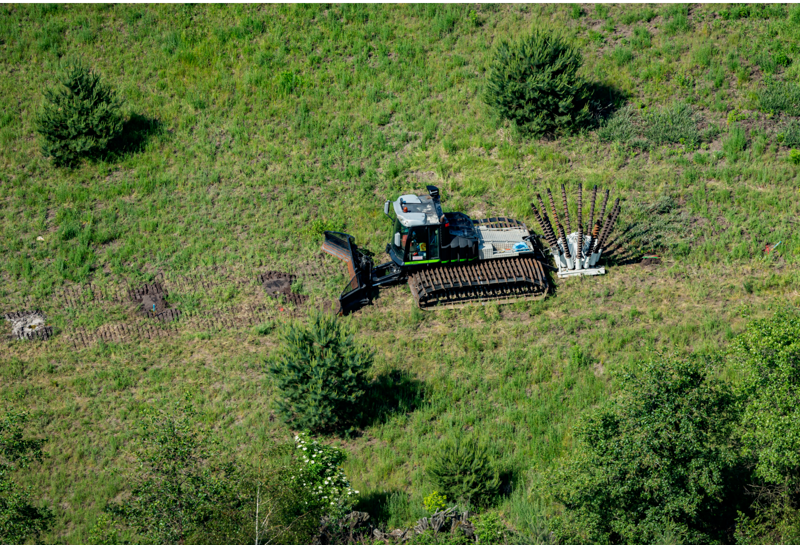
Vorbereitung der Schonenden Sprengverdichtung mit einem Raupenfahrzeug / Foto: Peter Radke
