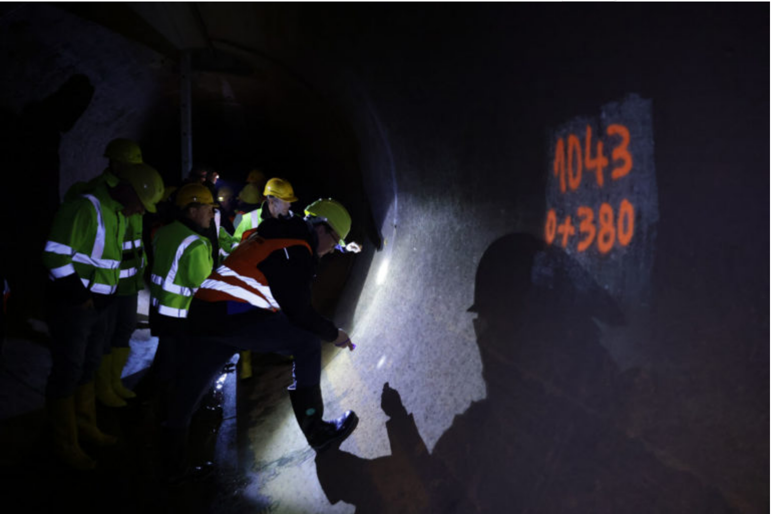
LMBV Überleiter Speicherbecken Lohsa II
