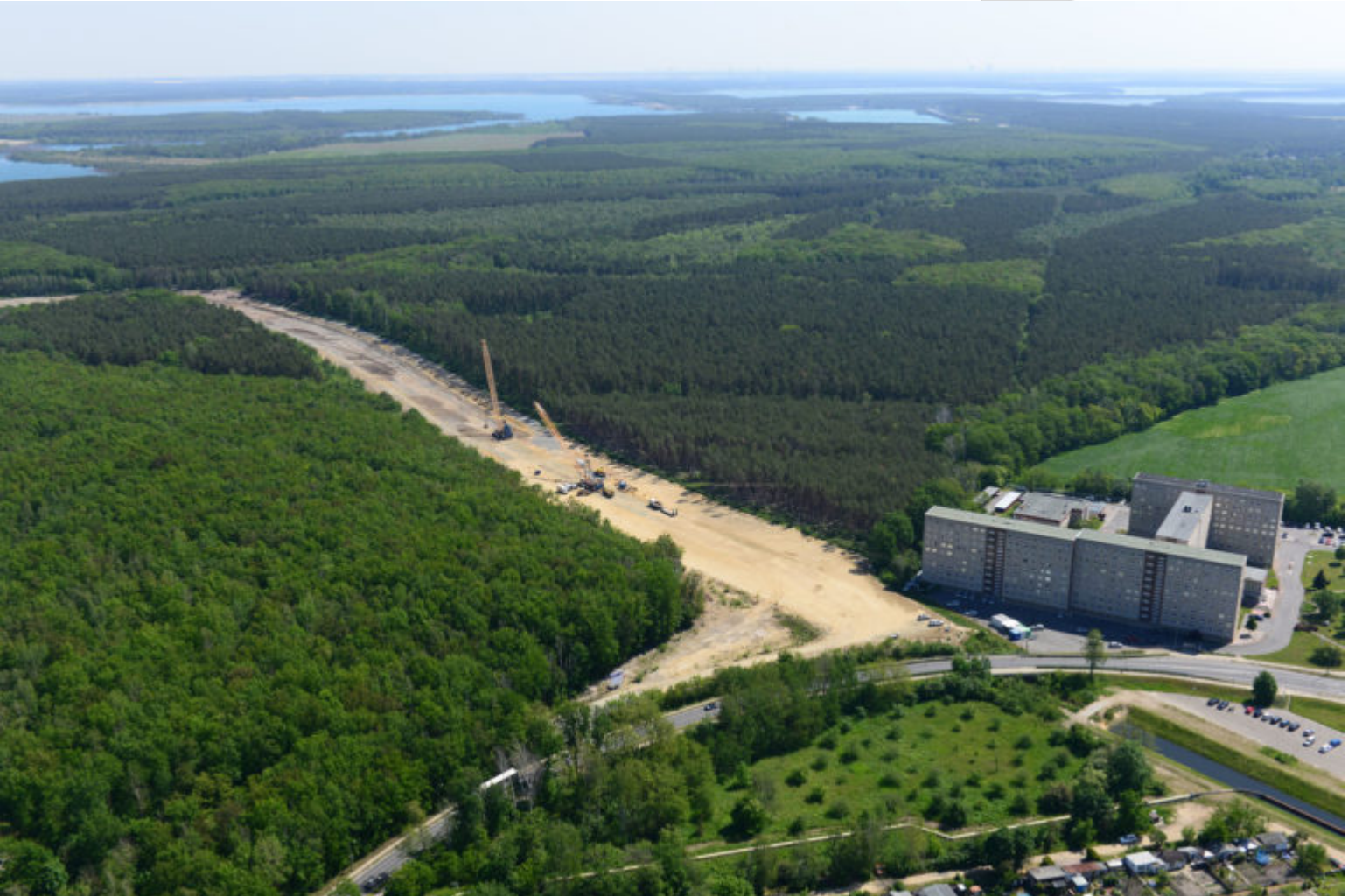
LMBV: Ableiter vom Sedlitzer See im Bau
