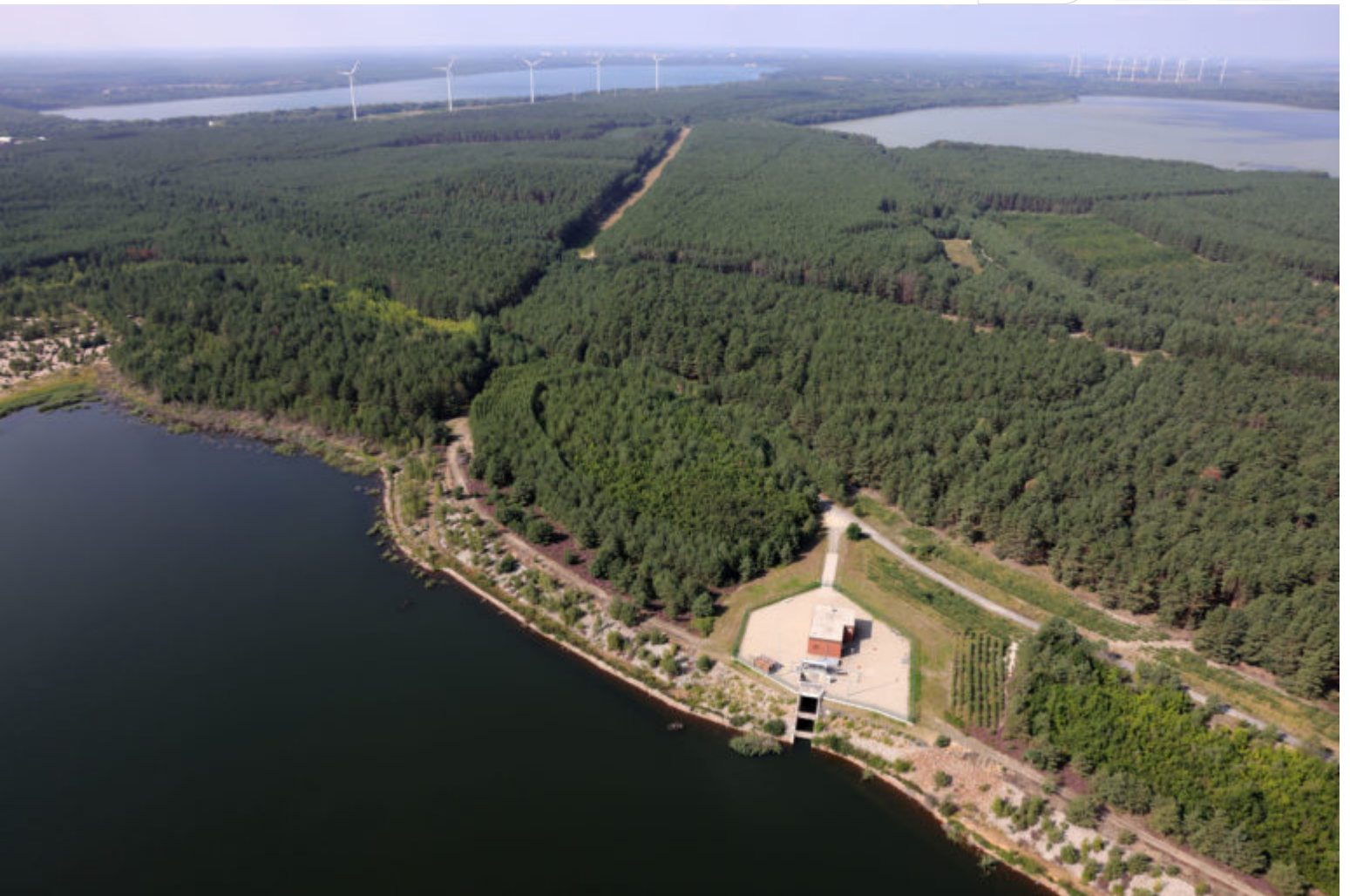
Einlaufbauwerk im SB Lohsa II
