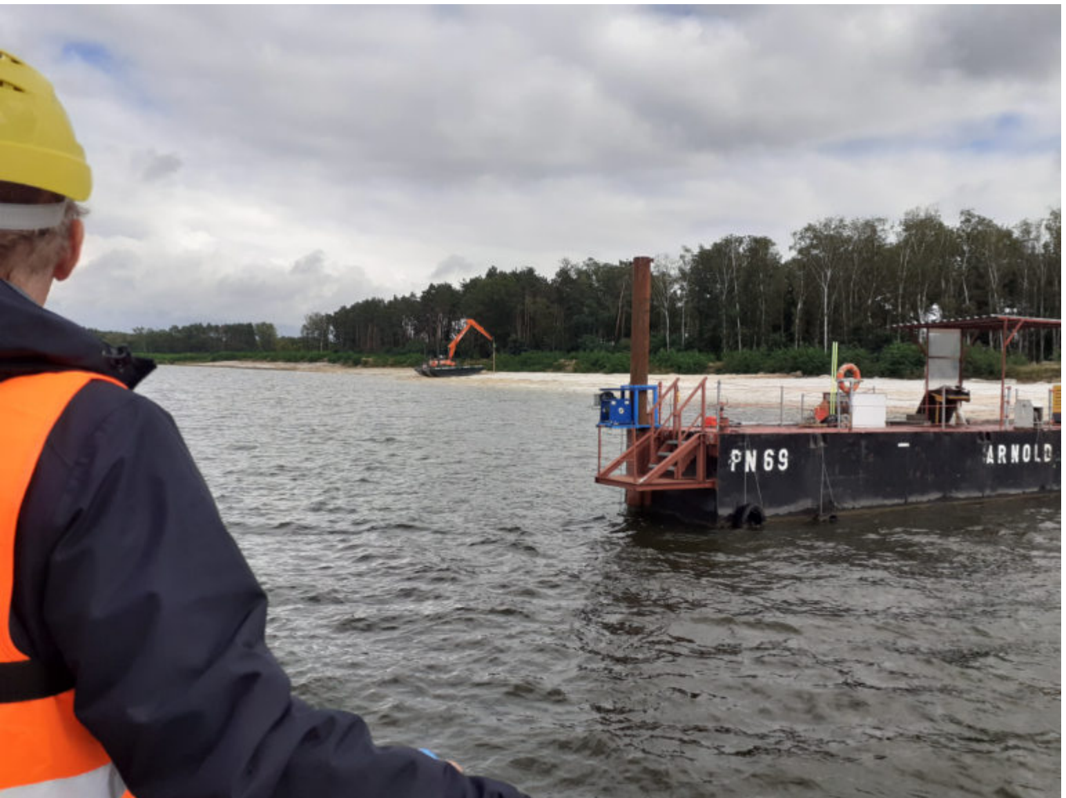
Verdichtungsarbeiten mit amphibischer Technik
