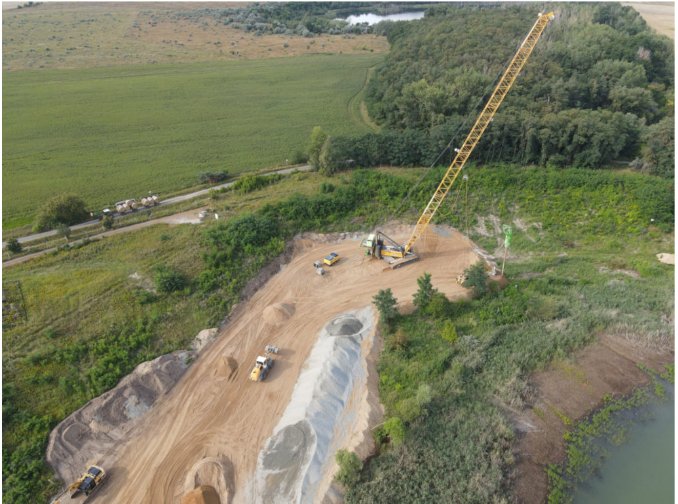
Blick über die Arbeiten am Restloch A
