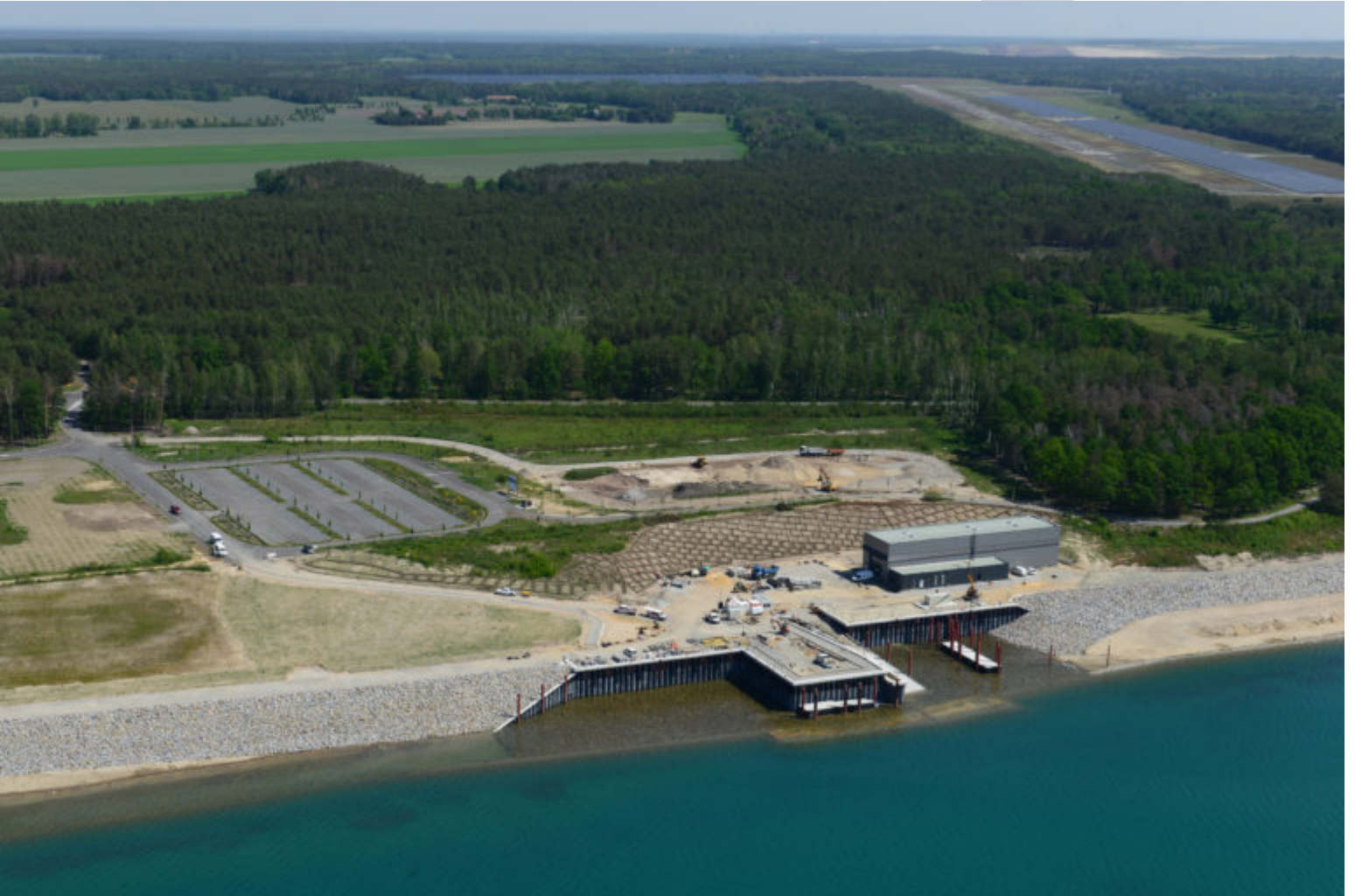
Sanierungsstützpunkt von oben (Juni 2021)
