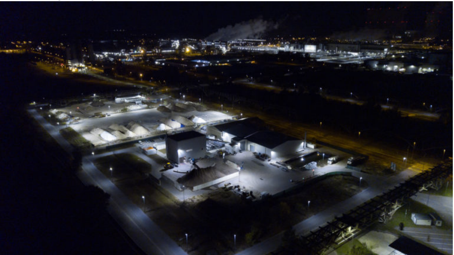
Vakuumthermische Reinigungsanlage Schwarze Pumpe
