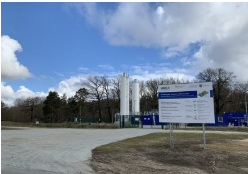
LMBV-Anlage bei Neustadt an der Spree
