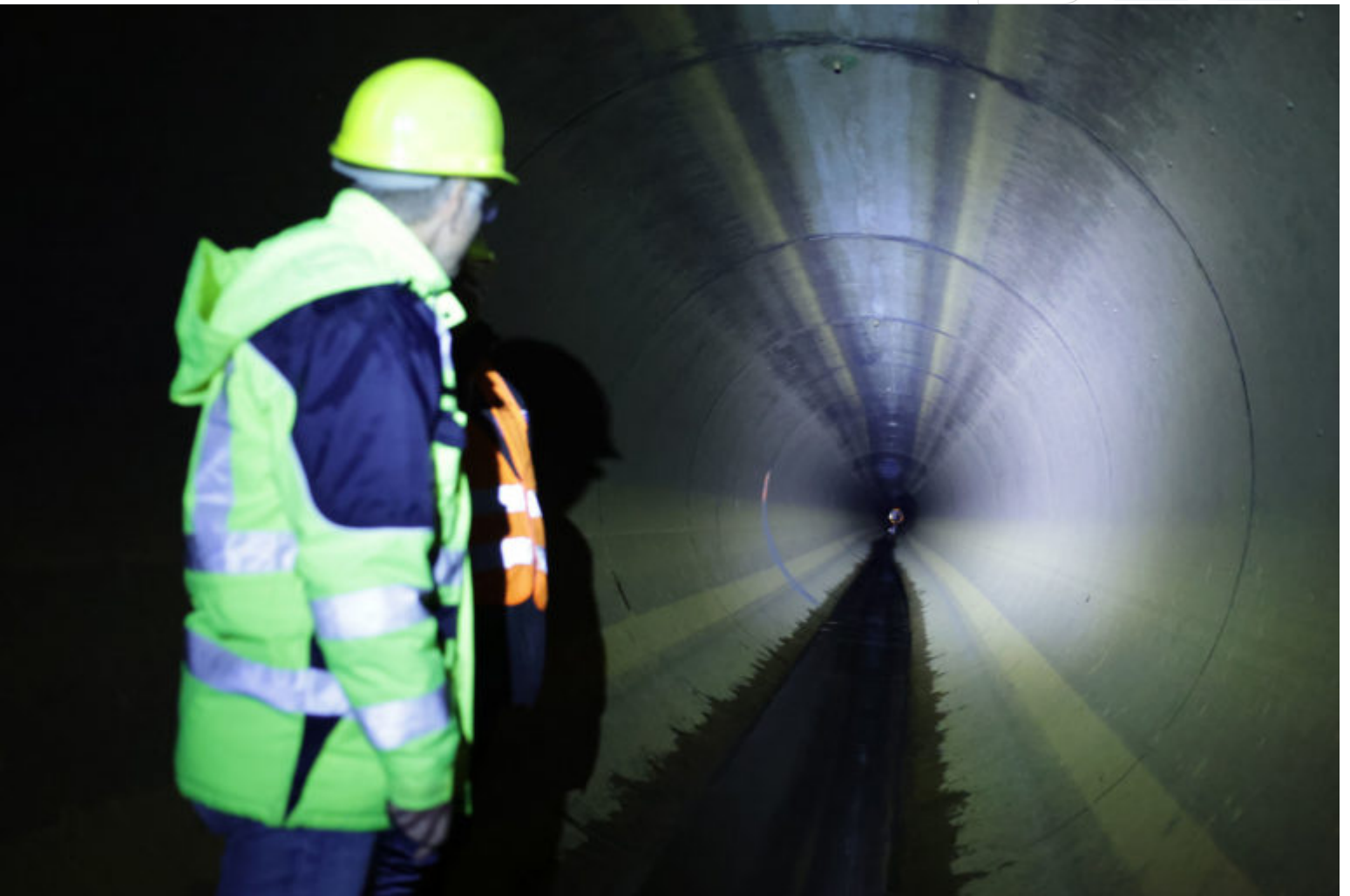
LMBV Überleiter Speicherbecken Lohsa II
