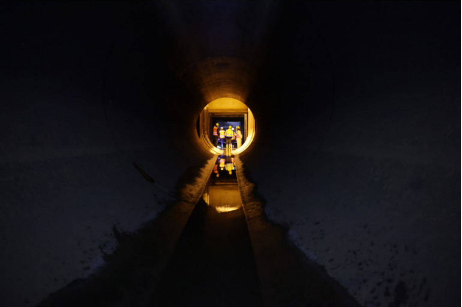
LMBV Überleiter Speicherbecken Lohsa II
