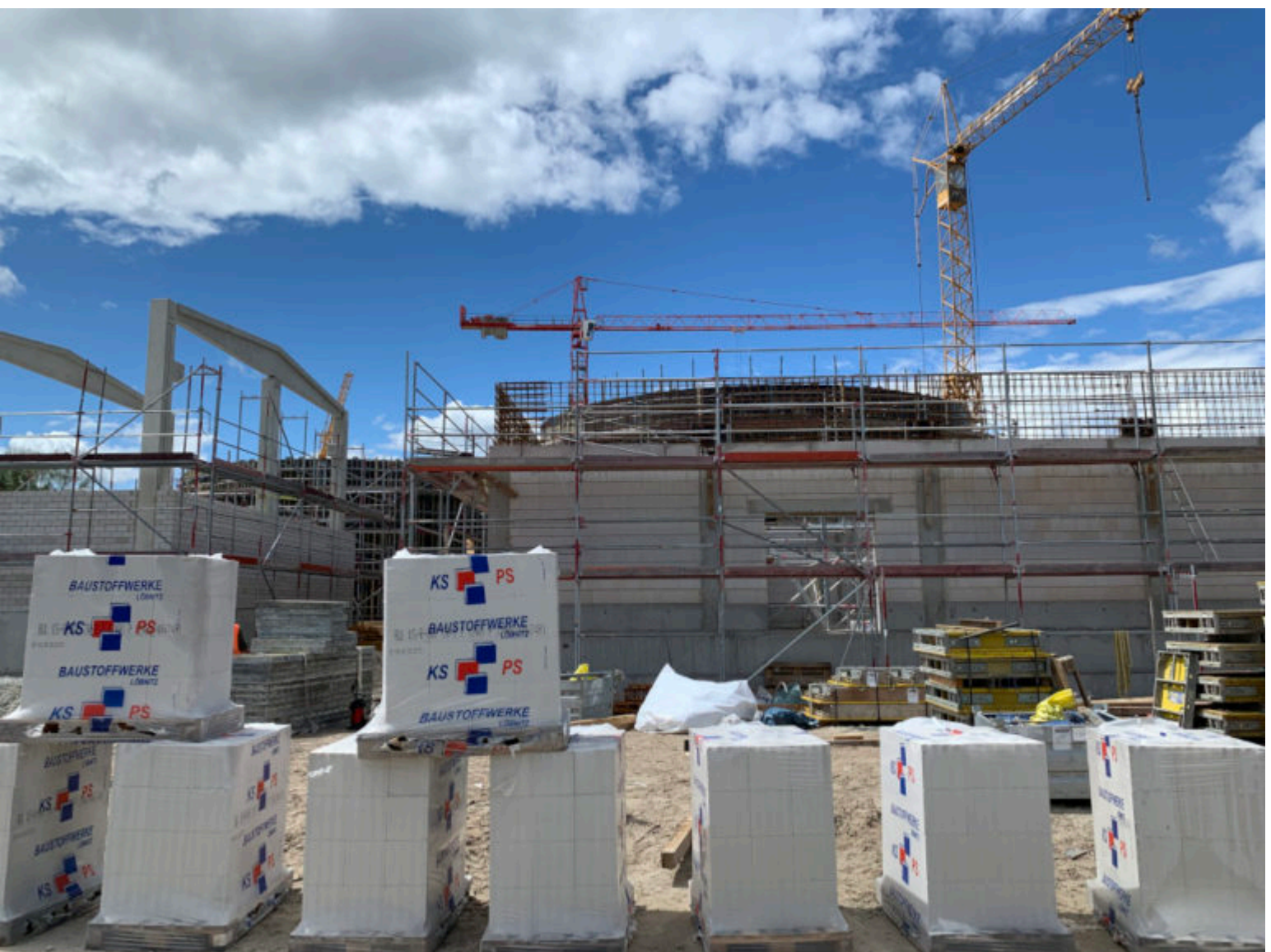
Blick auf die Baustelle
