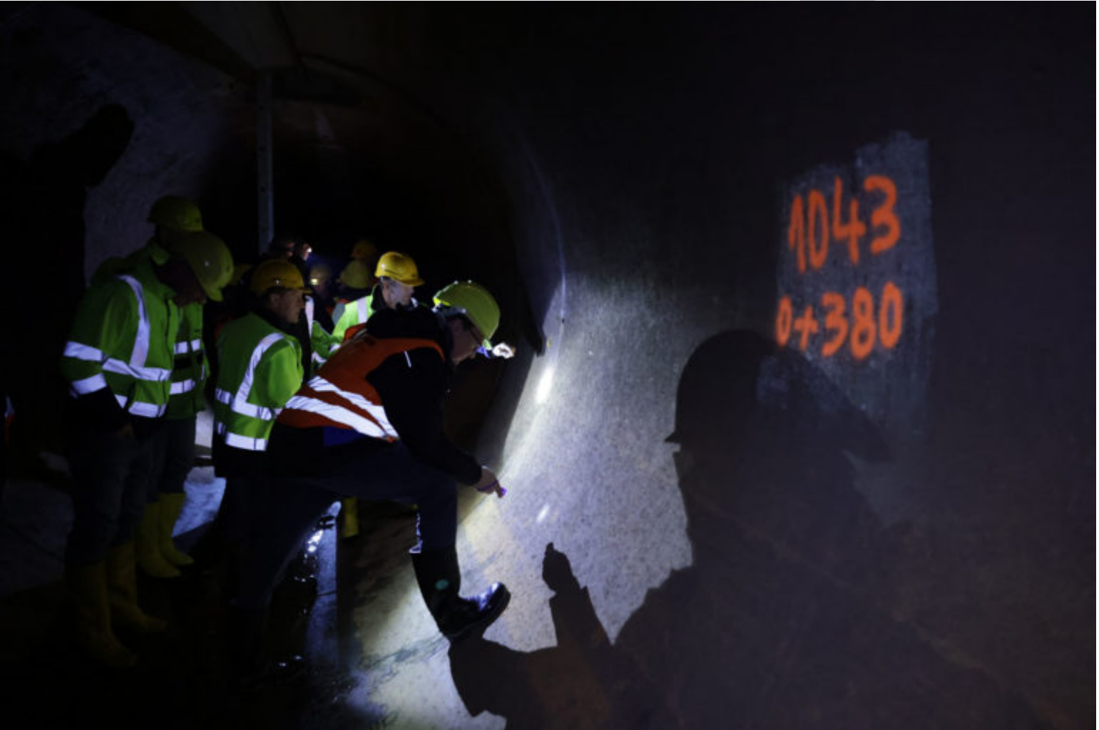
LMBV Überleiter Speicherbecken Lohsa II
