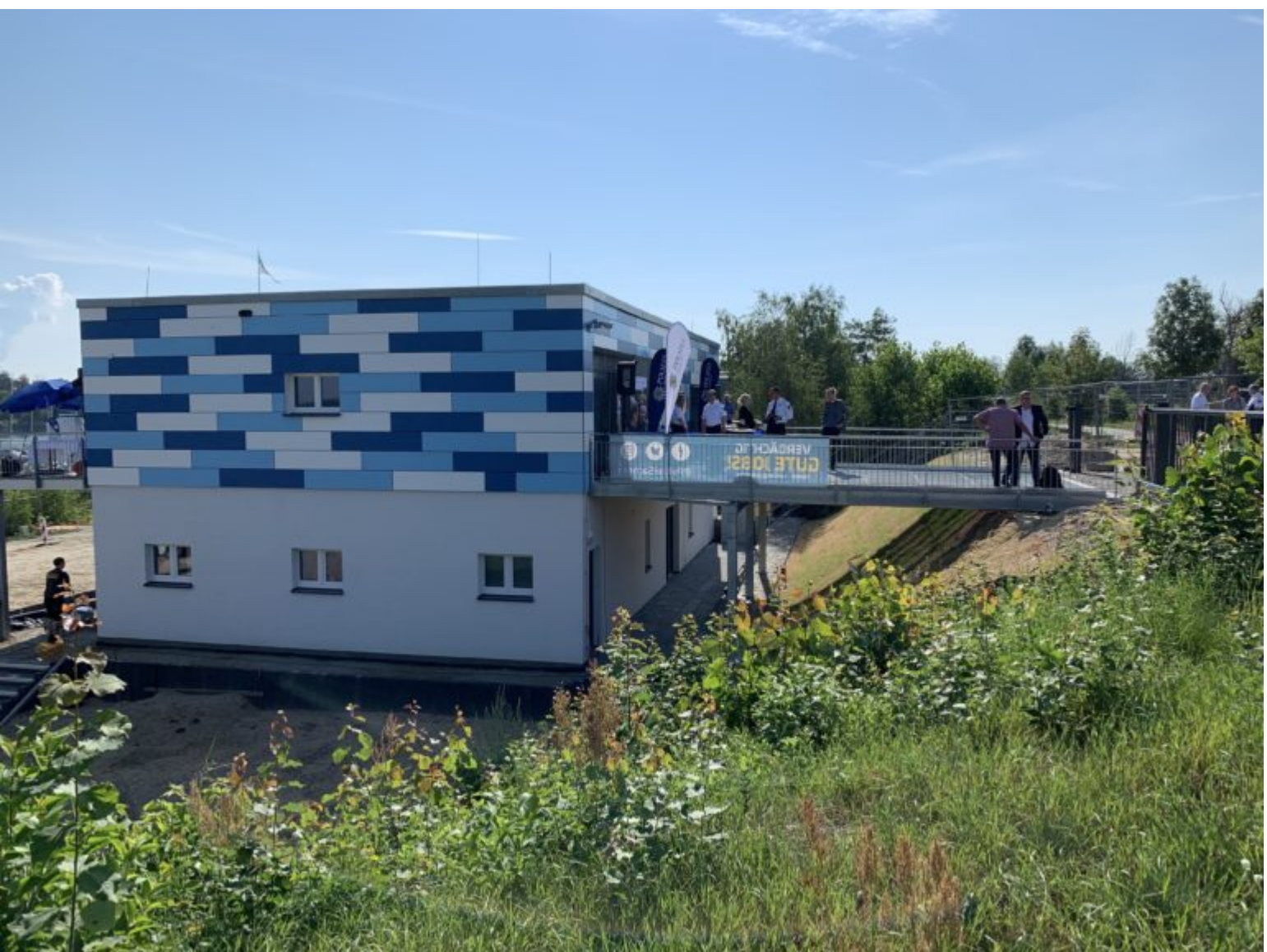
Die Polizeiwache im Gebäude des ZV LSS
