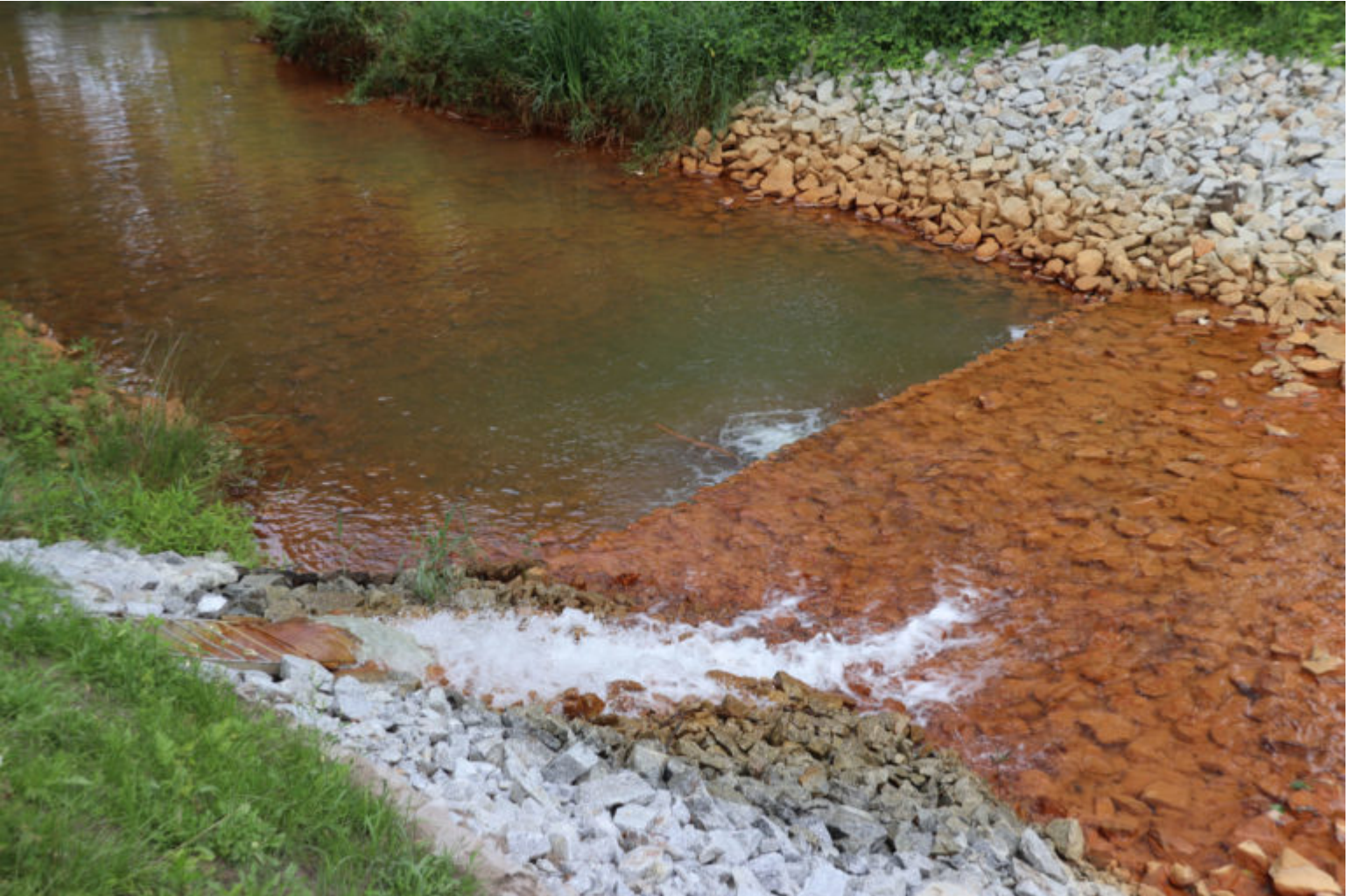
Gereinigtes Wasser strömt aus der Anlage
