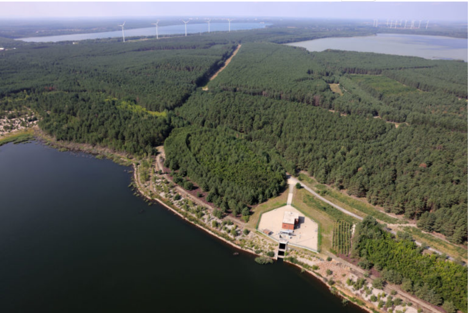
Einlaufbauwerk im SB Lohsa II
