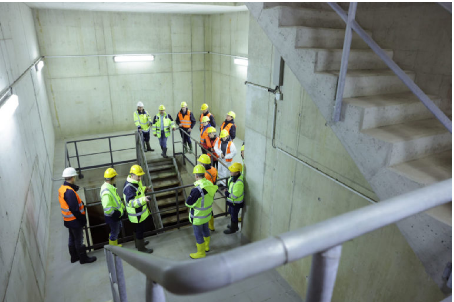
LMBV Überleiter Speicherbecken Lohsa II
