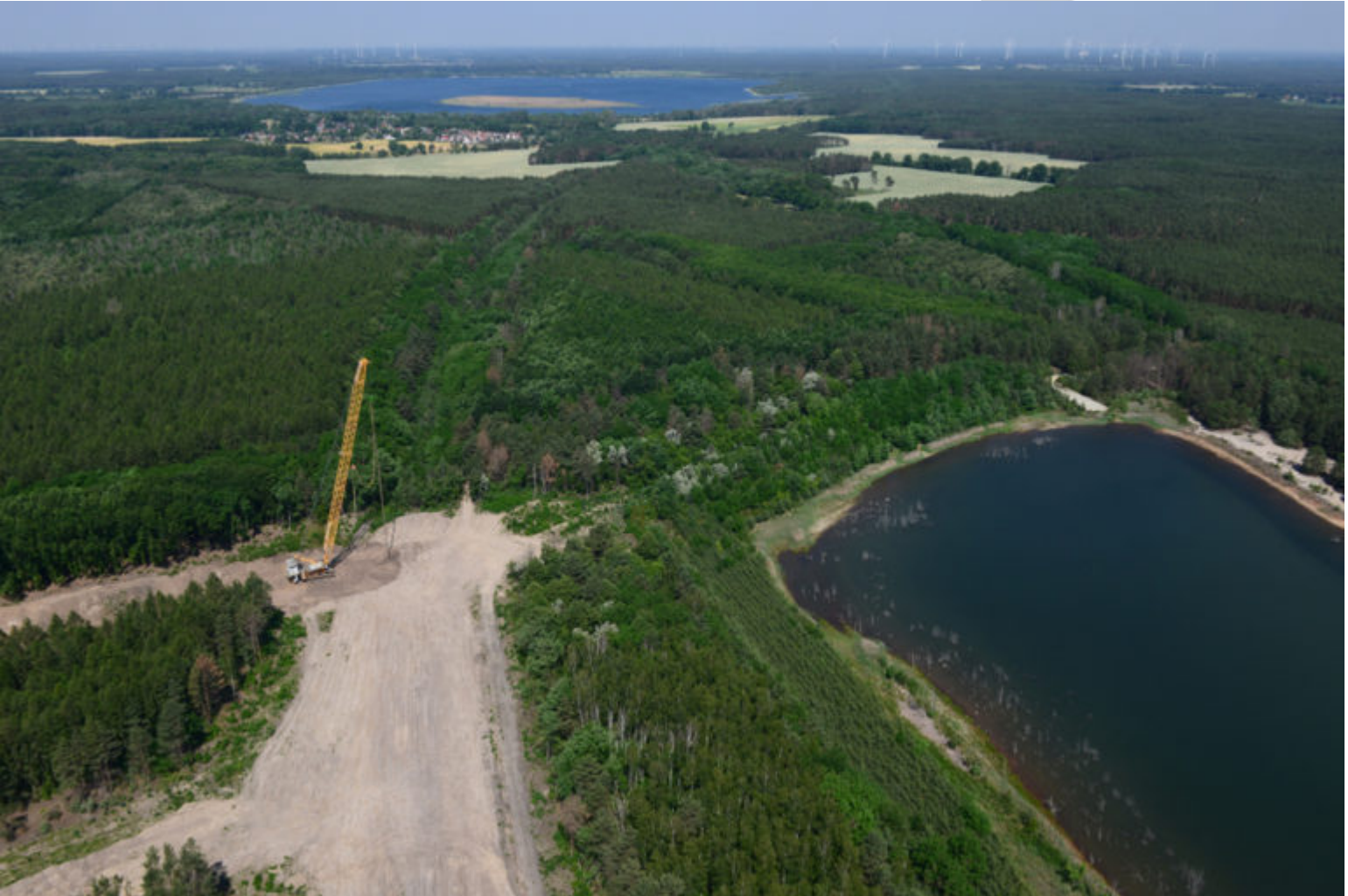
Rütteldruckverdichtung Kippe 10
