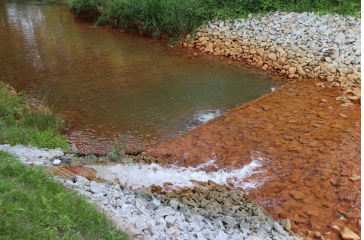
Gereinigtes Wasser strömt aus der Anlage
