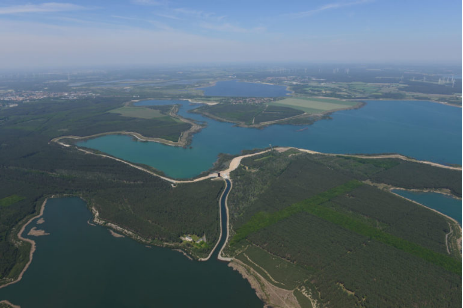
LMBV-Bergbaufolgeseen: Sornoer Kanal zw. Sedlitzer See und Geierswalder See
