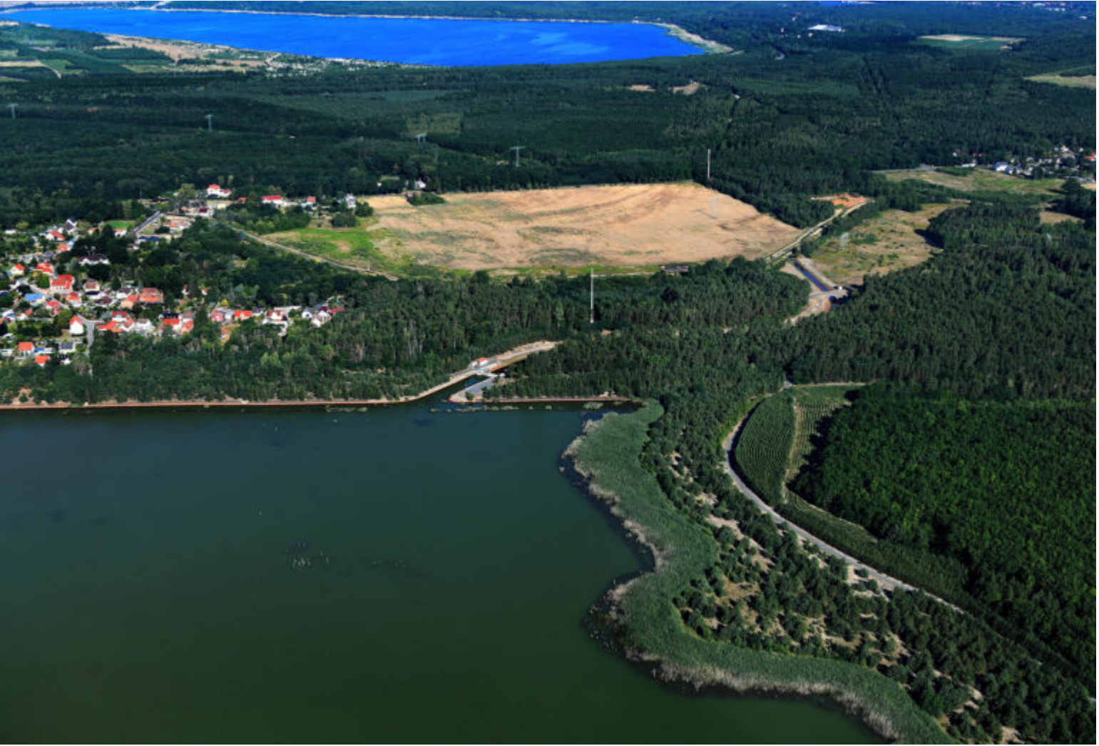
Auslaufbauwerk aus dem SB Burghammer
