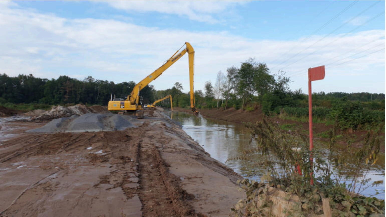
Einseitiger Ausbau der Kleinen Spree
