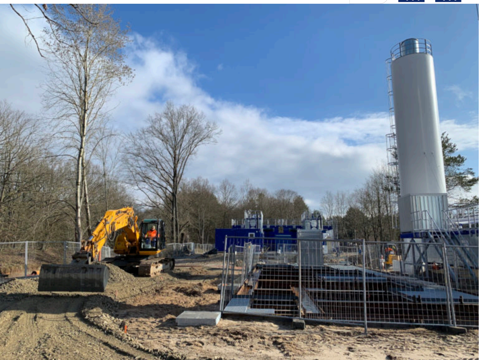
Baufortschritt auf der MWBA-Baustelle
