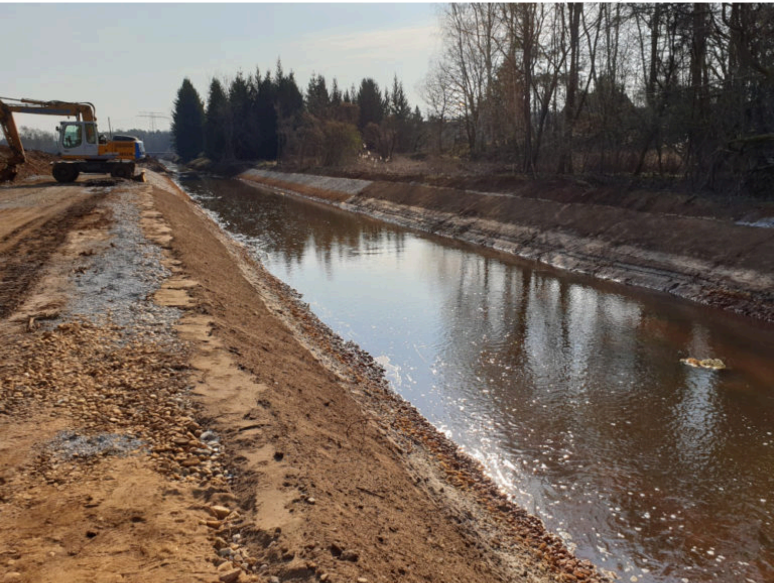
Uferausbau an der Kleinen Spree
