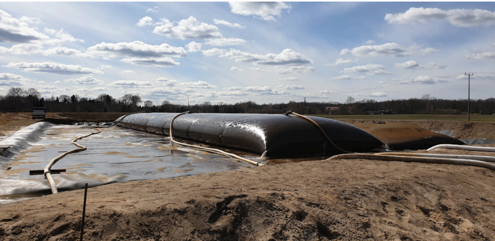
Aufnahmebehälter aus Geotextil für abgesaugten Schlamm aus Kleiner Spree
