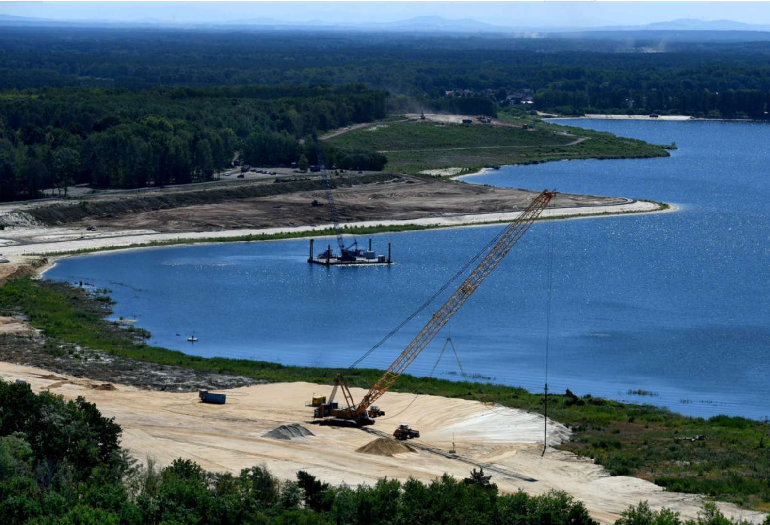
Landseitige und seeseitige RDV-Technik am Knappensee im Einsatz - 2020
