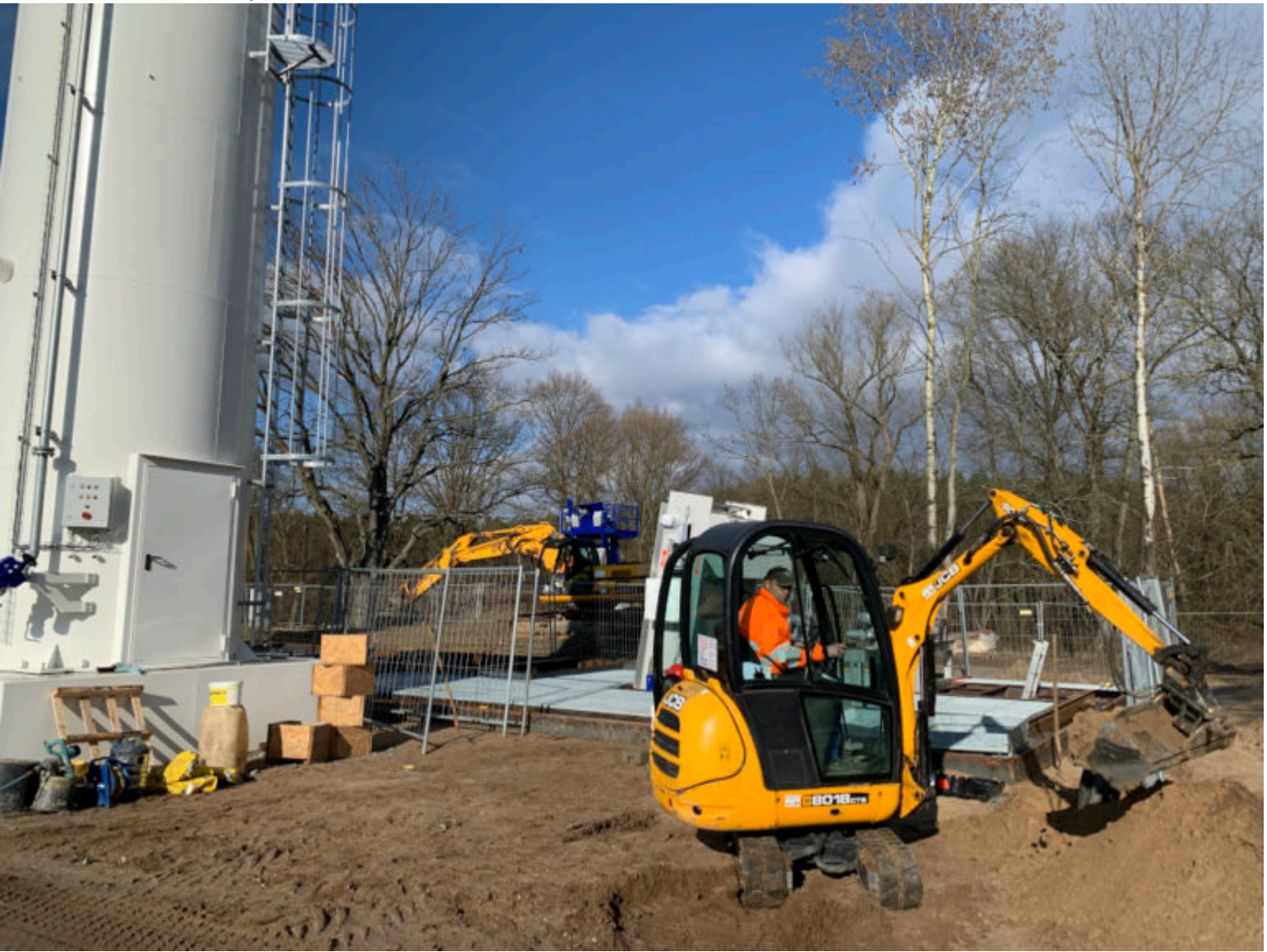
MWBA Ruhlmühle – Erdarbeiten
