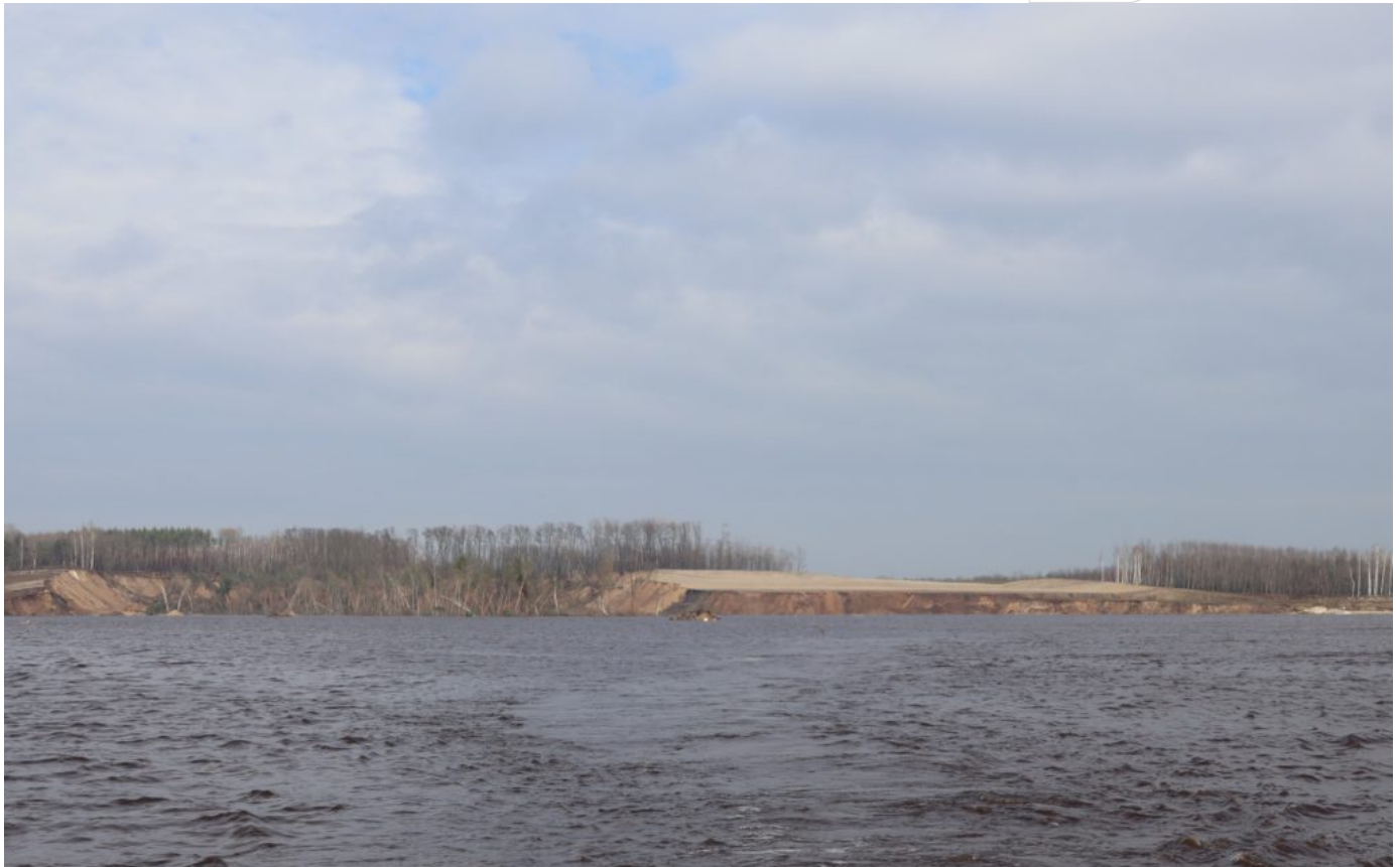
Archivaufnahme der Sanierung
