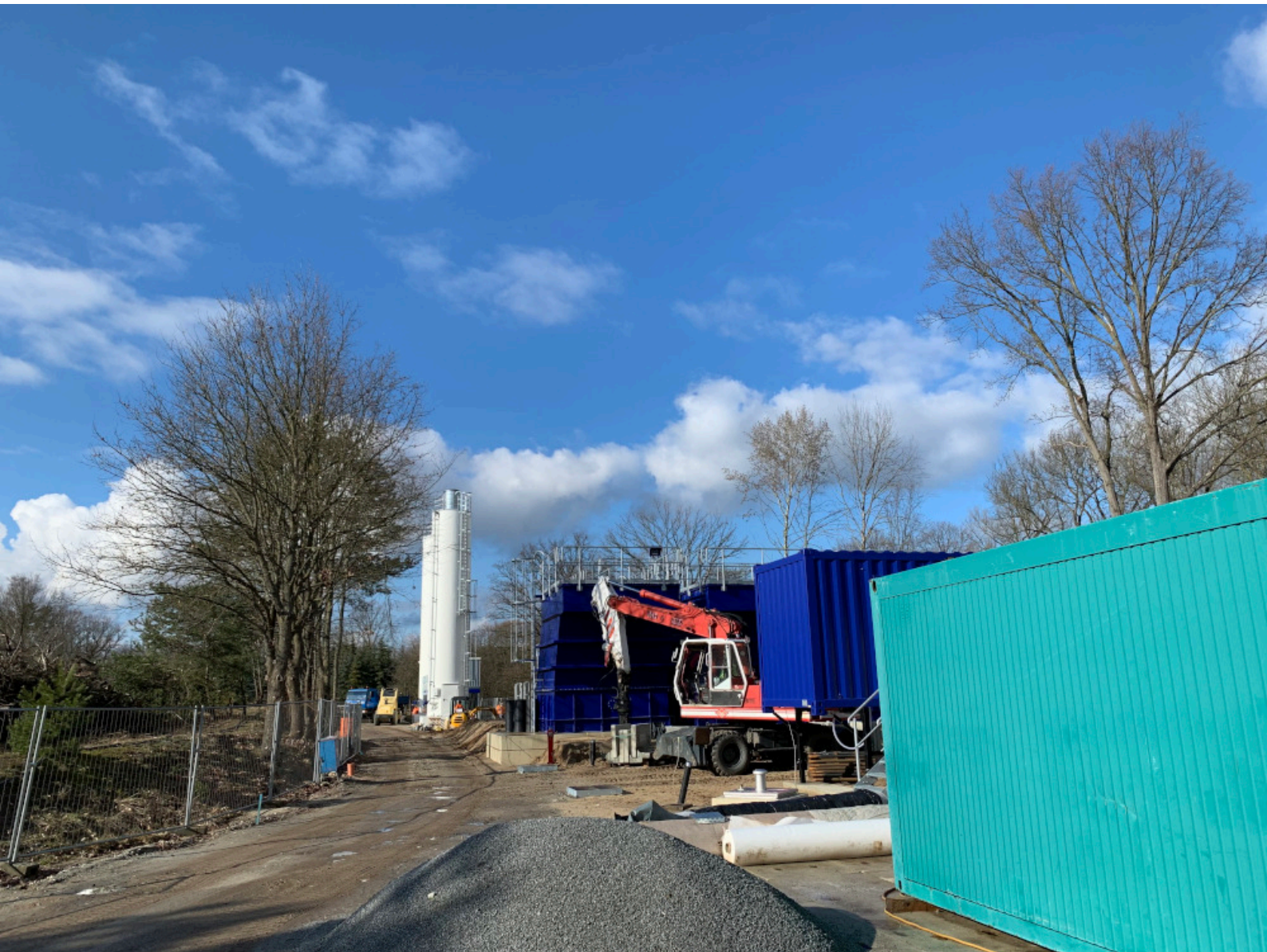
Endspurt auf der Baustelle der MWBA Ruhlmühle
