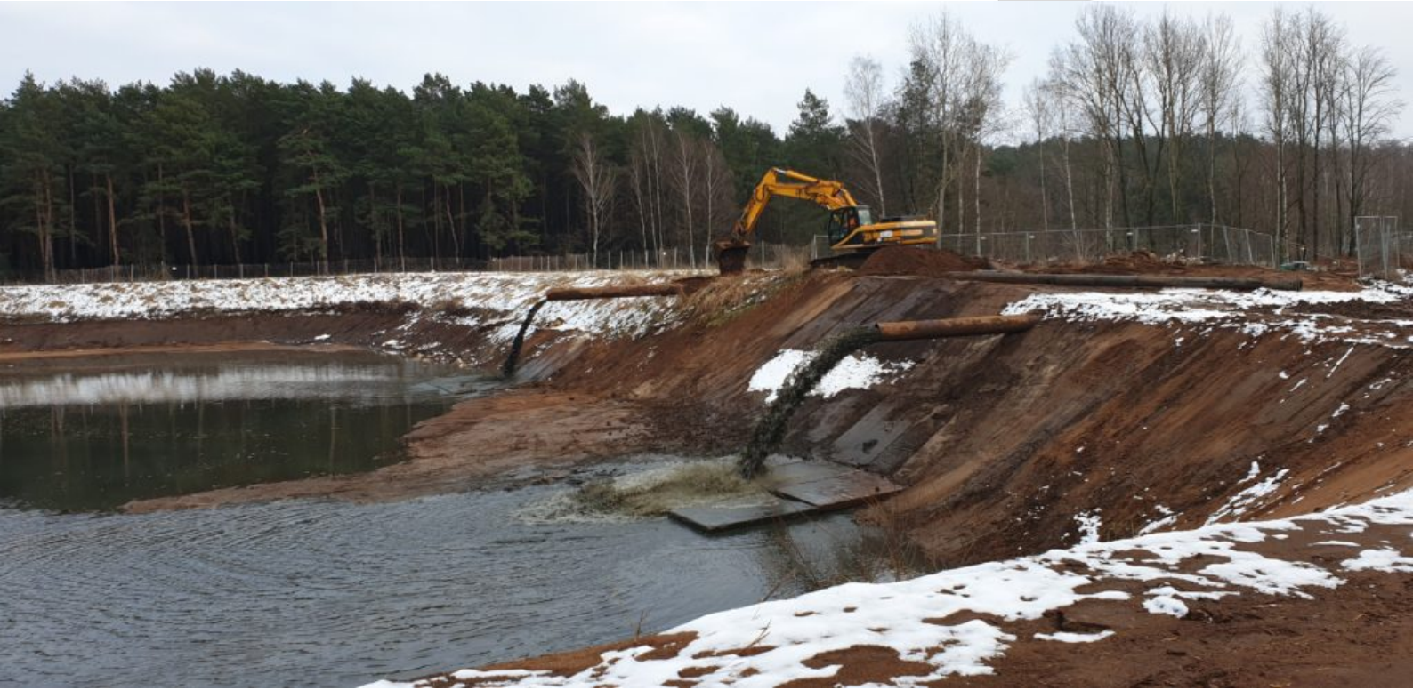
Das Einspülen in des Sedimentationsbecken begann am 25.01.2021
