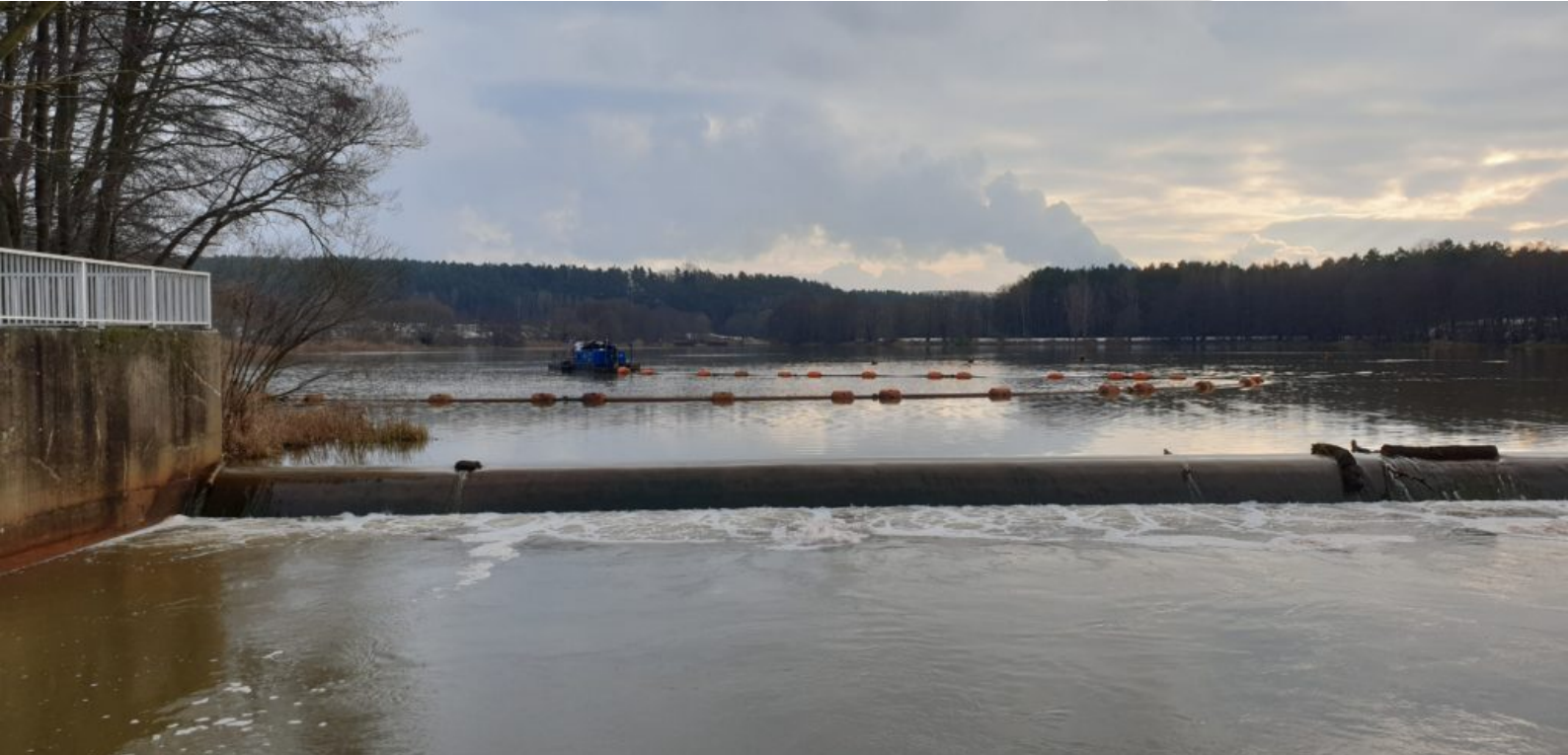
Blick auf die Vorsperre Bühlow
