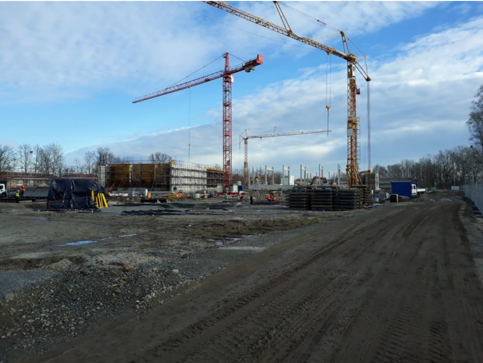
Sichtbarer Baufortschritt auf der Baustelle der WBA Plessa
