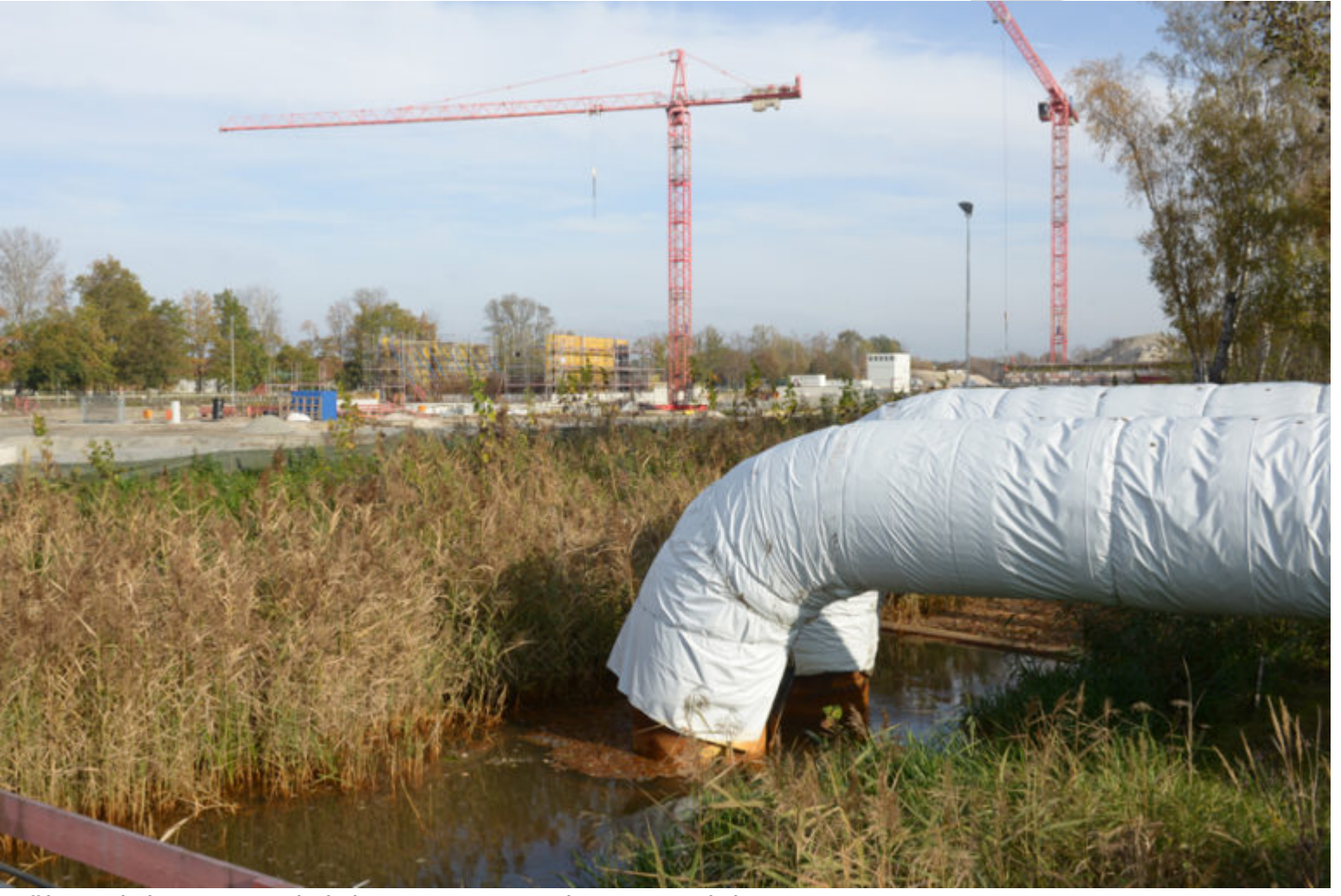
Während des Baus wird der Hammergraben umgeleitet.
