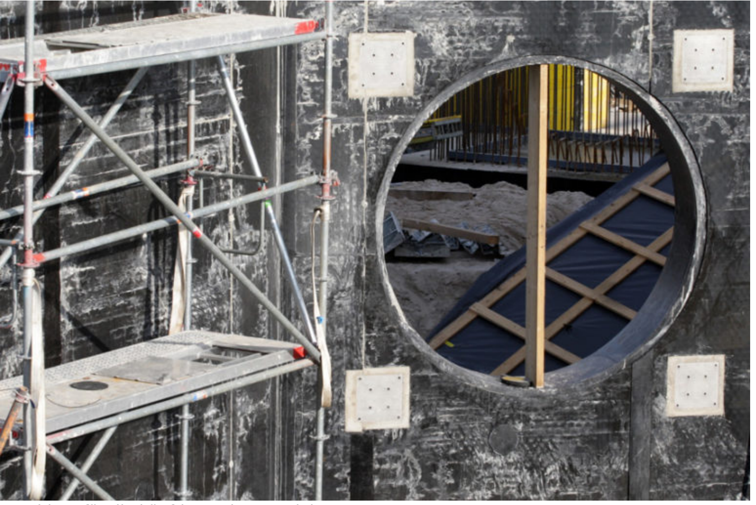
Durchlass für die künftige Rohwasserleitung
