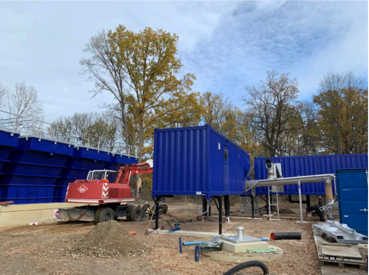
Modulare Bauweise | Ruhlmühl-Baustelle
