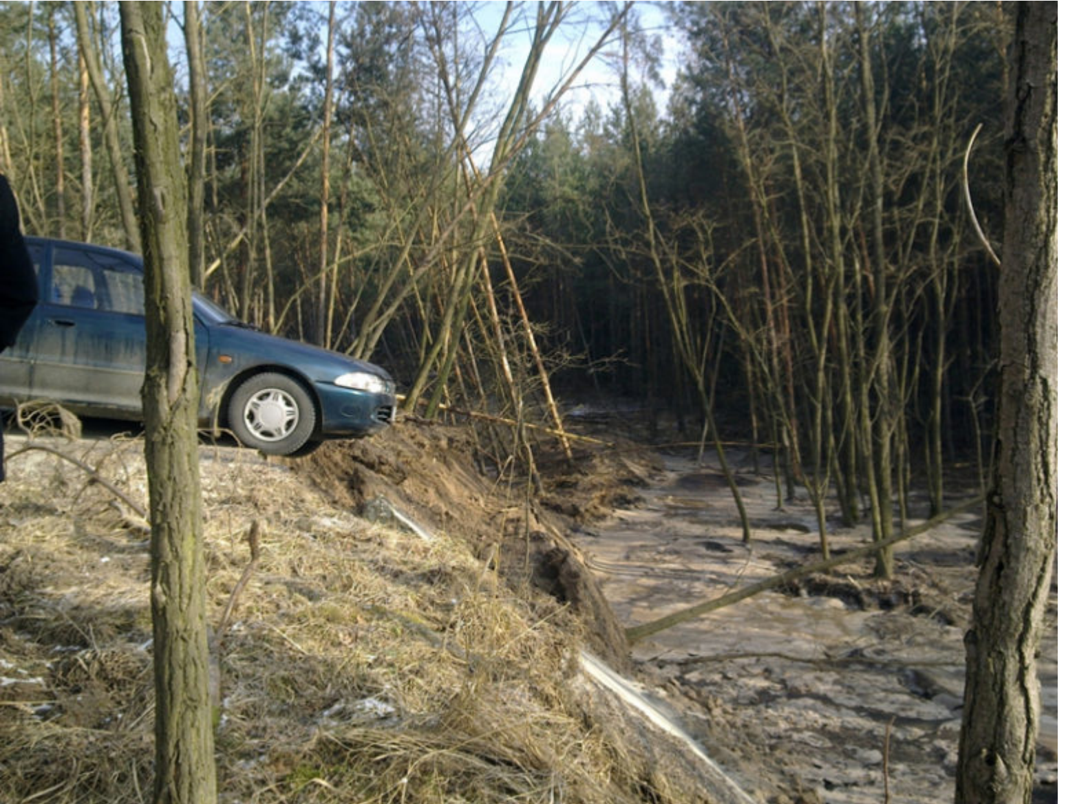
Symbolfoto: Rutschung 2016 in Sperrgebiet
