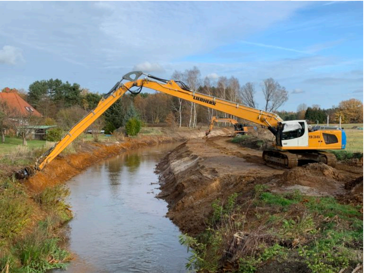
Blick von der Brücke: Ausbau der Kleinen Spree in Burgneudorf Mitte Nov. 2020
