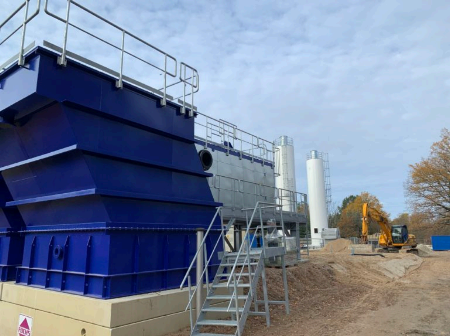
Sichtbarer Baufortschritt | MWBA Ruhlmühle
