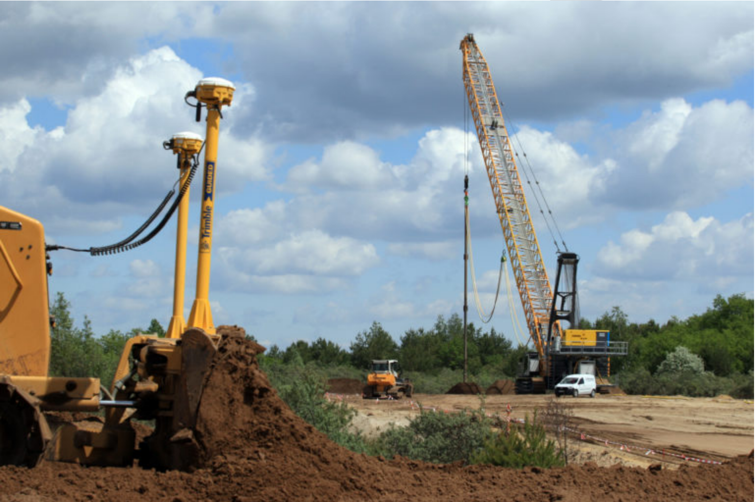
Altdöbern Sanierungsarbeiten im Auftrag der LMBV am Altdöberner See
