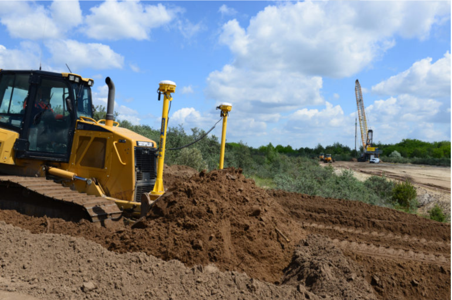
Planierarbeiten am Böschungssystem
