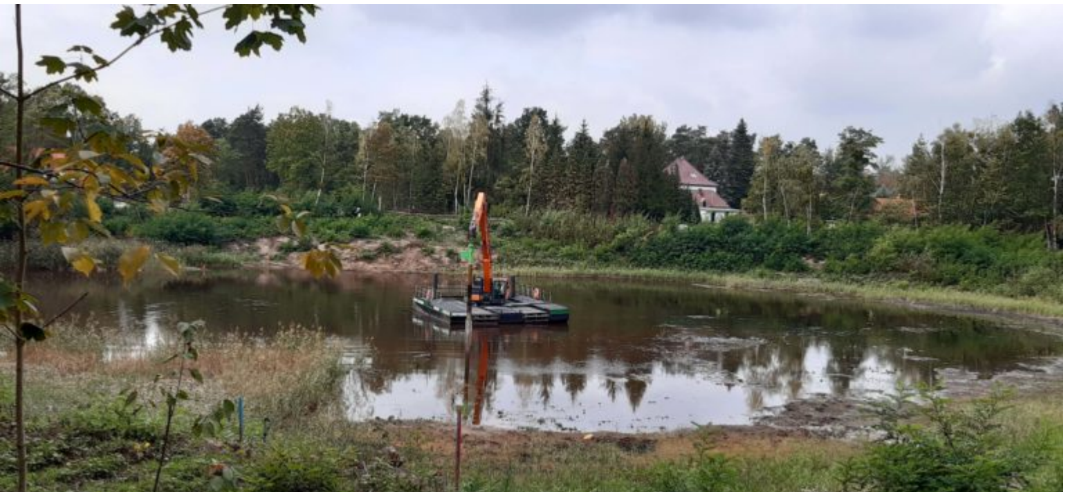
Der Rüttler arbeitet auf der Wasserfläche von Neumanns Grube
