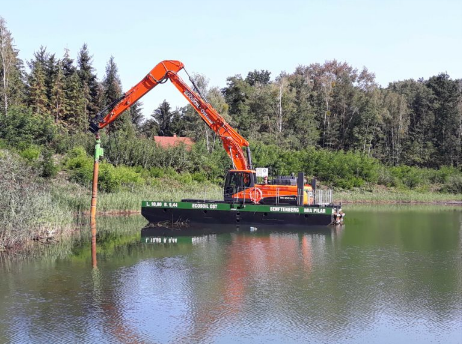
Mittels amphibischer Technik wird Neumanns Grube gesichert
