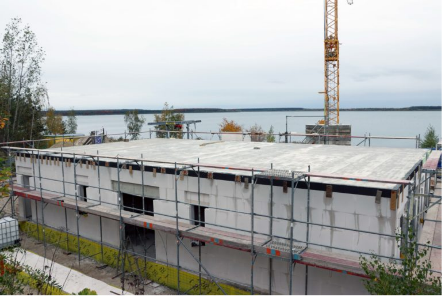
Der Rohbau des neuen Multifunktionsgebäudes
