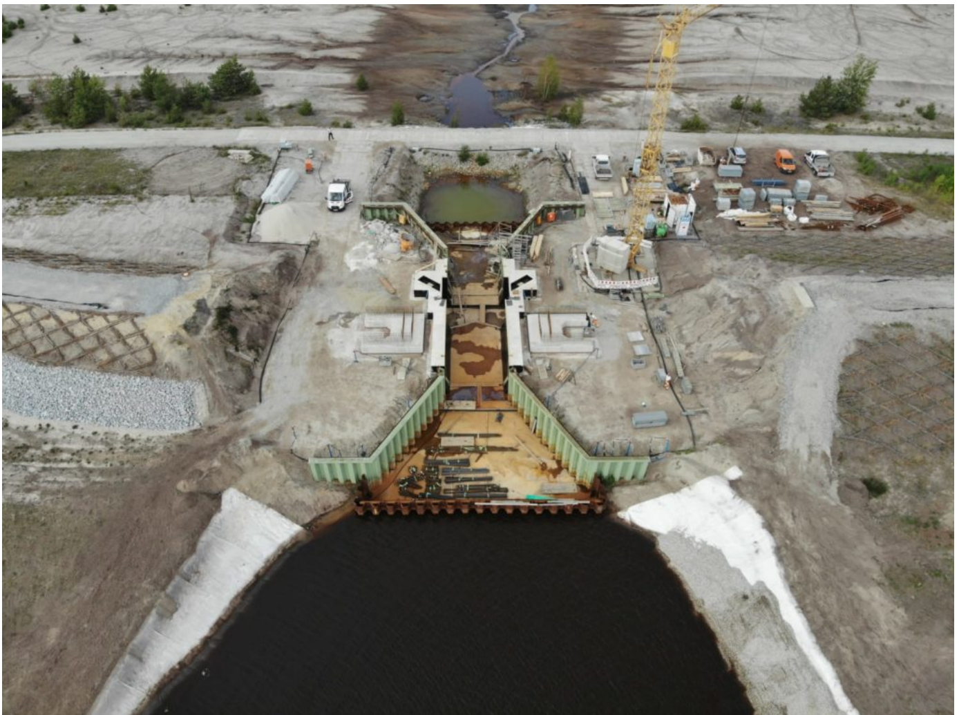
Impressionen vom Bauvorhaben Überleiter 3 a
