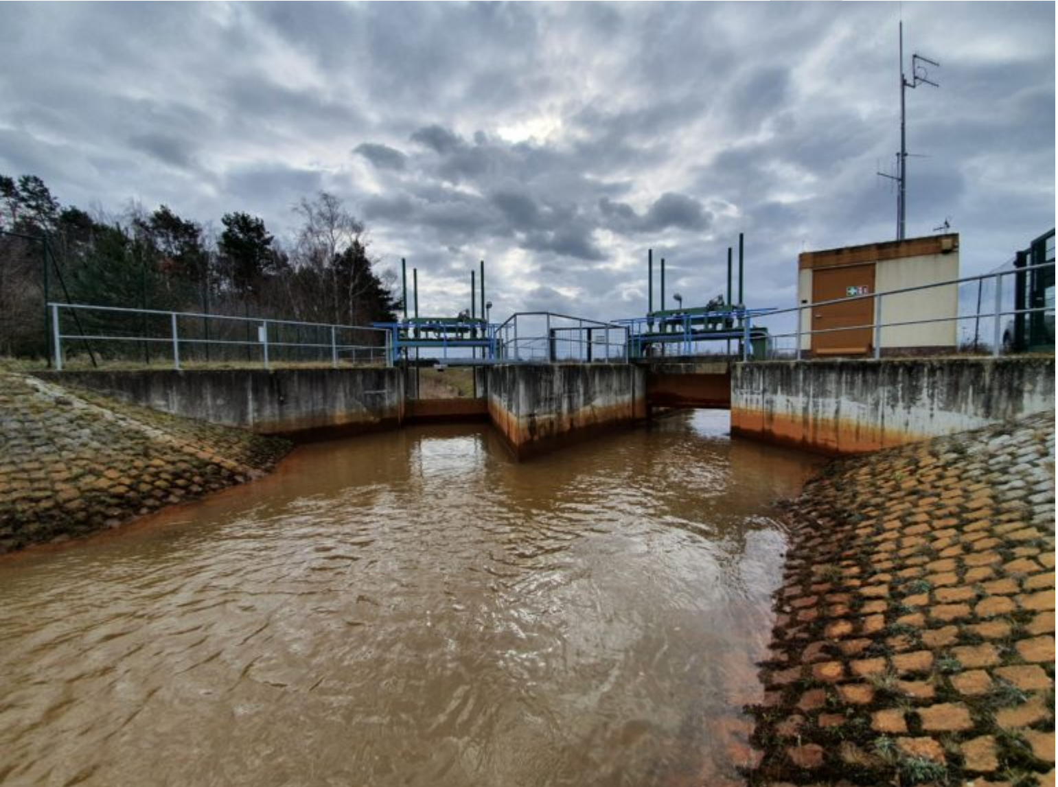
Wasserwirtschaftliche Anlage: Verteilerwehr Bluno
