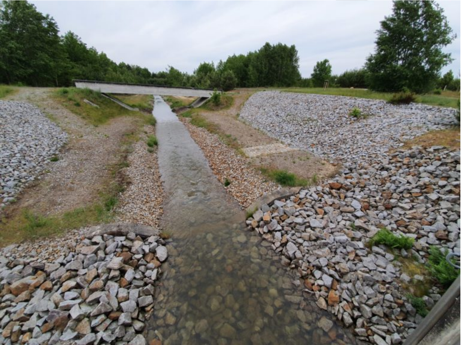
Ableiter aus dem Bergbaufolgesee und Speicher Bärwalde
