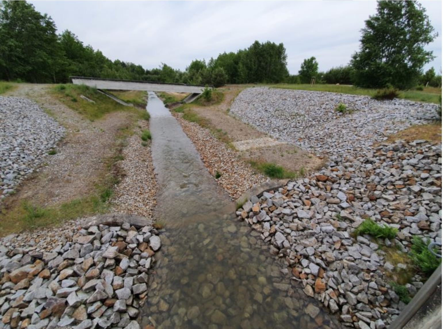
Ableiter aus dem Bergbaufolgesee und Speicher Bärwalde
