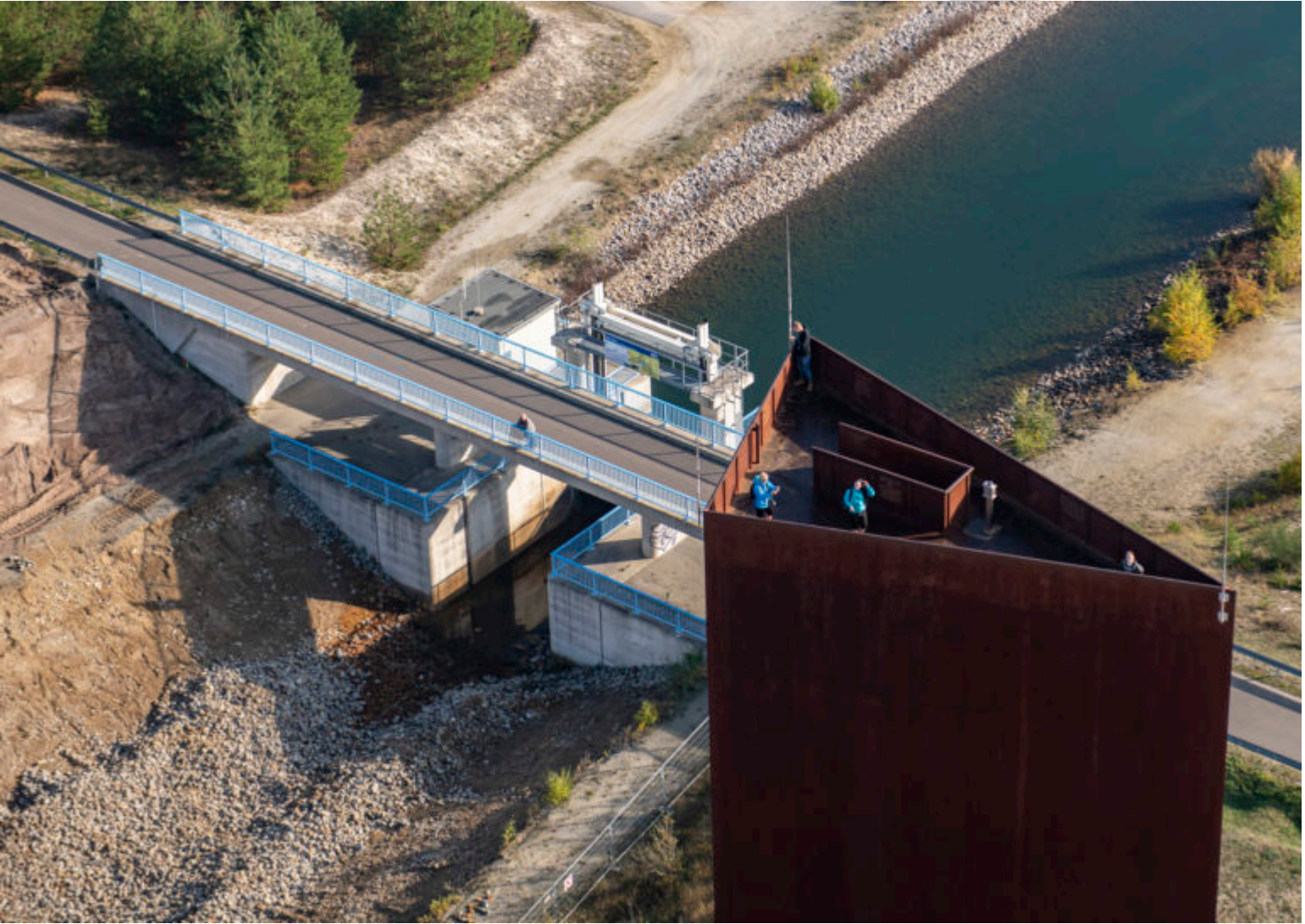
Künftig mit zu steuern: Wehranlage im Rosendorfer Kanal
