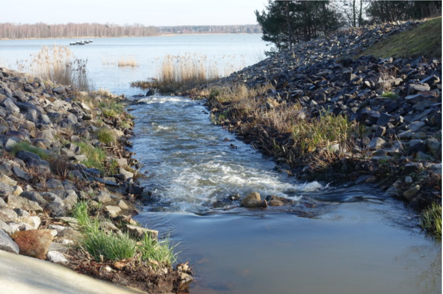
Flutungswasser aus der Kleinen Spree für das Restloch Burghammer
