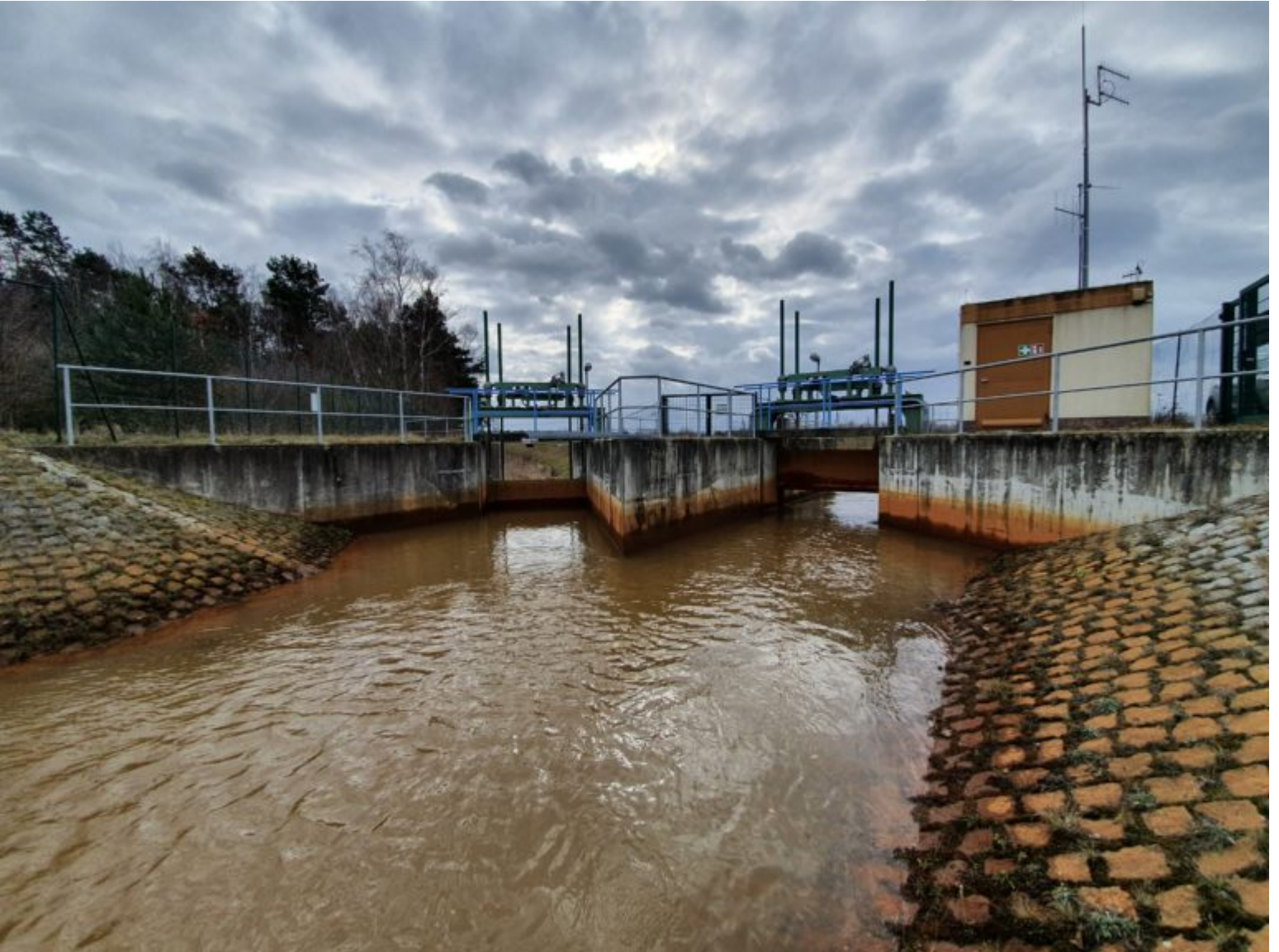
Wasserwirtschaftliche Anlage: Verteilerwehr Bluno
