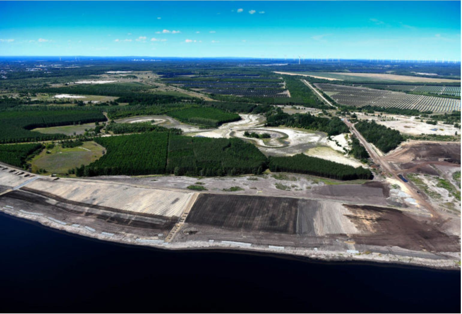
Böschungssicherung RL Meuro
