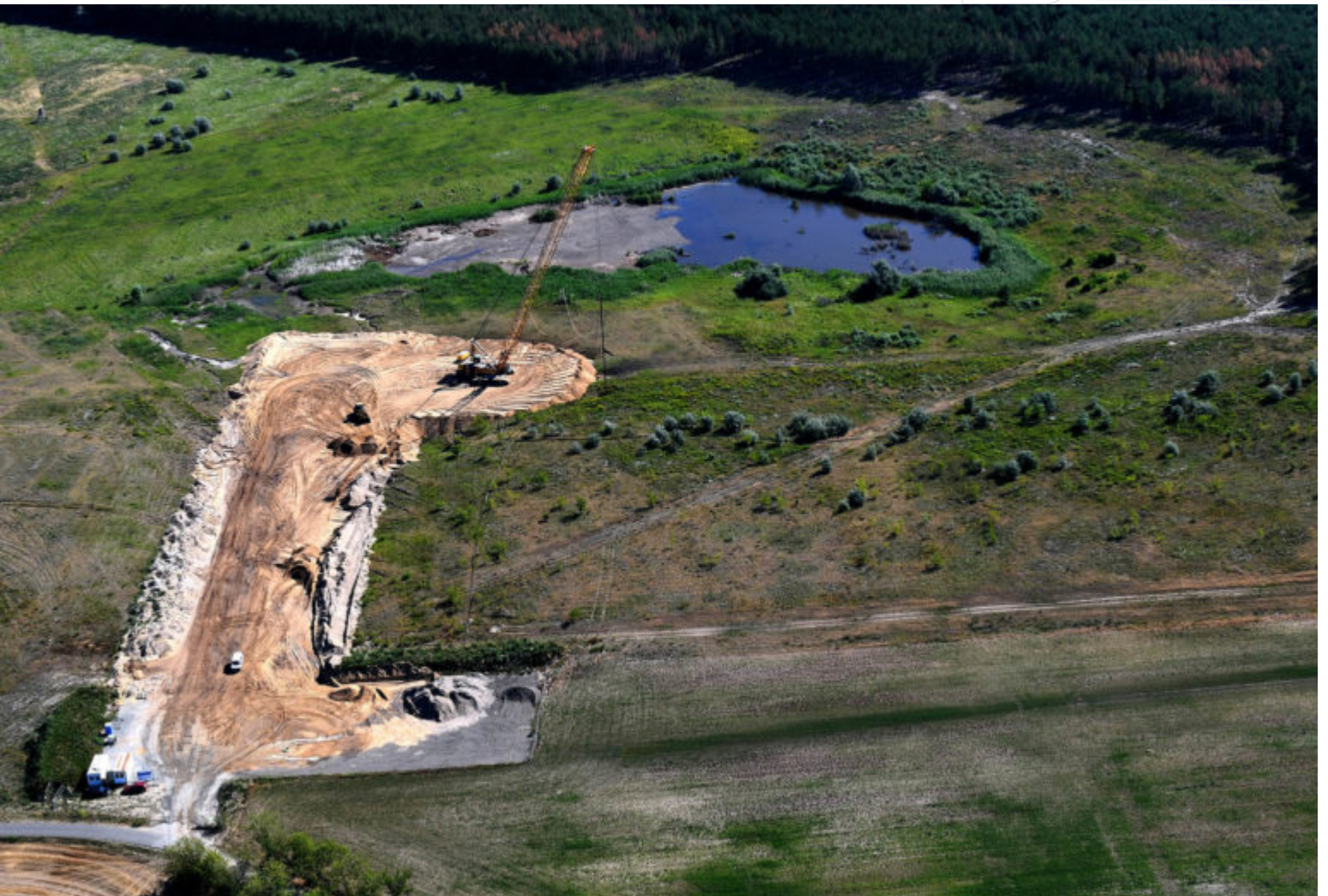
Verdichtung von Instabilitäten
