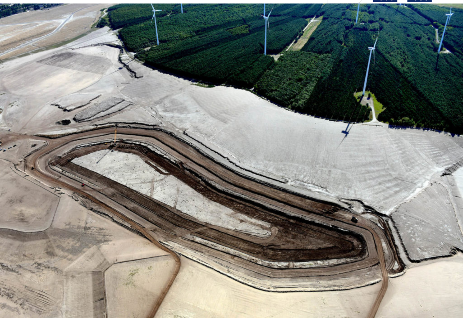
Verichtung der Inselufer im künftigen Cottbuser Ostsee
