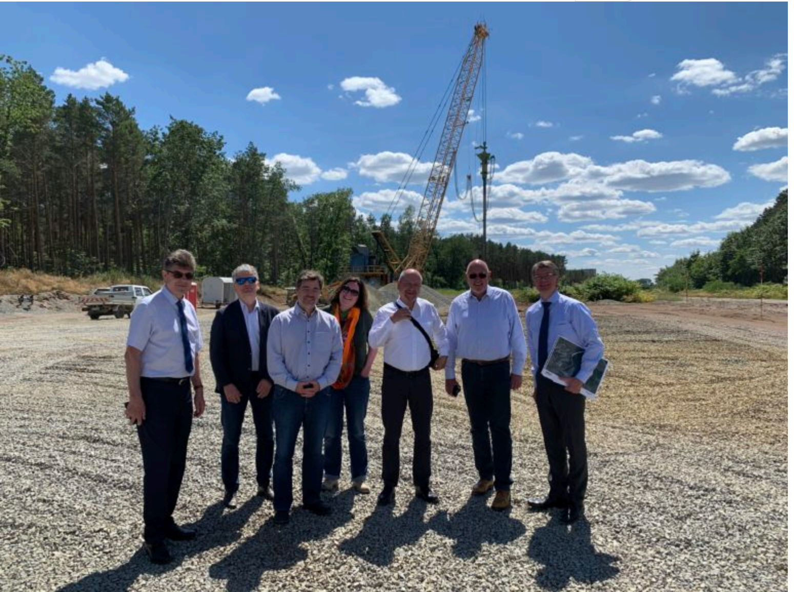
Aus der Entfernung: Rüttelstopfen
