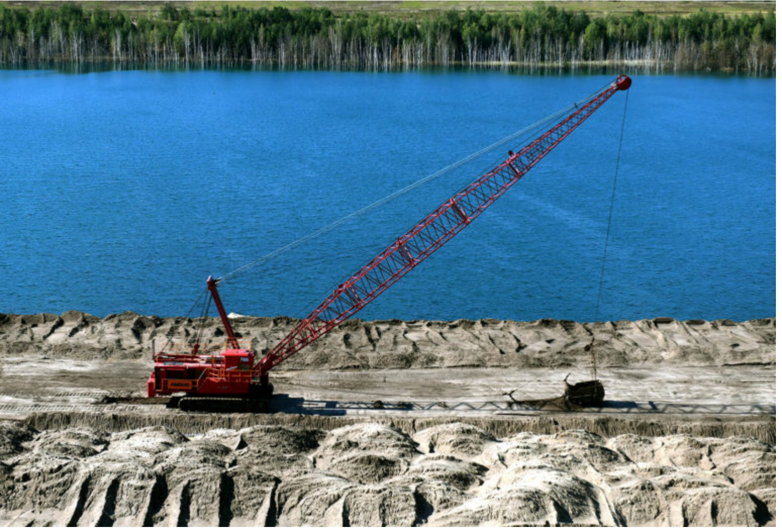
Seilbagger am Ufer des Klinger Sees
