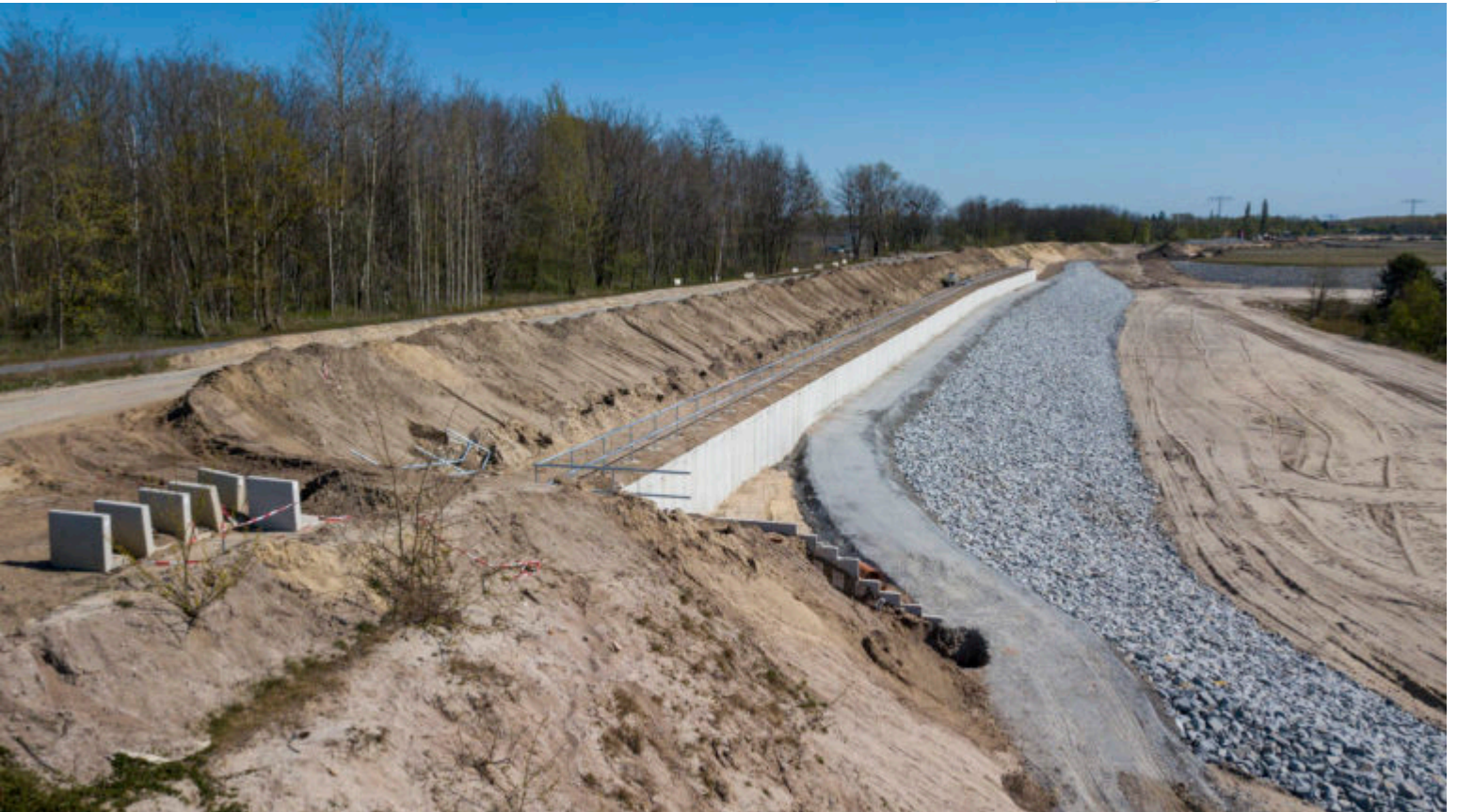
Erfolgter Uferverbau – Sedlitzer See
