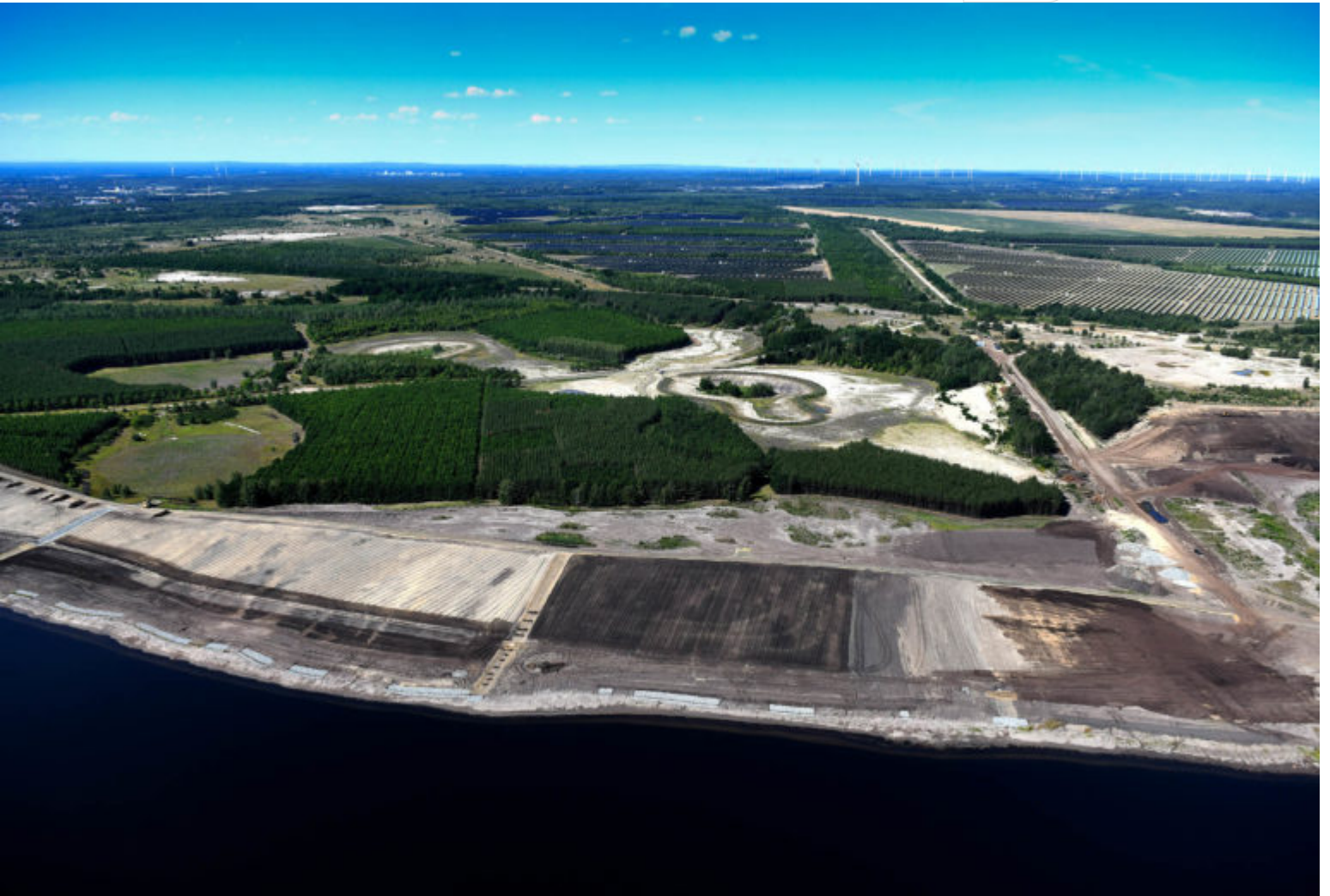
Böschungssicherung RL Meuro
