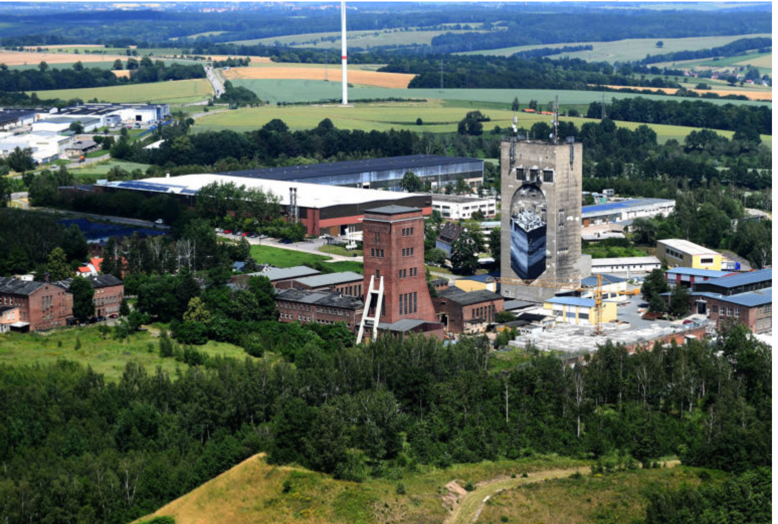
Förderturm des Martin-Hoop-Schachtes IV (Ziegelbau), der sich im Grundeigentum der LMBV befindet
