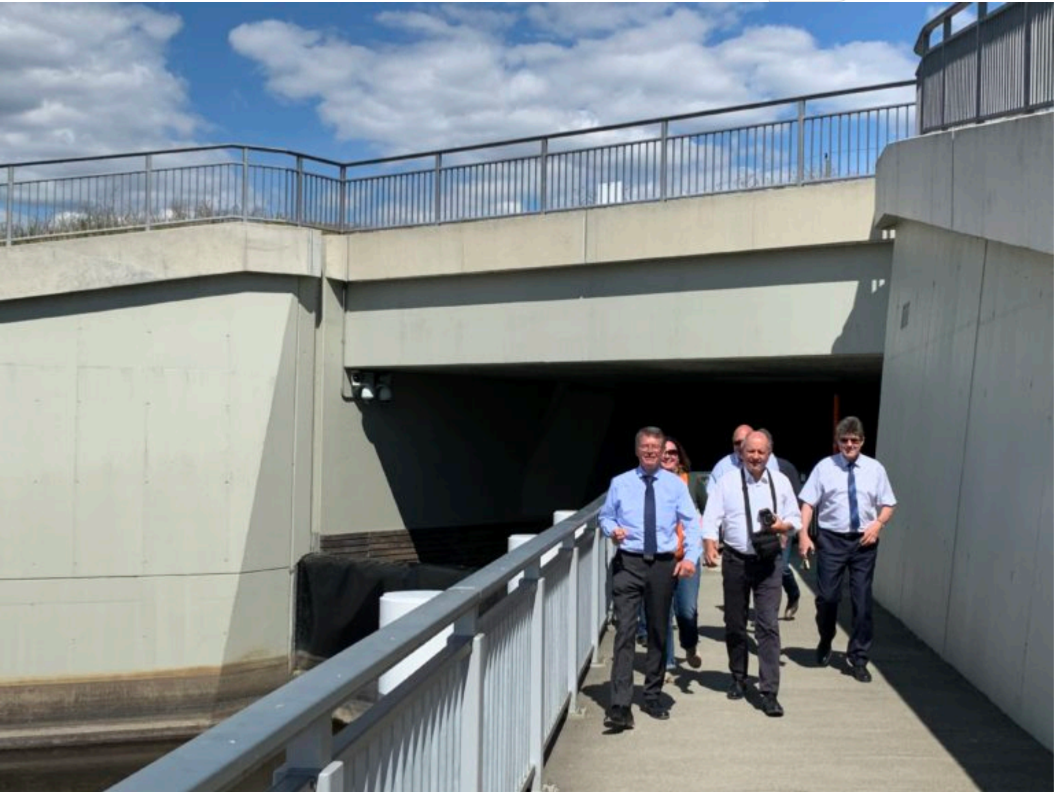
Am Tunnel des Überleiters 11
