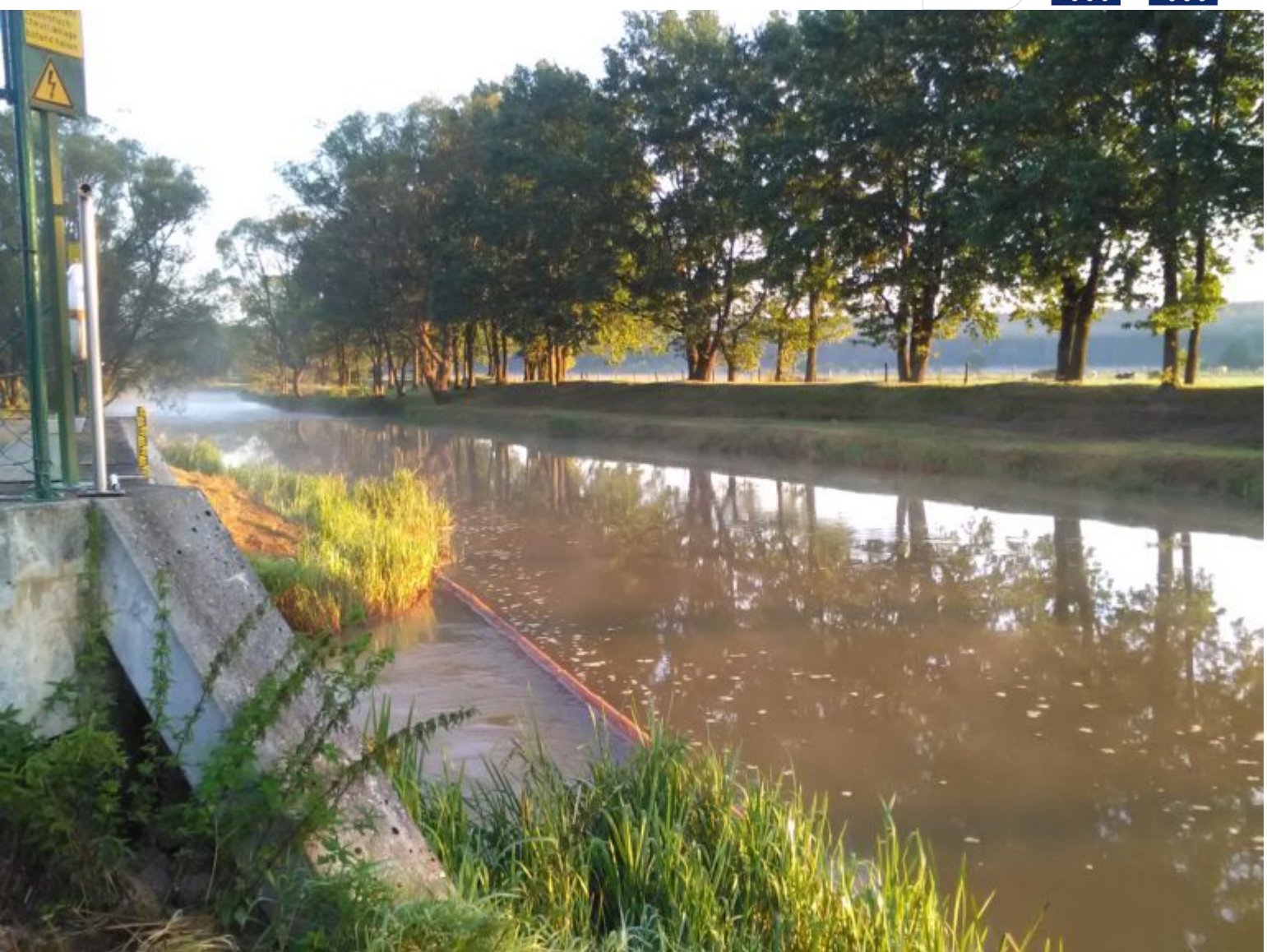
Symbolfoto: LMBV-Abnahmebauwerk an der Spree bei Spreewitz
