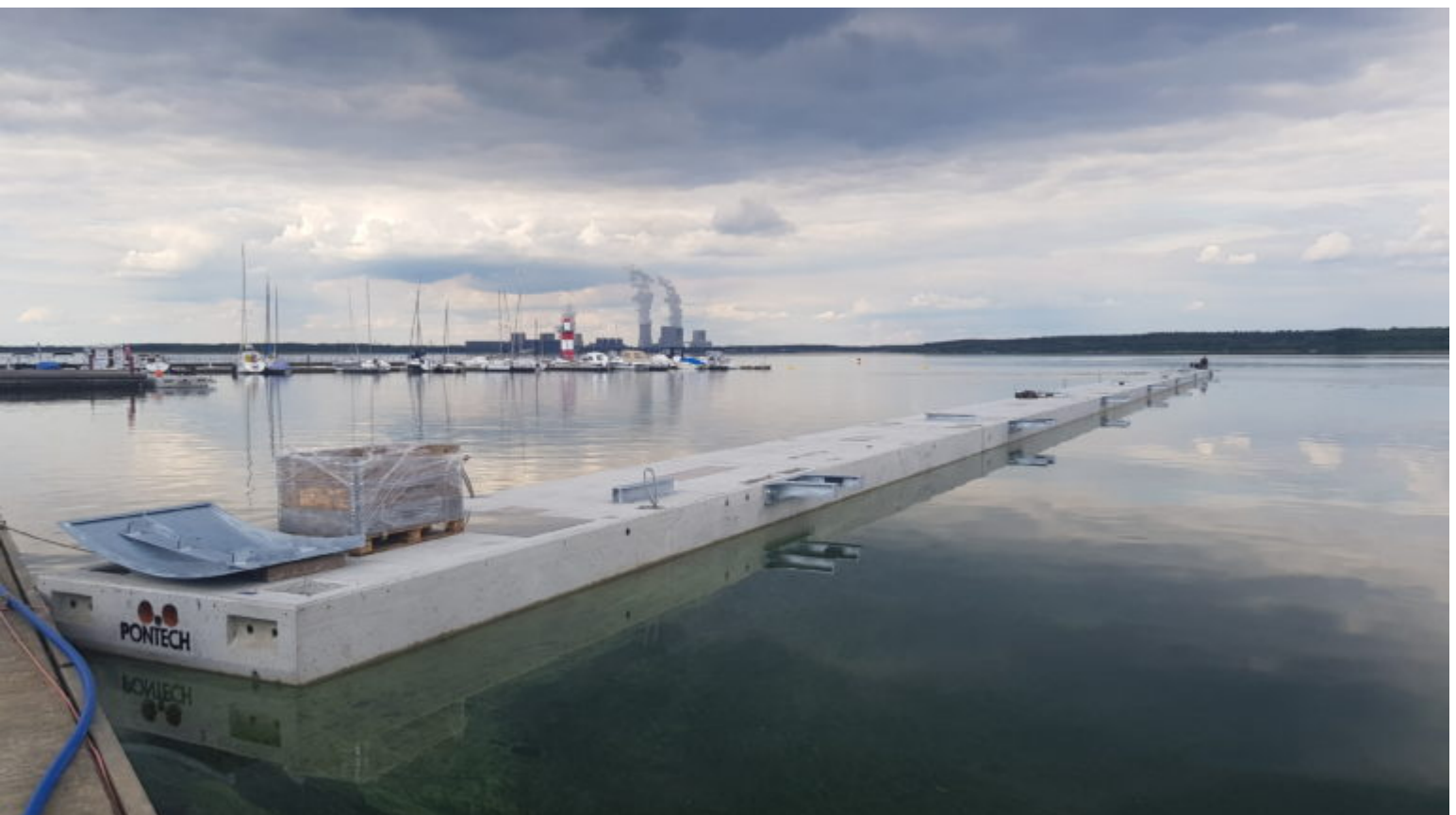
FHG: Zusätzlicher Steg der Investoren an Klittener Marina installiert
