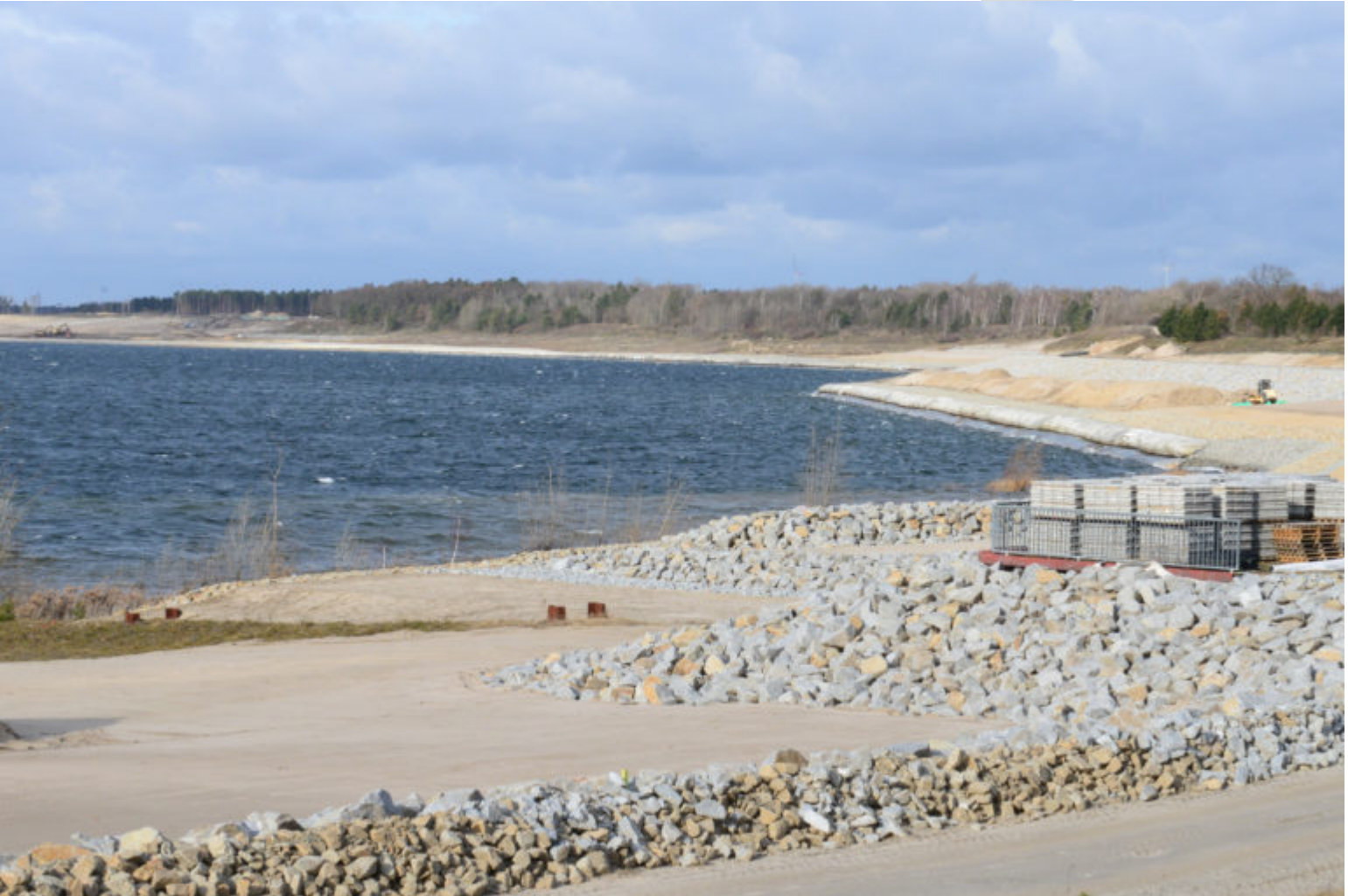
Ufergestaltung am Sedlitzer See nahe der Einlaufstelle des OLG
