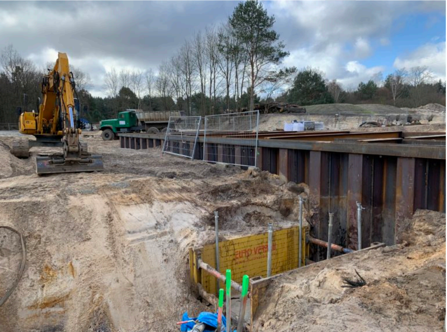
MWBA Ruhlmühle der LMBV im Aufbau
