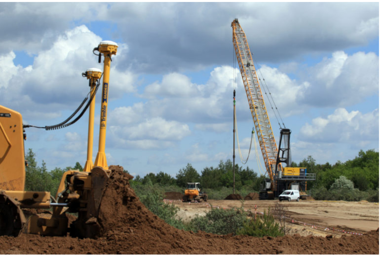
Aldöbern Sanierungsarbeiten im Auftrag der LMBV am Altdöberner See
