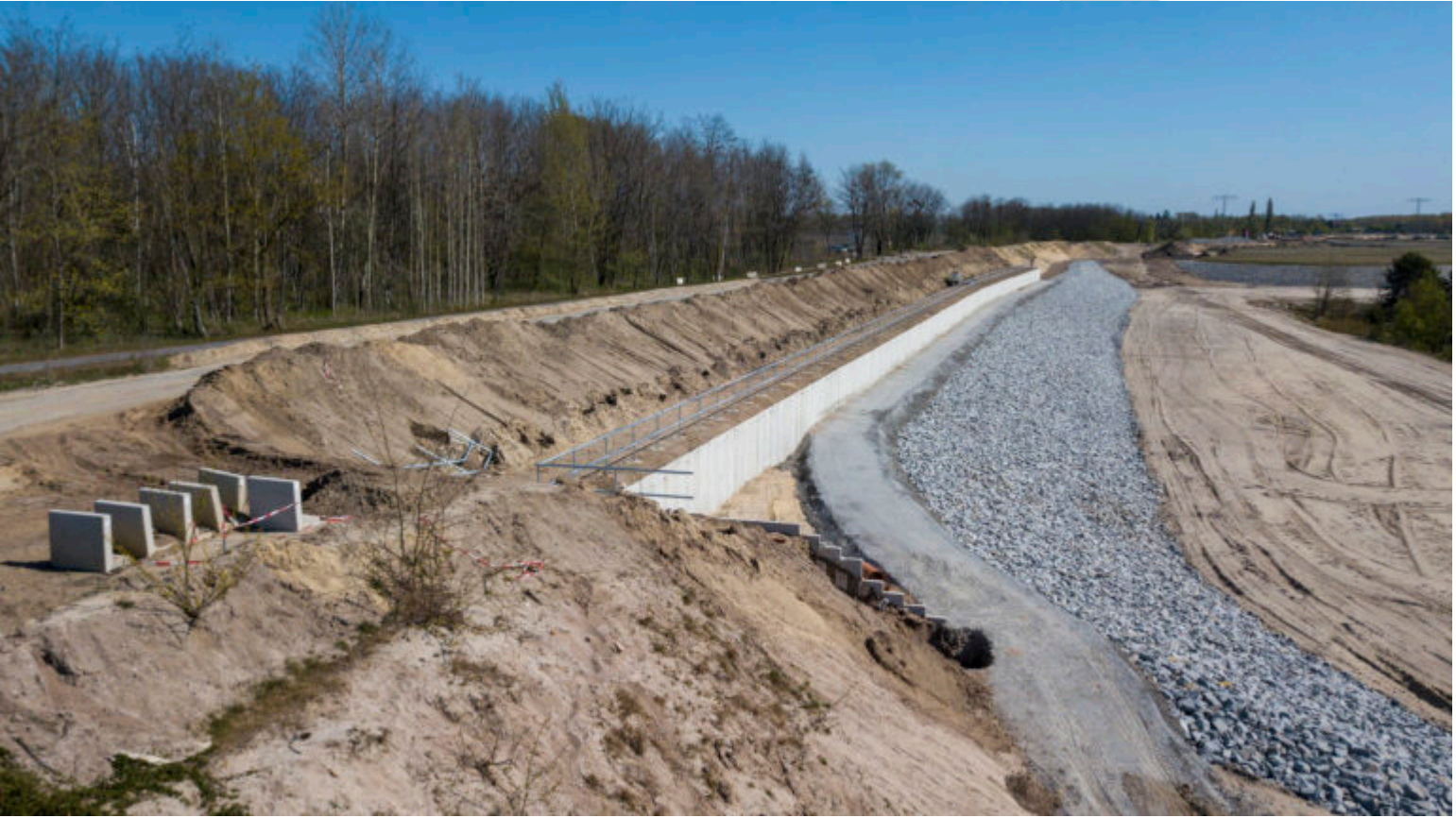
Erfolgter Uferverbau – Sedlitzer See
