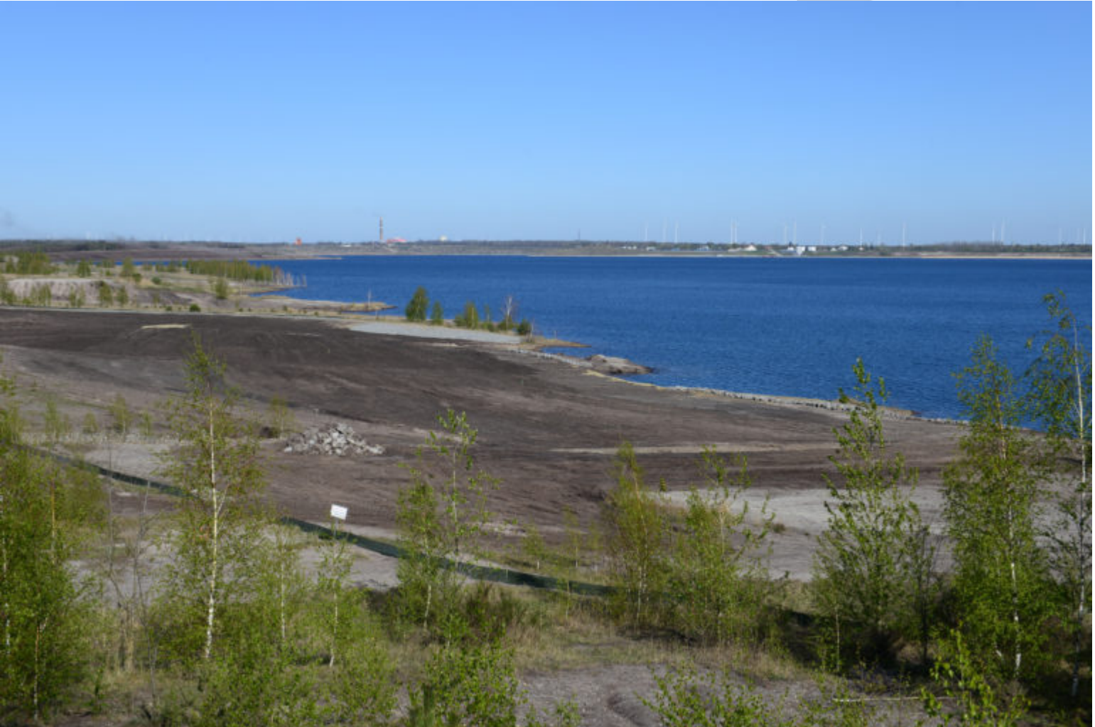
Sichtbare Ergebnisse der Böschungs-Endgestaltung am Großräschener See
