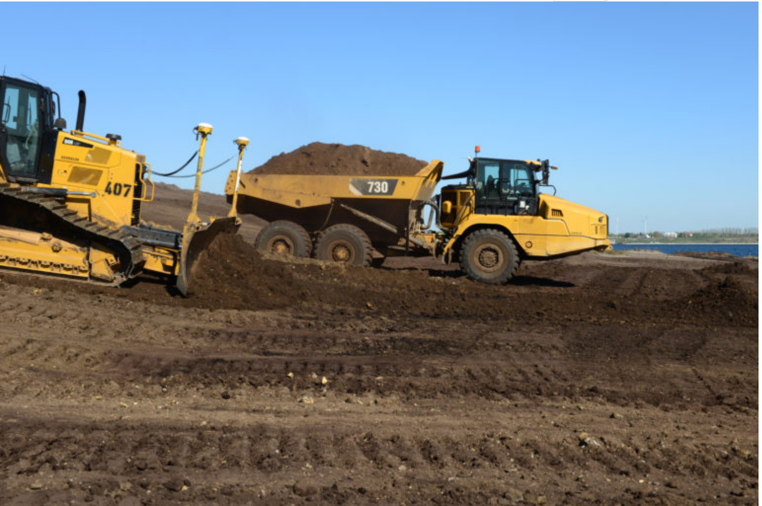
Böschungsgestalten am Großräschener Seeufer i.A. der LMBV
