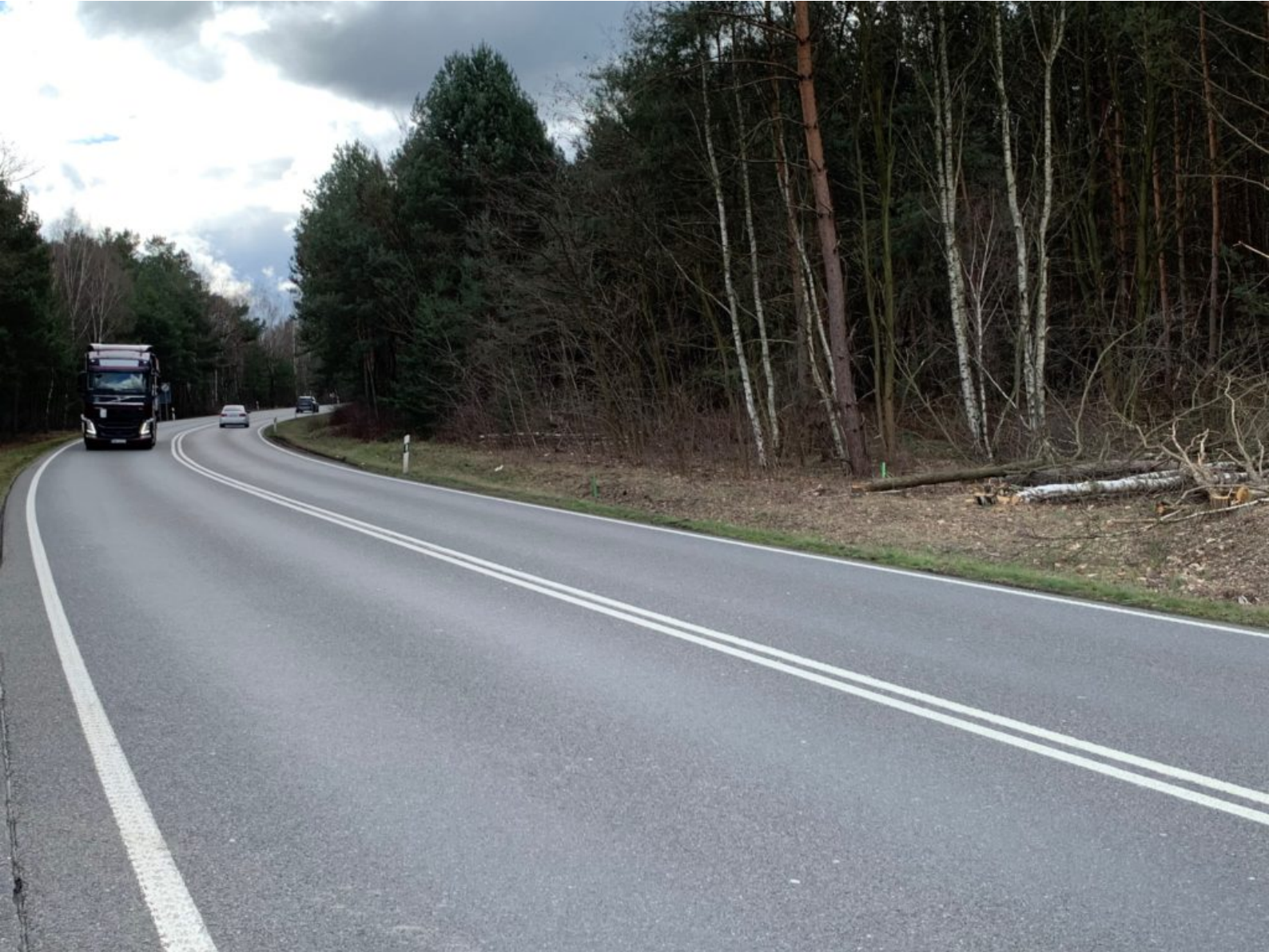
Bereich der Geschwindigkeitsbegrenzung an der Bundesstraße 97 (Tempo-30-Zone) Fotos vom VD-Probefehl: CDM Smith
