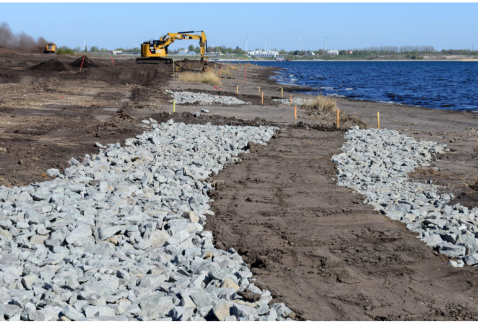
Böschungsendgestaltung am See
