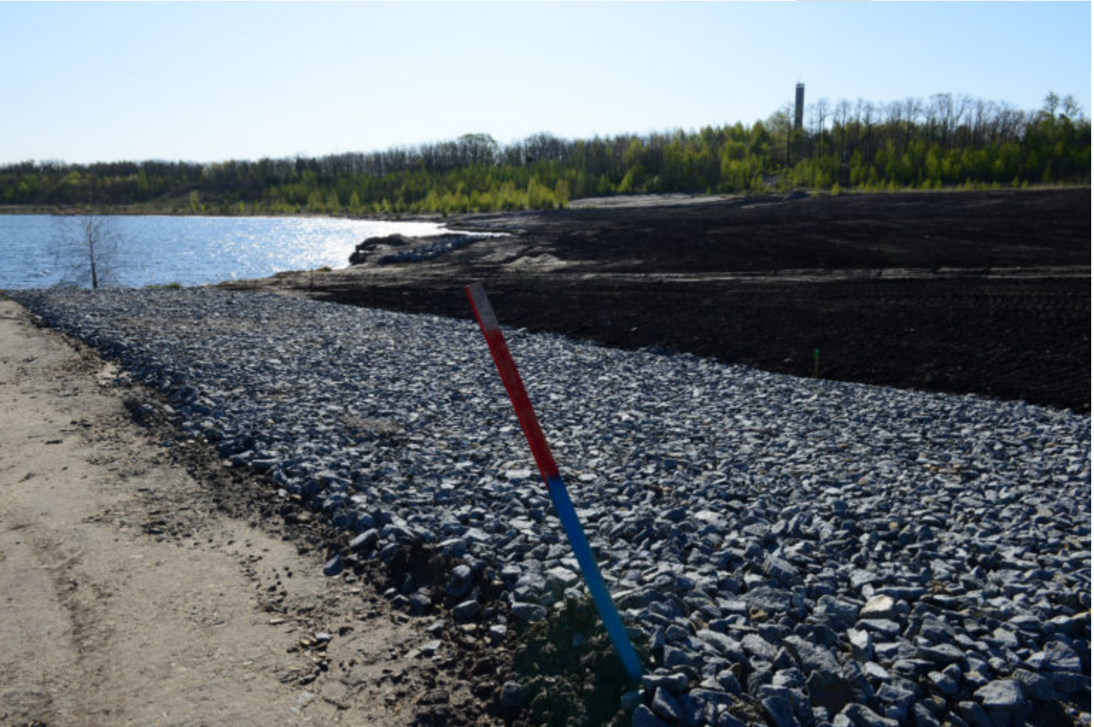
Verfüllung der Erosionsrinnen am Großräschener See auf Sedlitzer Seite
