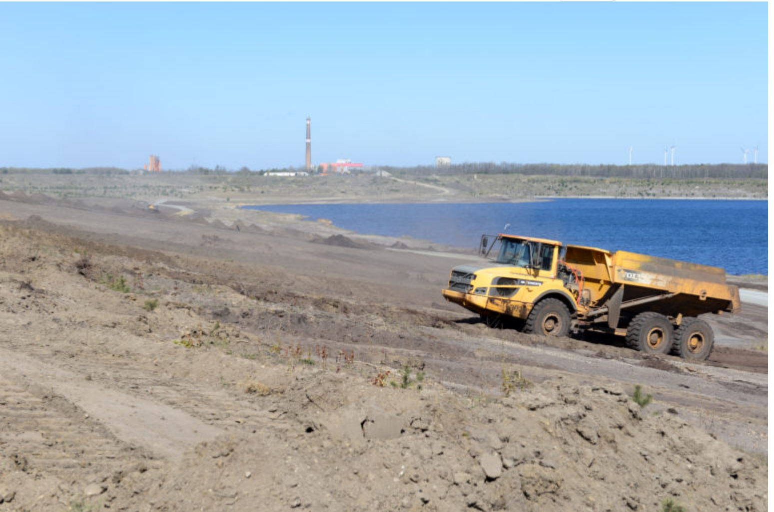
Massentransporte zur Böschungsgestaltung – Schornstein von “Sonne” im Hintergrund
