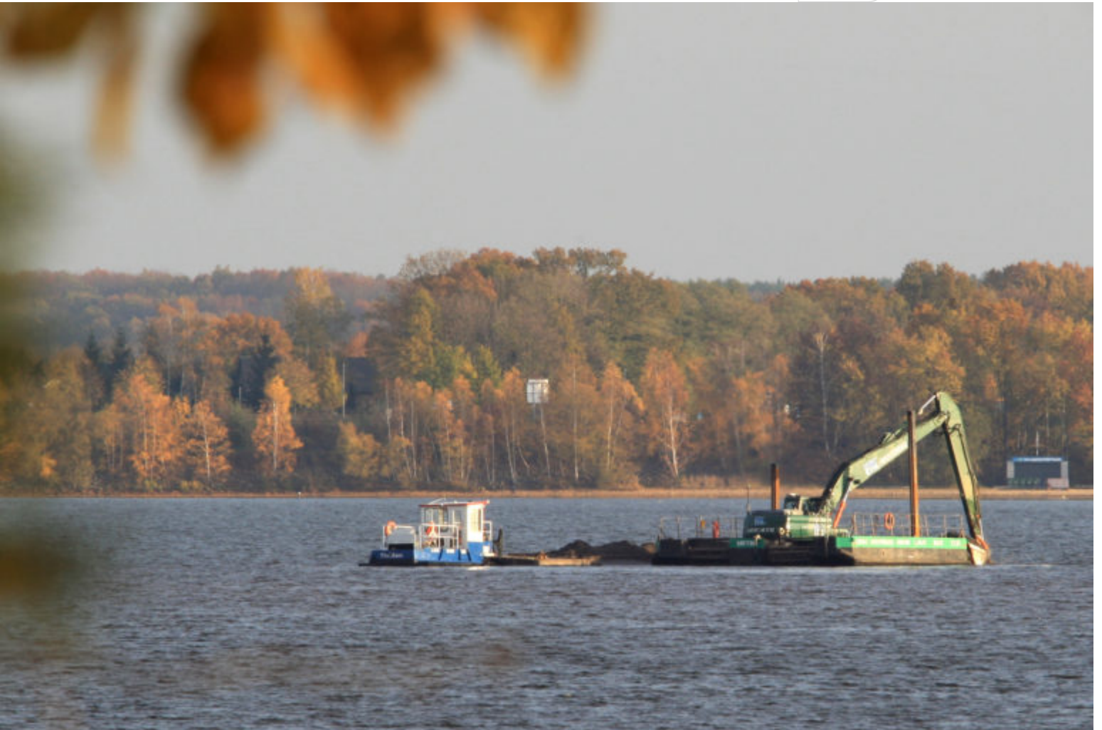
Schwimmbagger der Fa. ETK bei Sofortmaßnahme Teil 2
