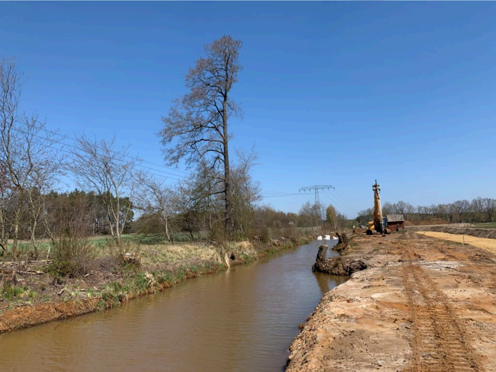
Bereits entschlammter Flussabschnitt der der Kleinen Spree bei Spreewitz Impressionen von der Baustelle im Abschnitt III - Fotos: Uwe Steinhuber
