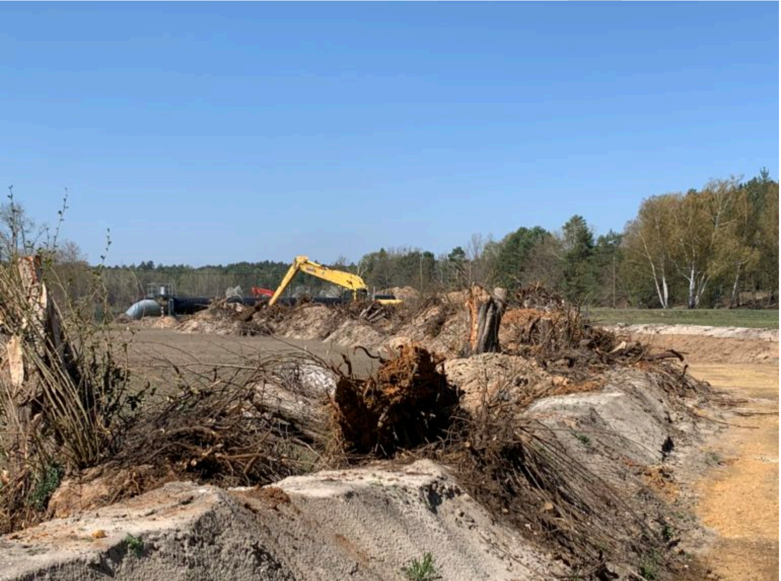
Abschnitt III zur Entschlammung der Kleinen Spree
