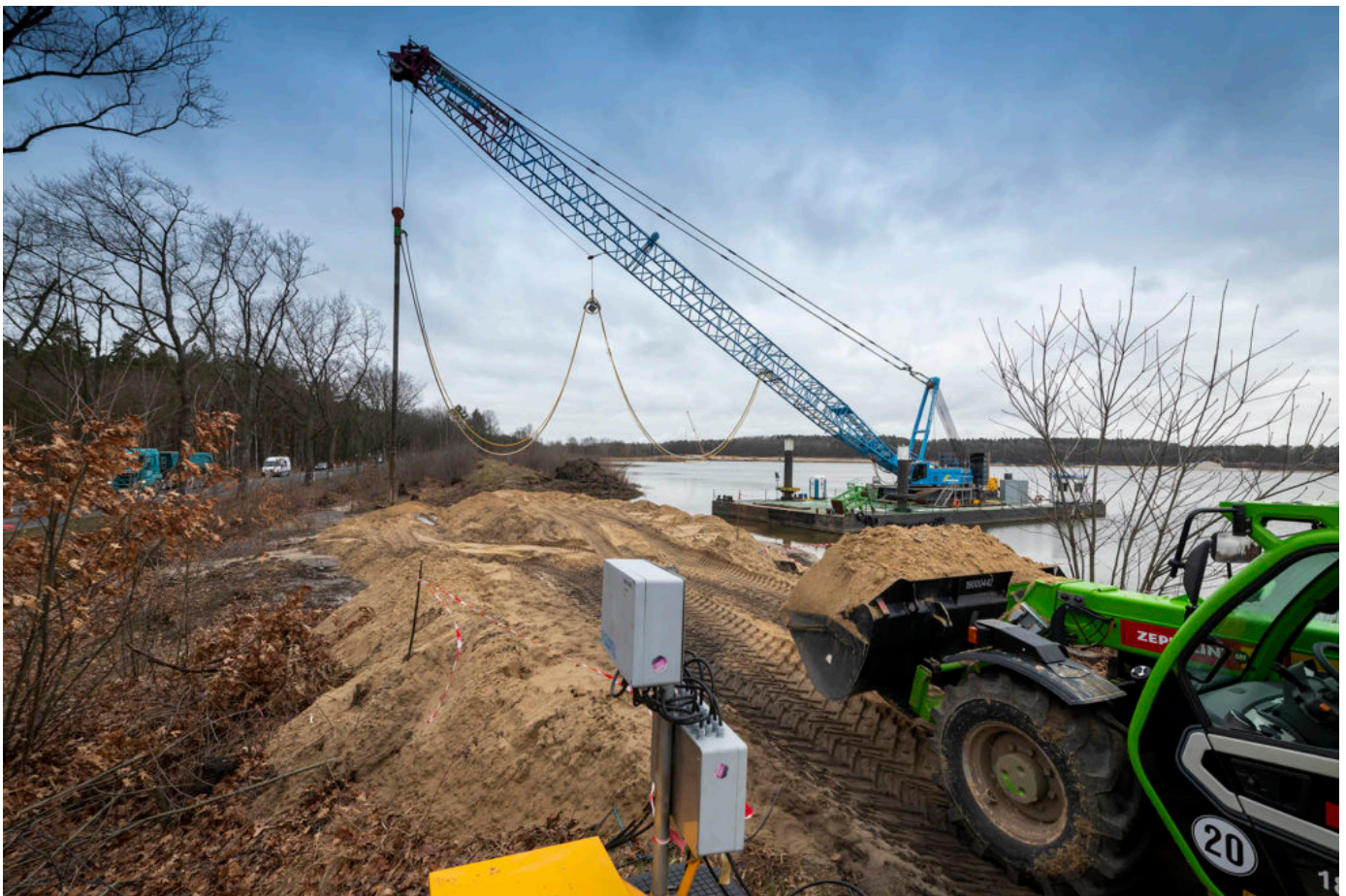
Impressionen von aktuellen Sanierungsarbeiten am Knappensee | Fotos: Peter Radke für LMBV
