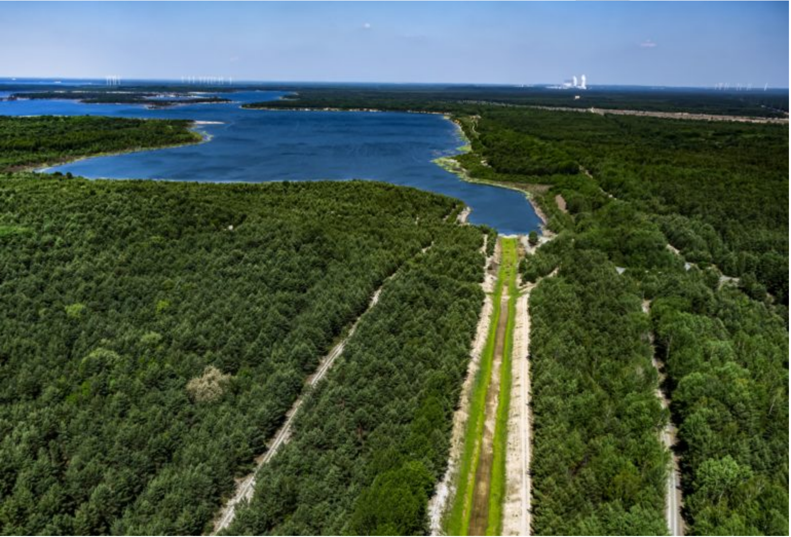
Zulauf-Anlage für den Speicher Lohsa II
