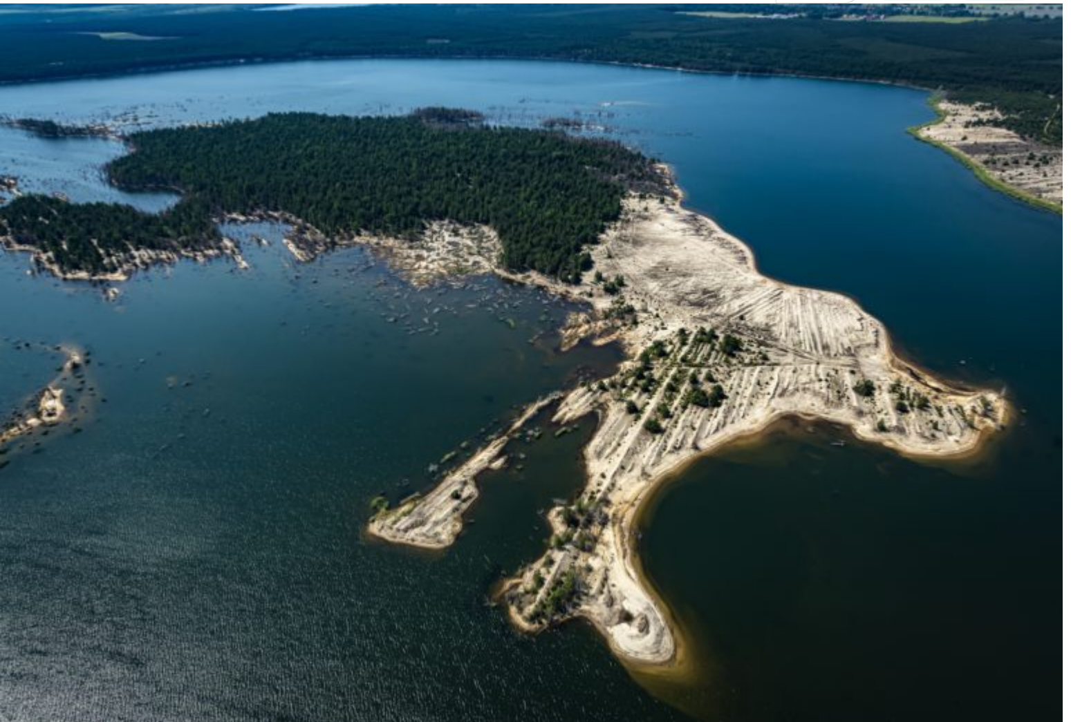
Blick über die verbliebenen ungesicherten Abschnitte im Speicher Lohsa II
