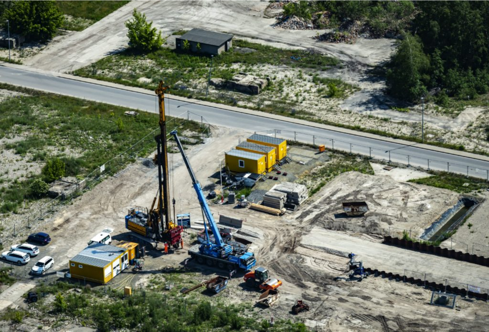
LMBV-Luftbild von der Bodensanierung aus 2019 / Fotograf Peter Radke Impressionen von der Bodensanierung | Dr. Uwe Steinhuber für LMBV
