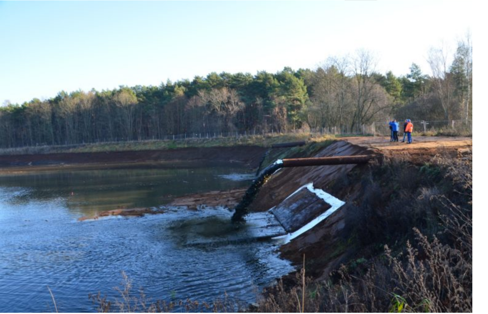
Sedimentationsbecken wird wieder befüllt
