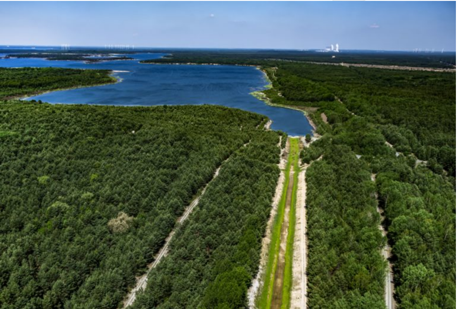
Zulauf-Anlage für den Speicher Lohsa II
