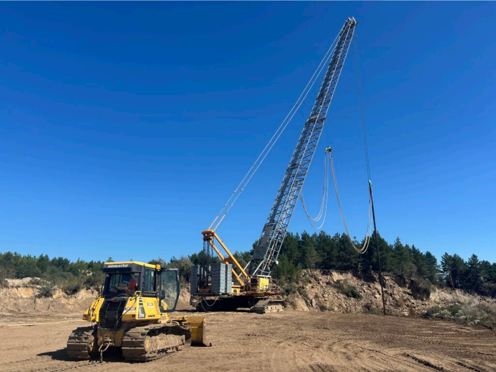
Rütteldruckverdichtung i. A. der LMBV am Restloch Greifenhain
