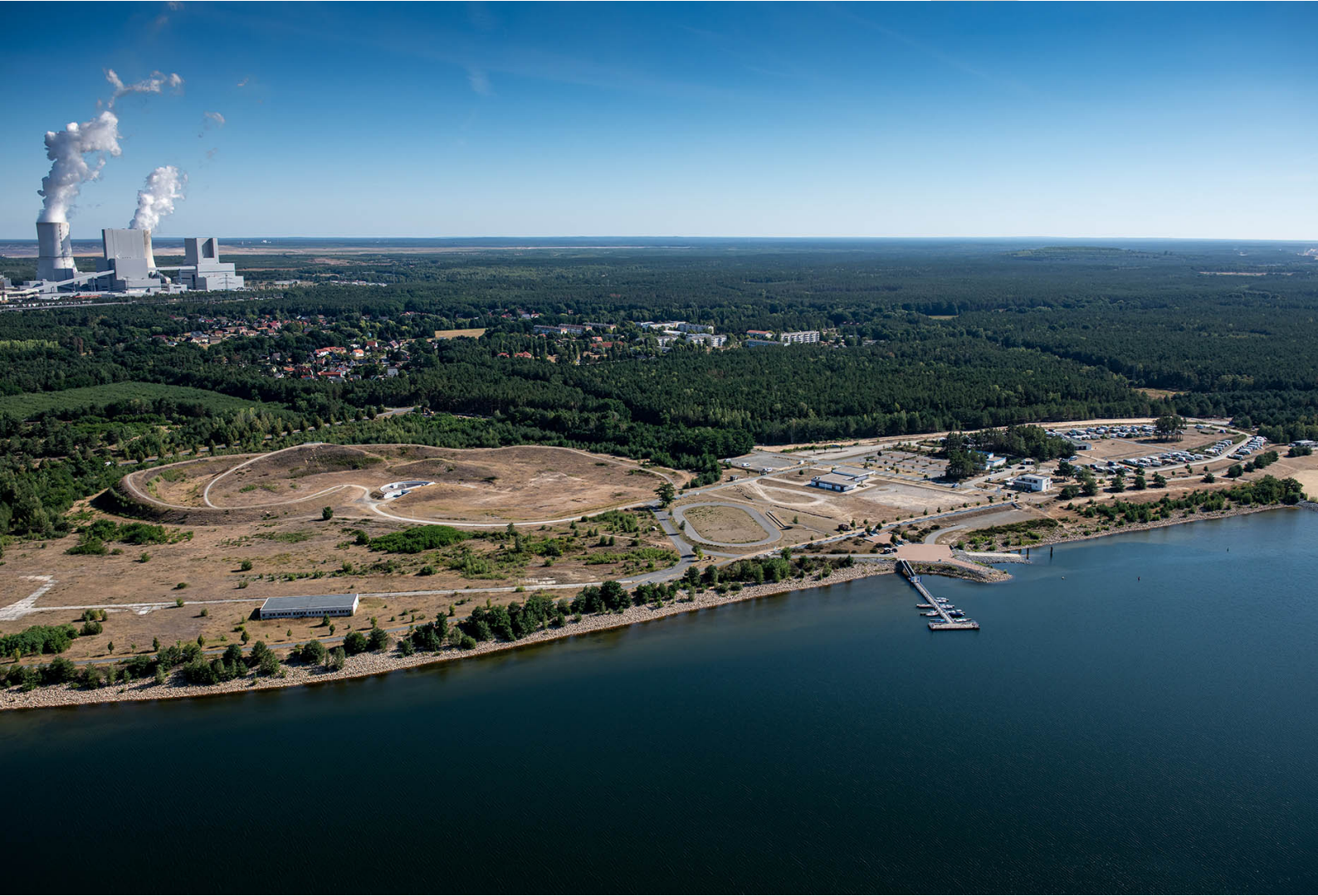
Boxberger Steganlage am Bärwalder See
