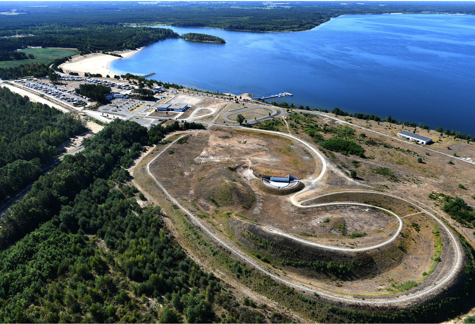
Landschaftsbauwerk OHR am See
