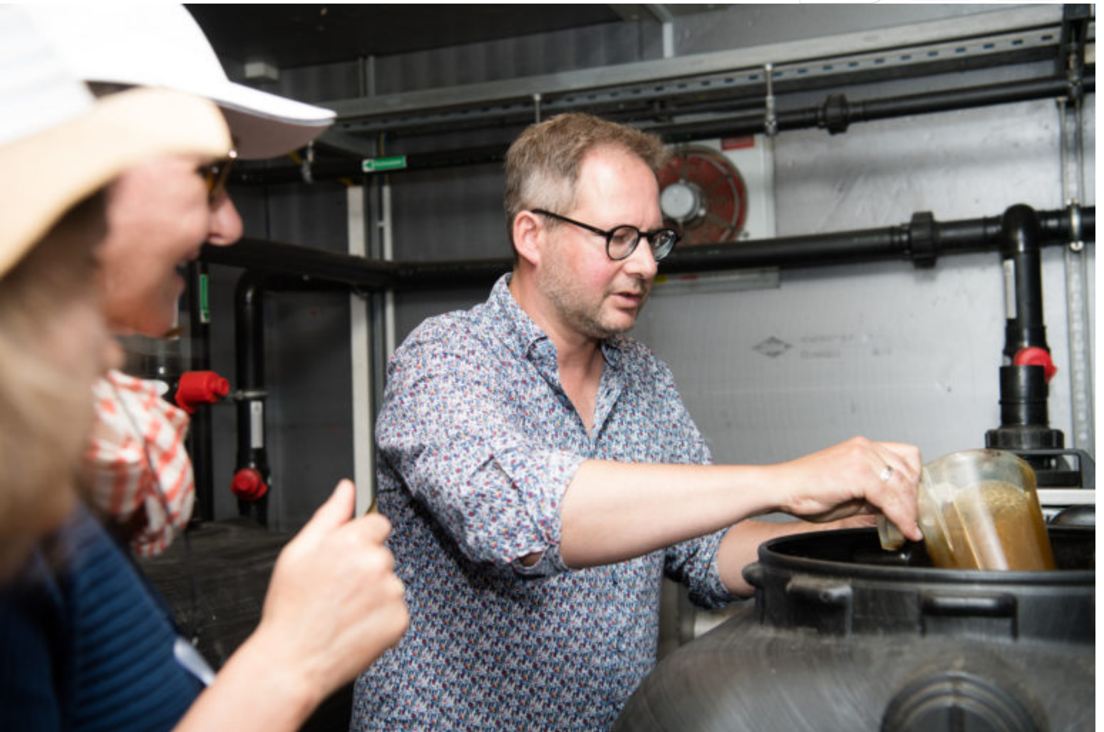
Ein Teil des Wassers ist mit Öl belastet, das zuerst abgesondert wird.
