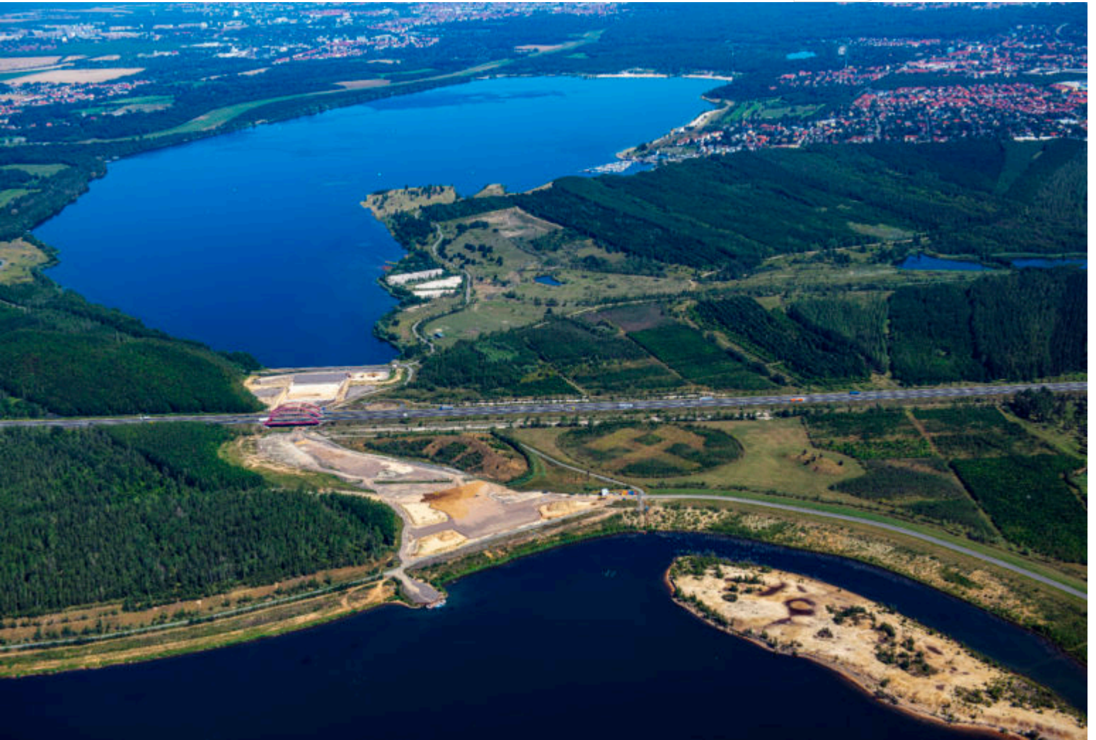
Ruhende Baustelle Harthkanal – Archivfoto v. P. Radke
