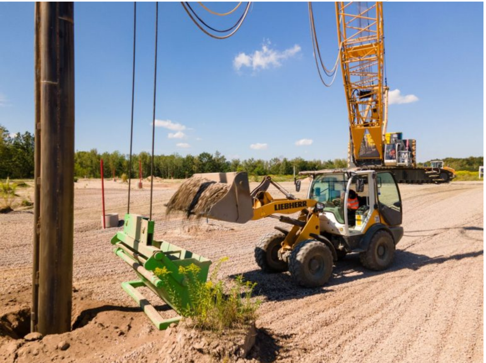
Vorführung der RSV-Technik, Bild vom diesjährigen Baustellentag
