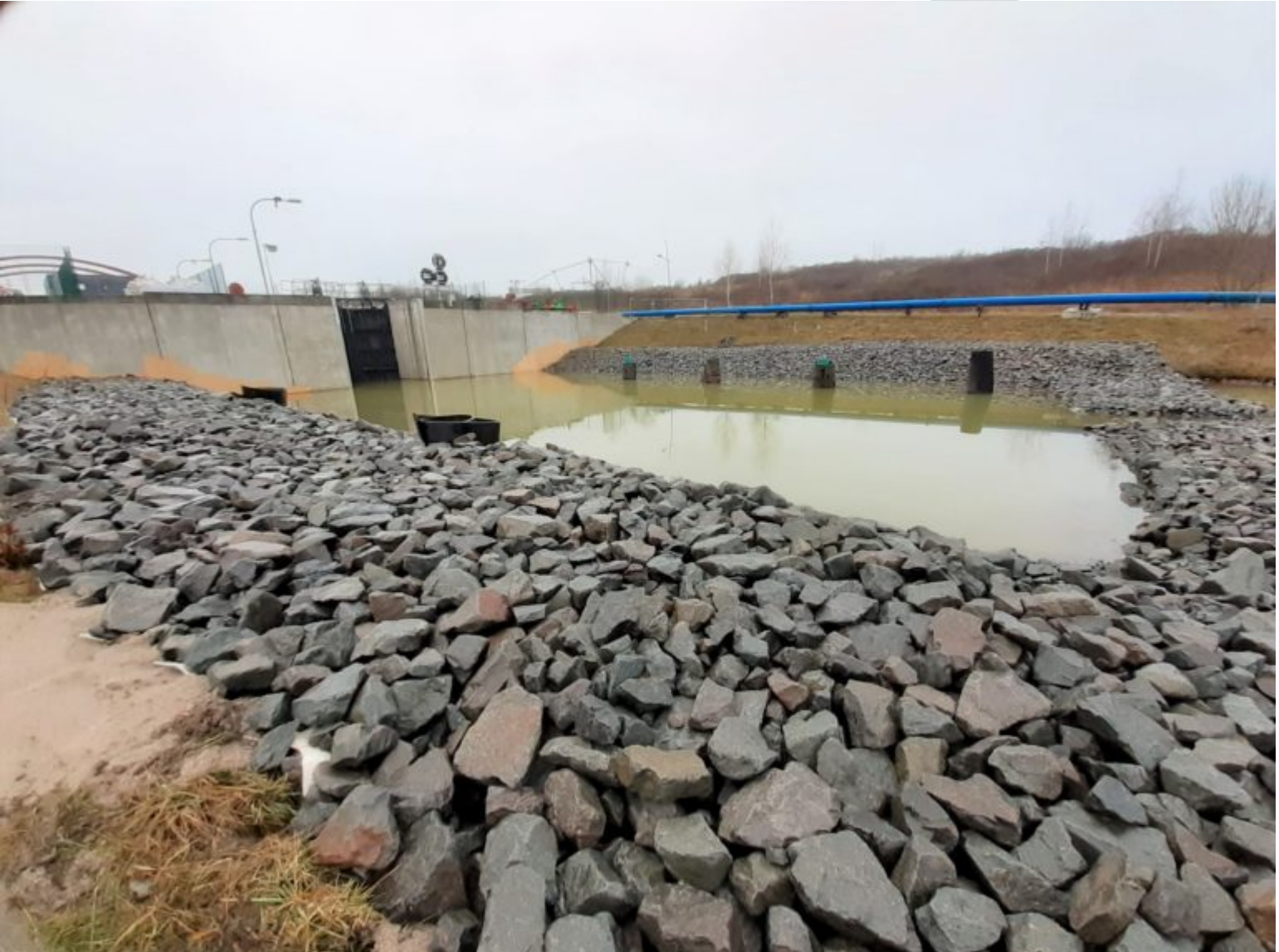
Neu gebauter Stützkörper aus Wasserbausteinen im Unterhafen des Störmthaler Kanals, Foto: LMBV/Falk Bräuer
