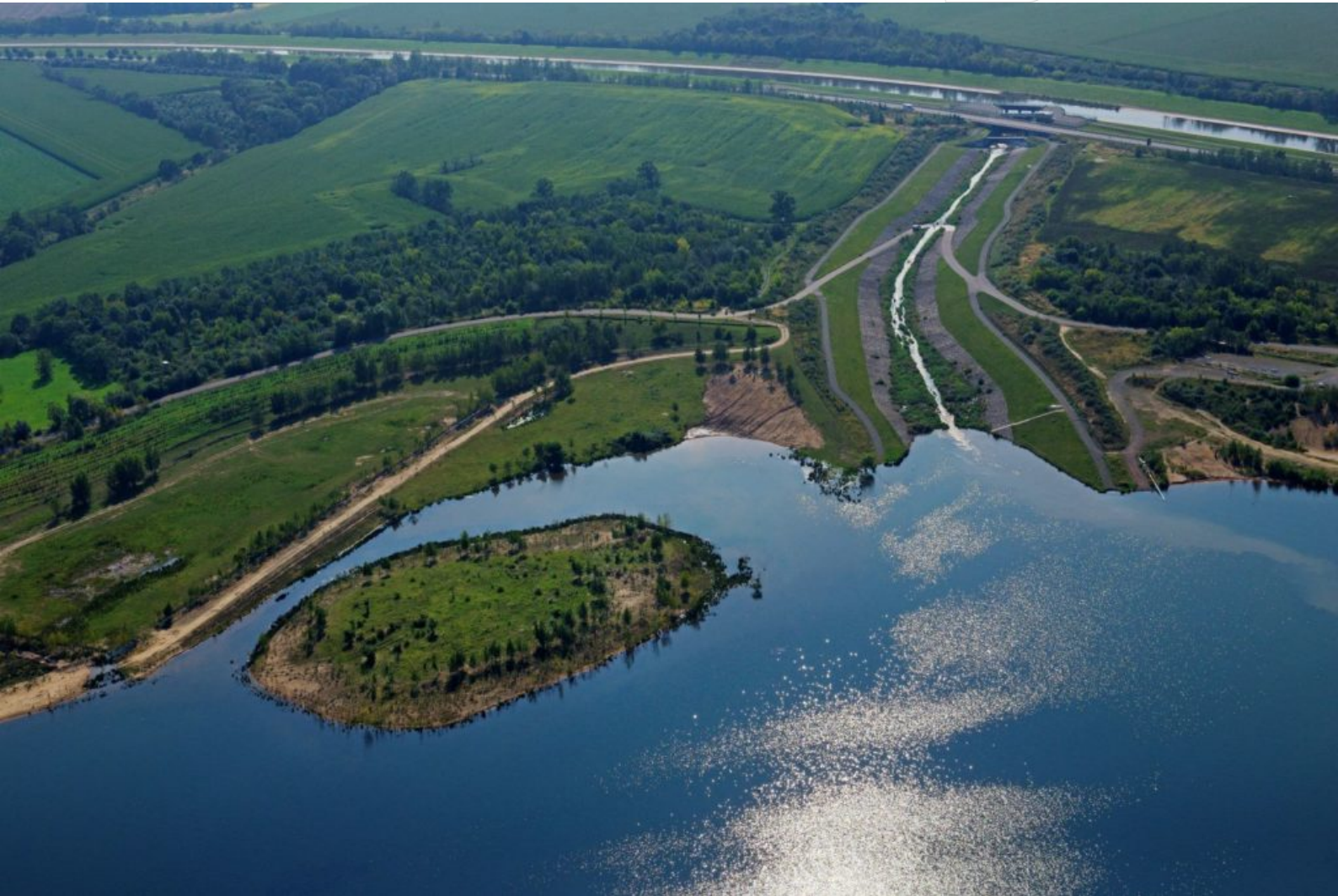
Hochwasserentlastungsanlage am Südwestufer des Zwenkauer Sees (Foto: LMBV/Christian Bedeschinski)
