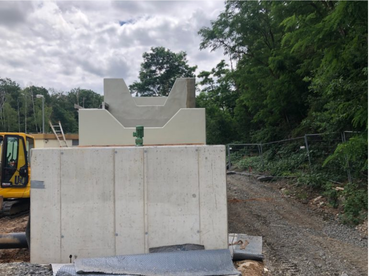
Drei-Kammer-Becken im Bau
