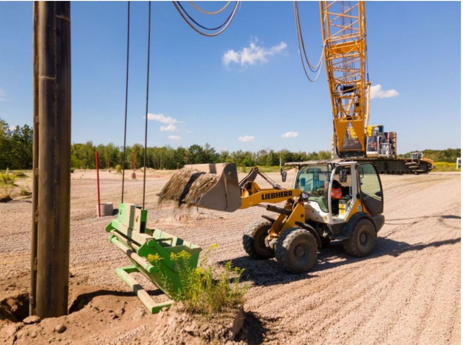
Vorführung der RSV-Technik, Bild vom diesjährigen Baustellentag
