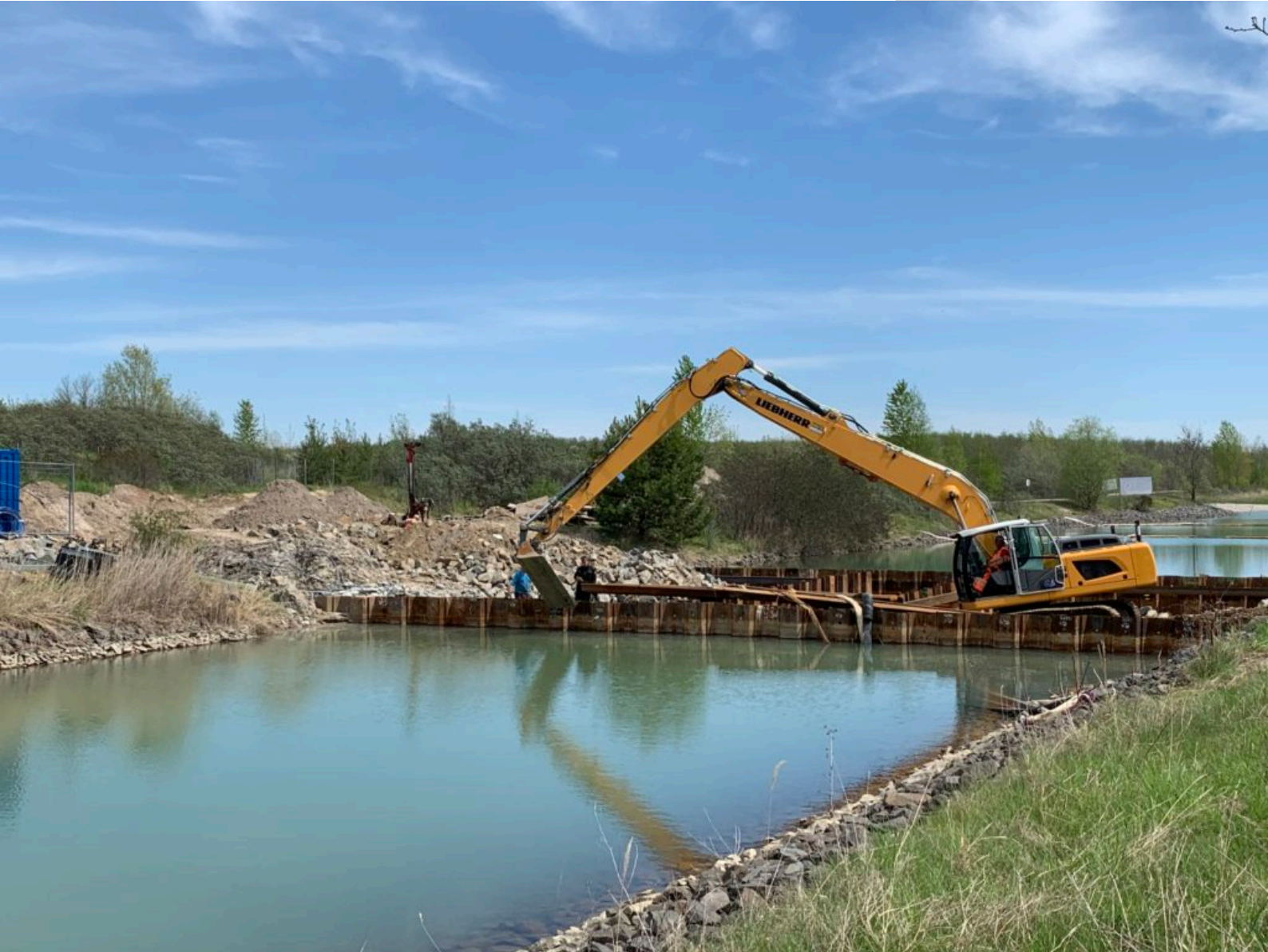
Auffüll- und Schweißarbeiten am Oberen Querbauwerk
