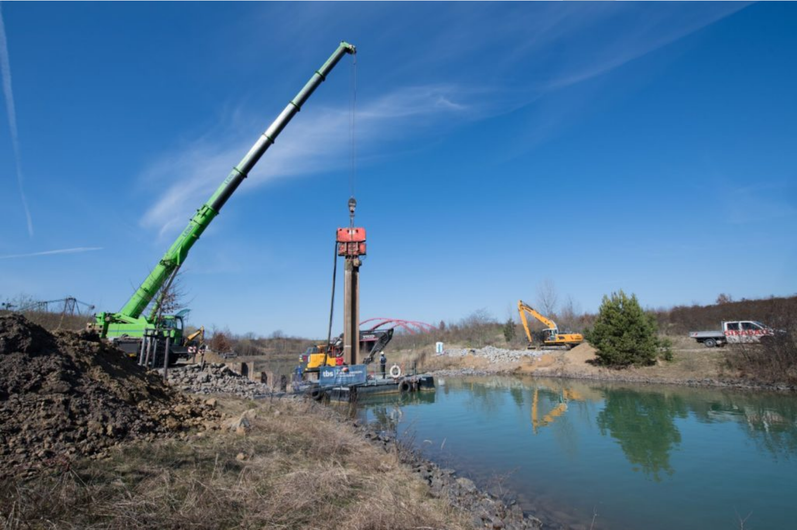
Spundwandbau im Störmthaler Kanal, zwischen A38 und Störmthaler See
