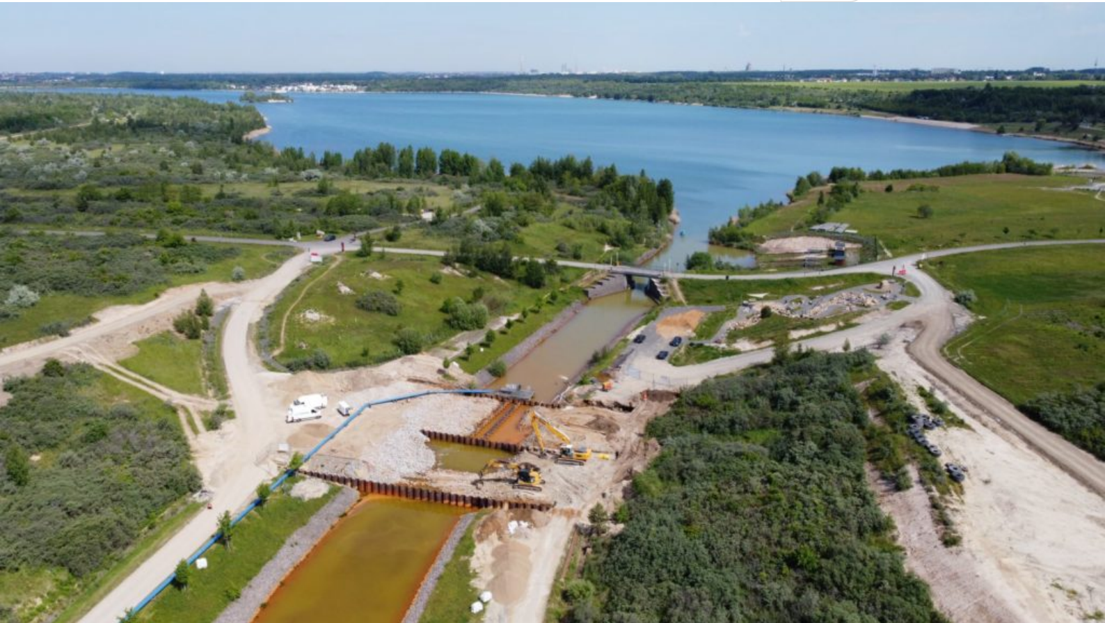
Unteres Querbauwerk in Richtung Markleeberger See
