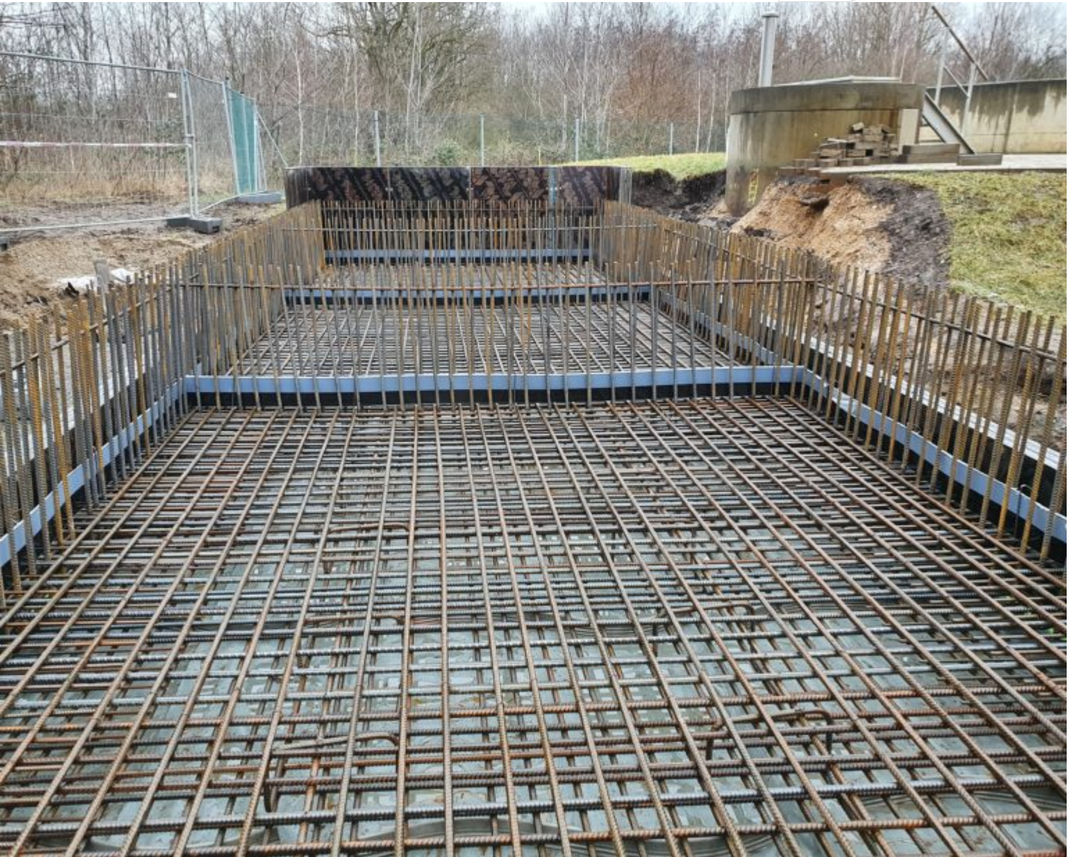
Bewehrung der Bodenplatte für das Drei-Kammer-Becken, das vor Ort gegossen wurde.
