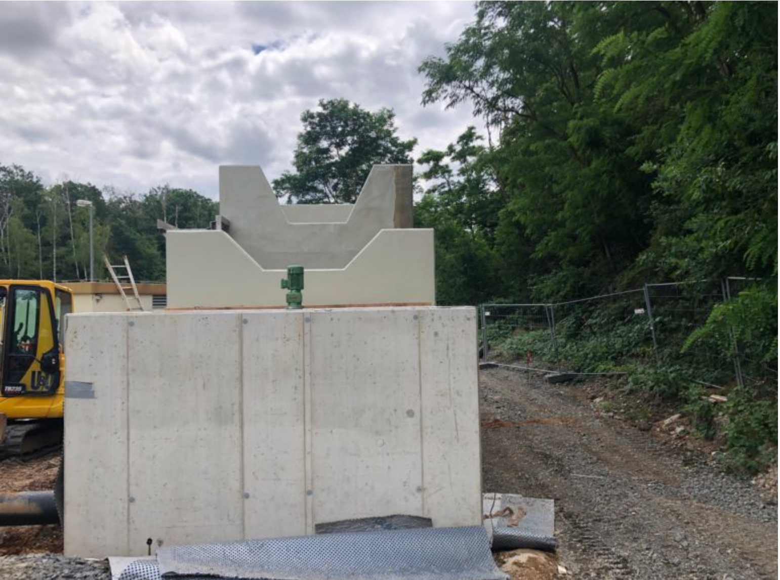
Drei-Kammer-Becken im Bau
