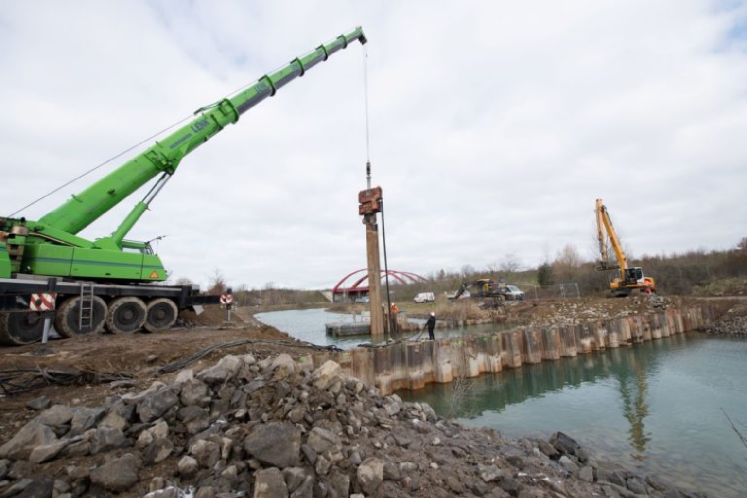
Oberer Spundwandriegel am Störmthaler Kanal im Entstehen
