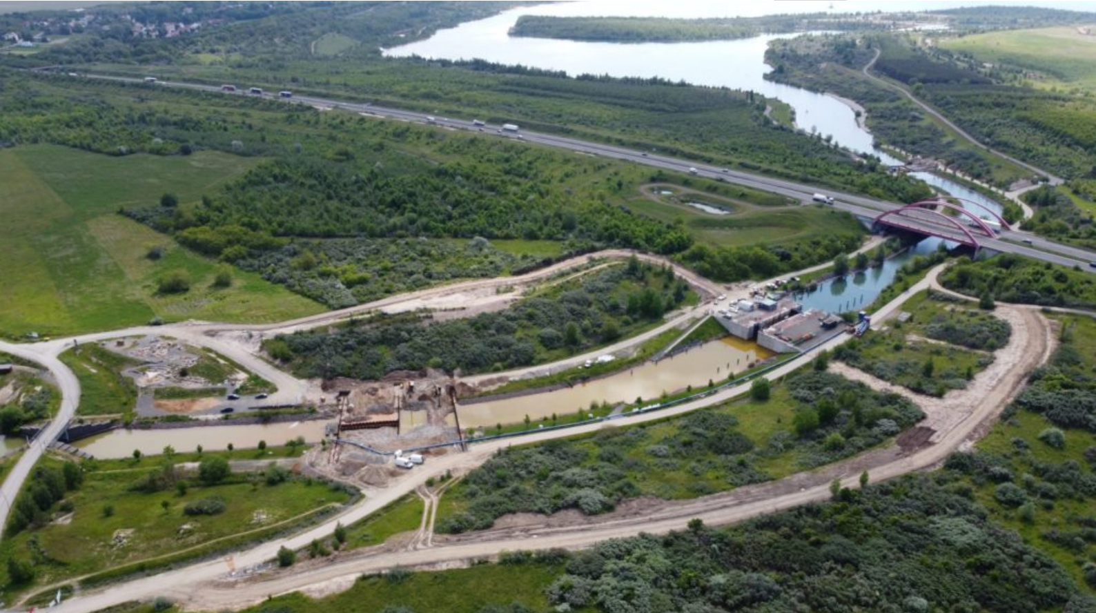
Luftaufnahme des Störmthaler Kanals mit beiden Querbauwerken, der Schleuse und der Brücke der A38
