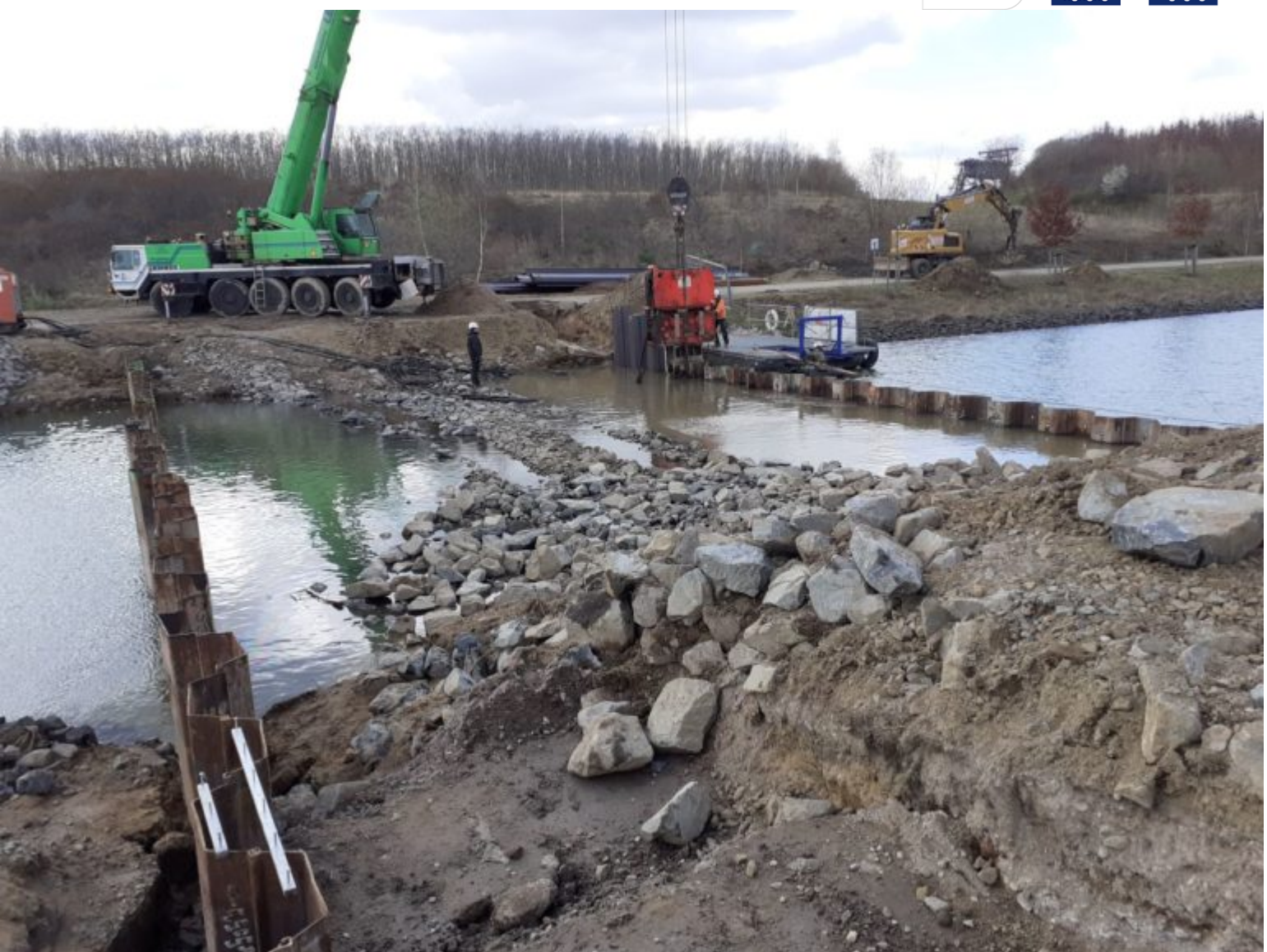
Schrittweises Auffüllen zwischen den Spundwänden
