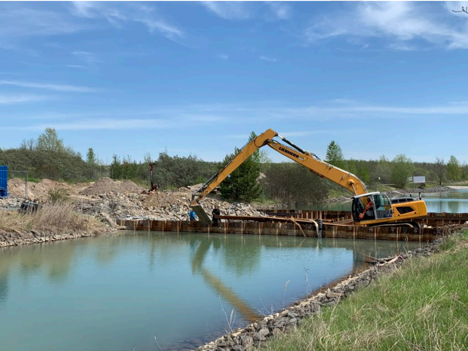
Auffüll- und Schweißarbeiten am Oberen Querbauwerk
