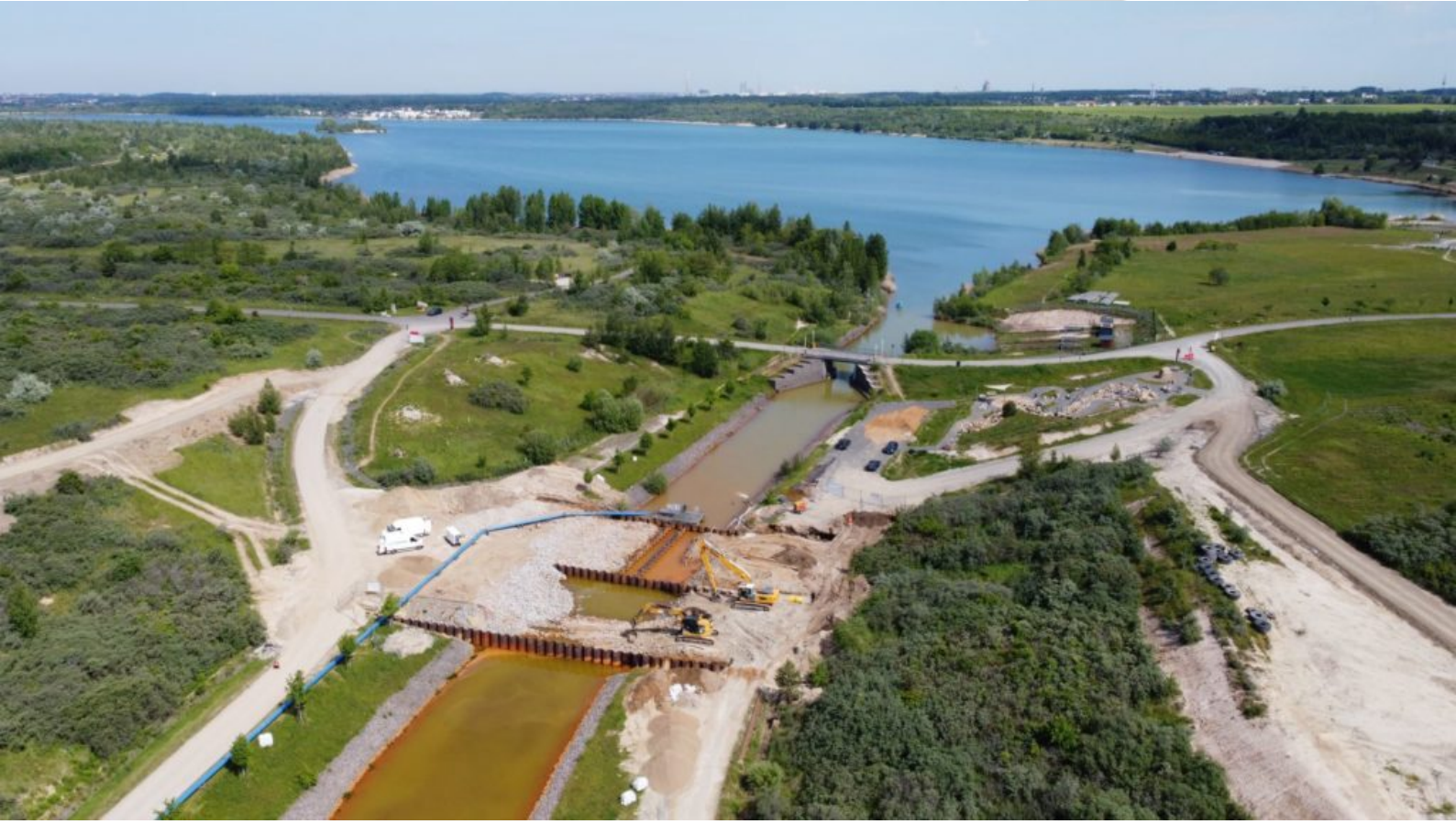
Unteres Querbauwerk in Richtung Markleeberger See
