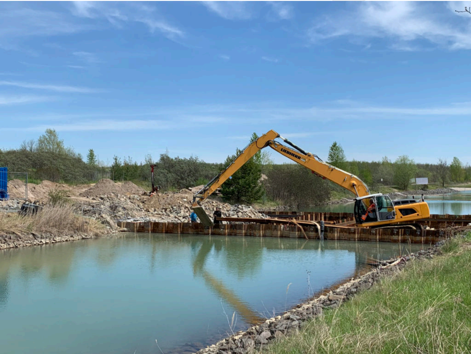
Auffüll- und Schweißarbeiten am Oberen Querbauwerk
