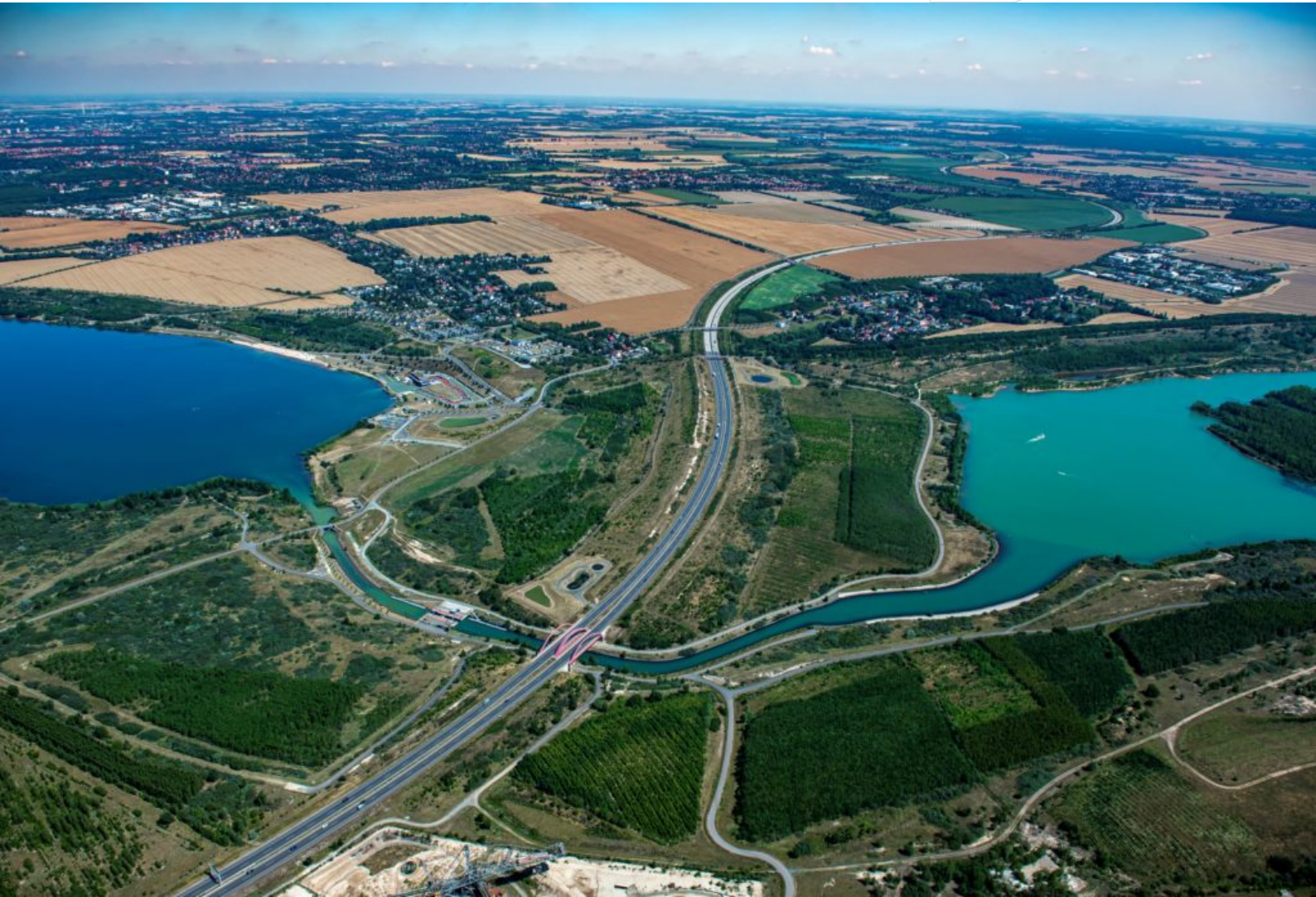
Markkleeberger See, Störmthaler Kanal mit Kanuparkschleuse und A 38, Störmthaler See (v.l.n.r., Quelle: LMBV)
