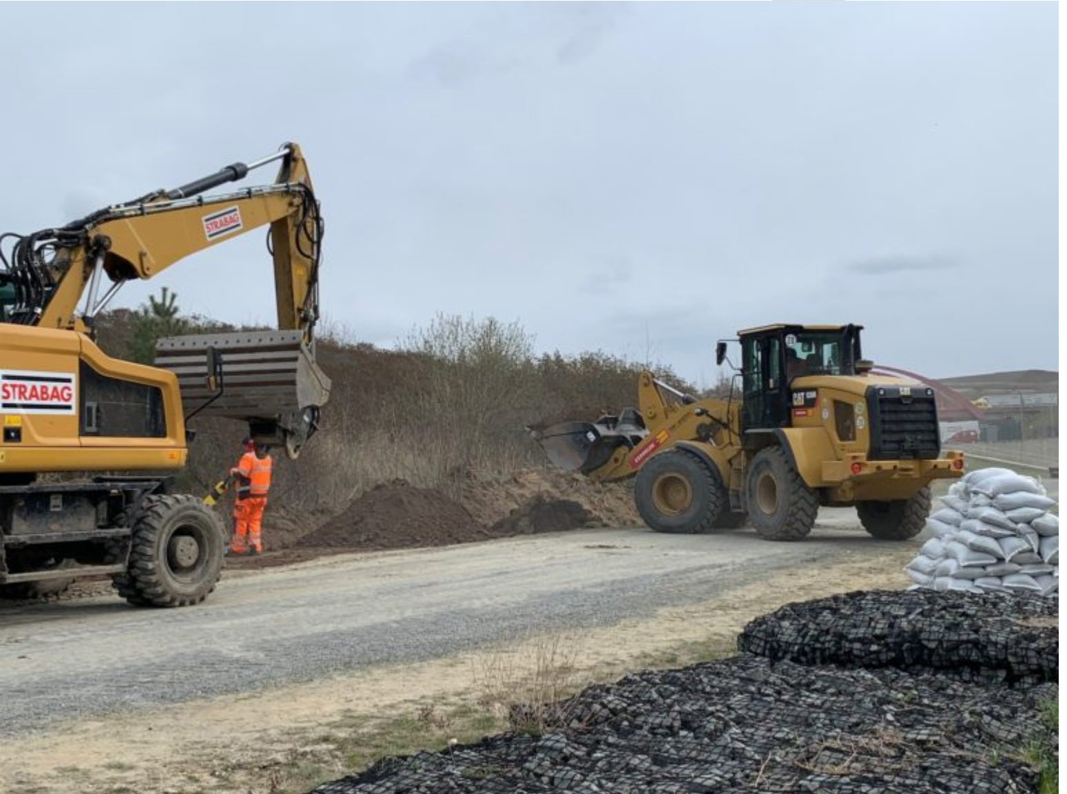
Herstellen der Arbeitsflächen für den Rammkran für den 2. BA
