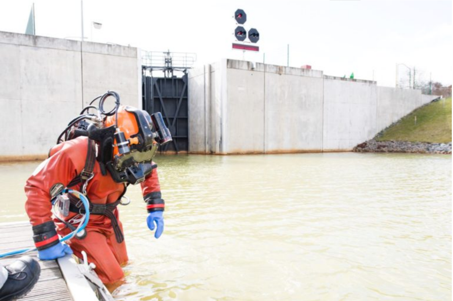
Kontrolltauchgang am unteren Schleusenvorhof am 07.04 2021
