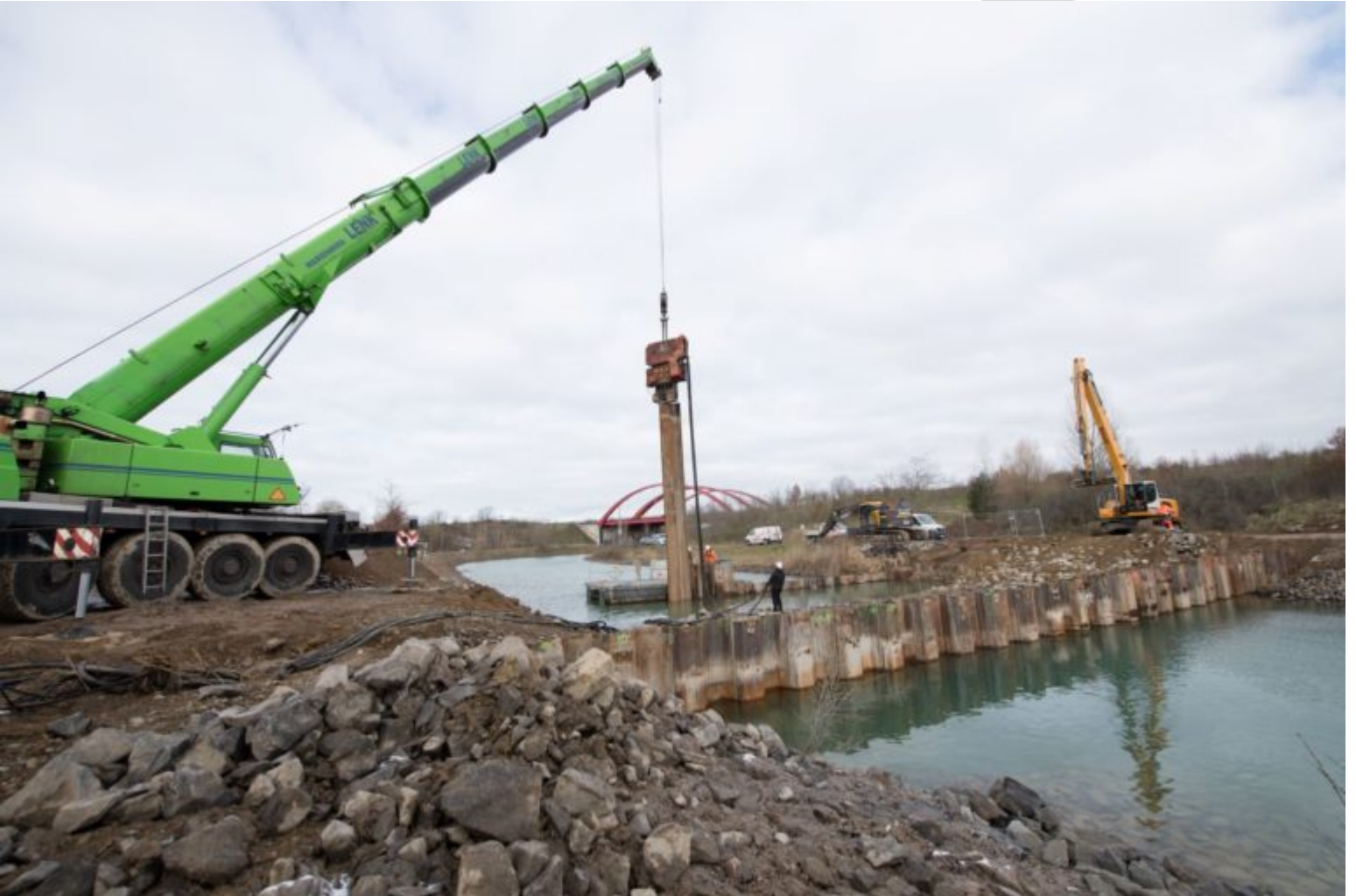
Oberer Spundwandriegel am Störmthaler Kanal im Entstehen
