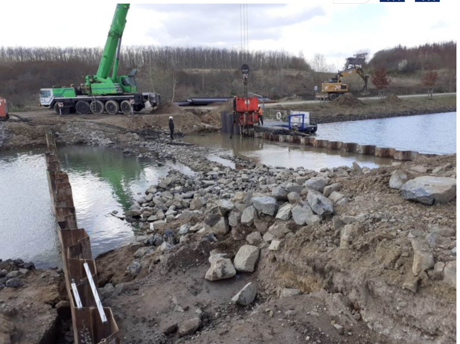
Schrittweises Auffüllen zwischen den Spundwänden
