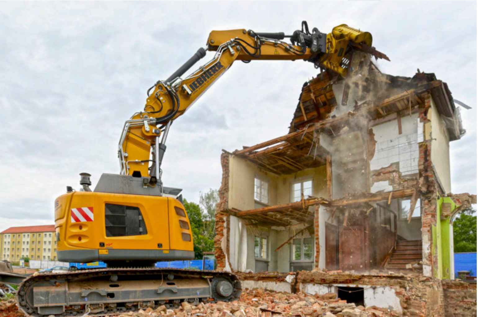
Rückbau von kontaminierten Gebäuden
