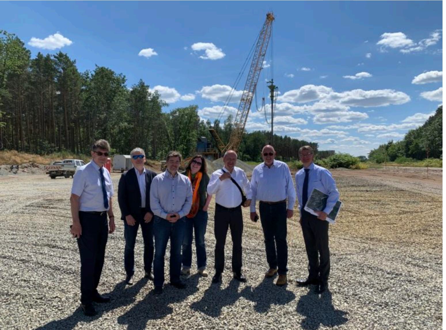
Aus der Entfernung: Rüttelstopfen
