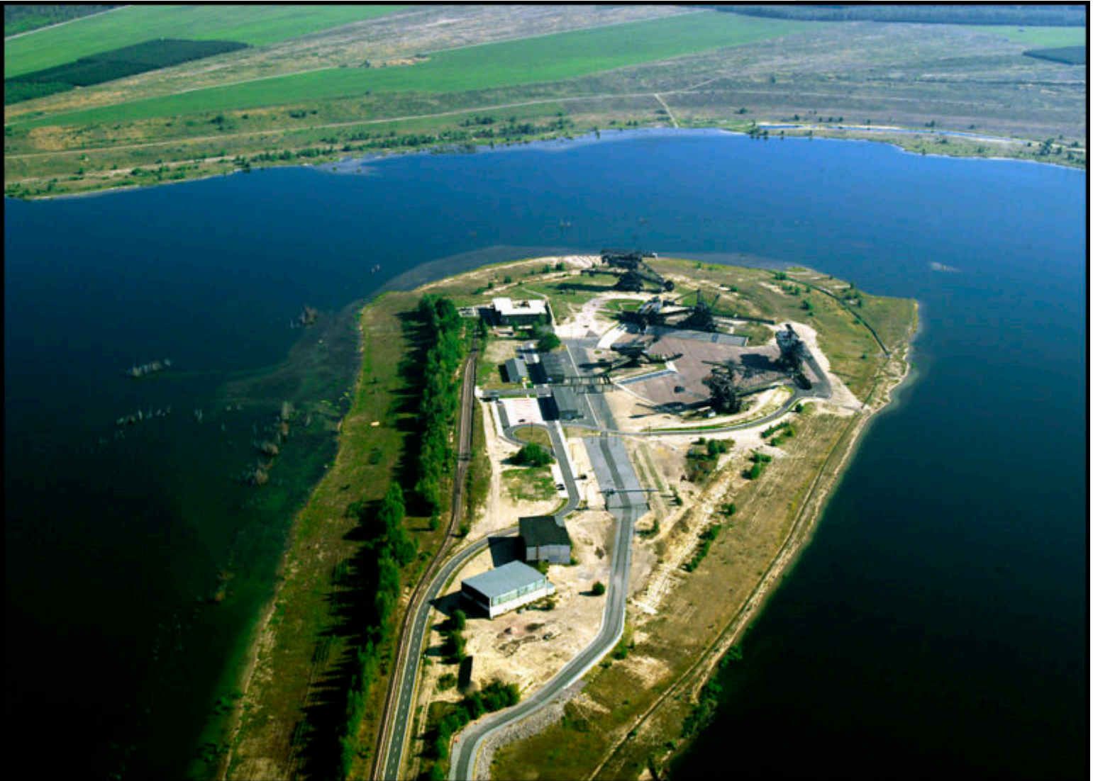
Ferropolis im Aufbau – LMBV-Luftbild aus 2004 v. Peter Radke
