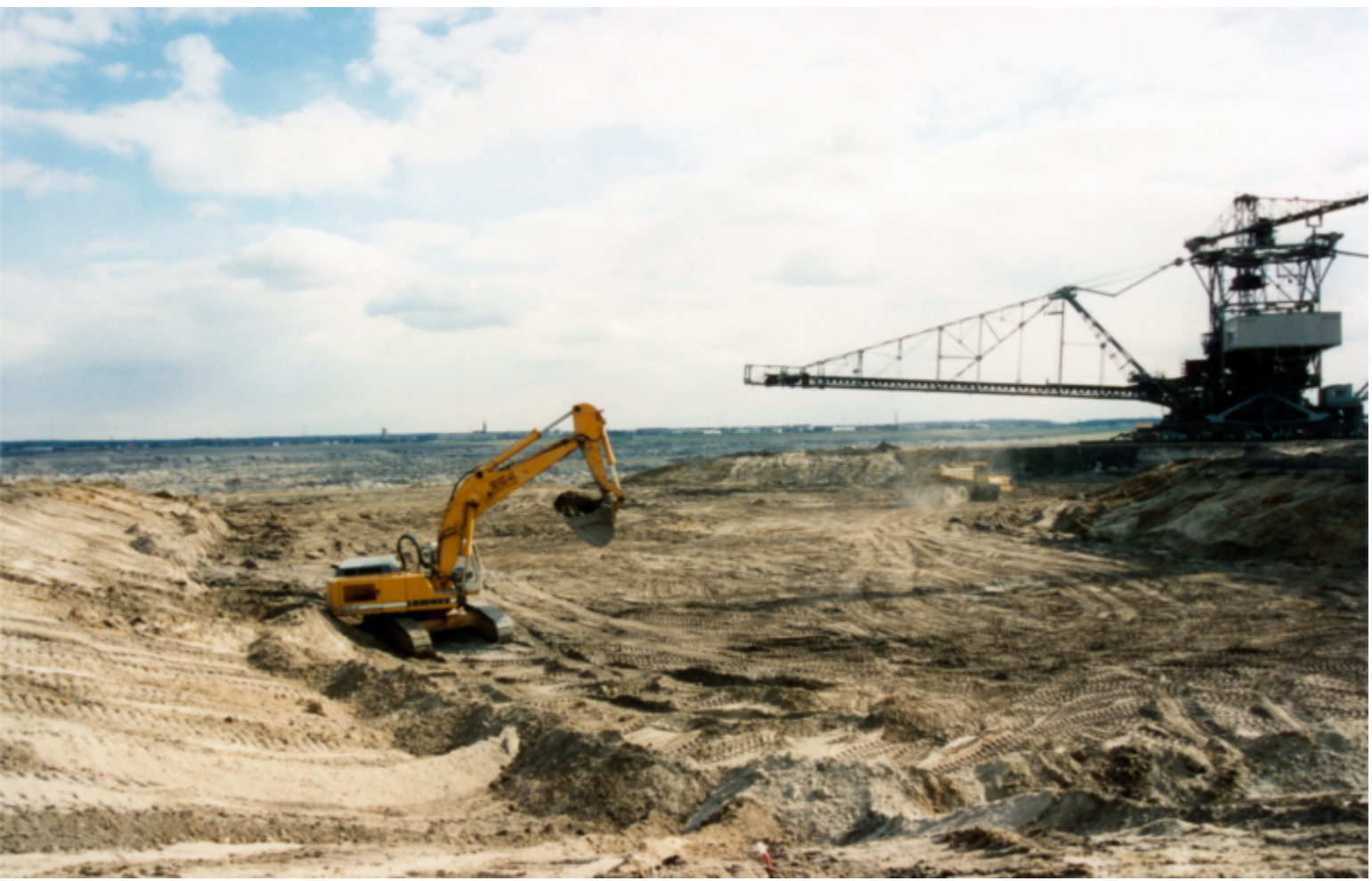
Bau der Ferropolis-Arena 1999
