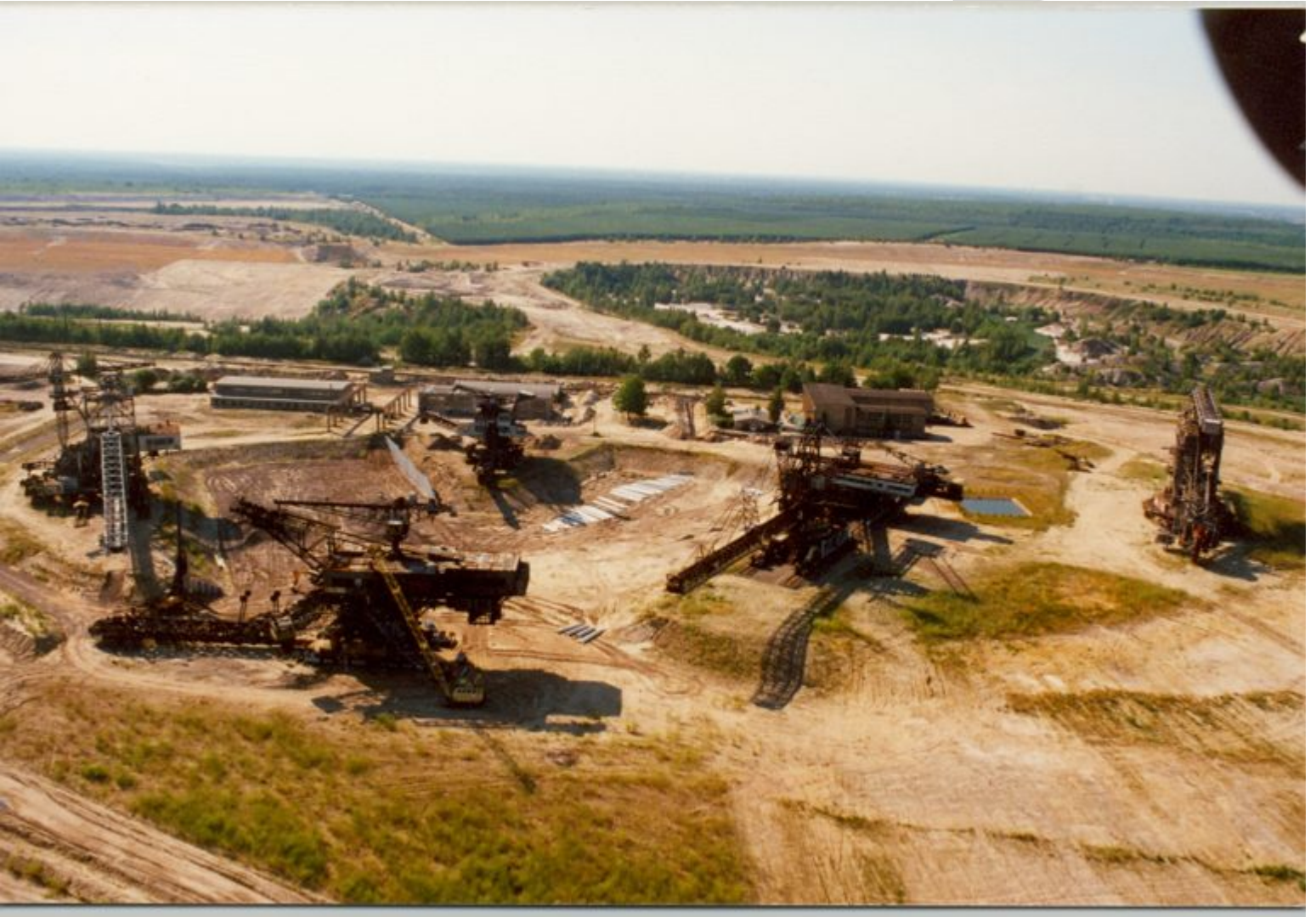
Halbinsel Golpa-Nord zunächst nur Abstellplatz für LMBV-Großgeräte
