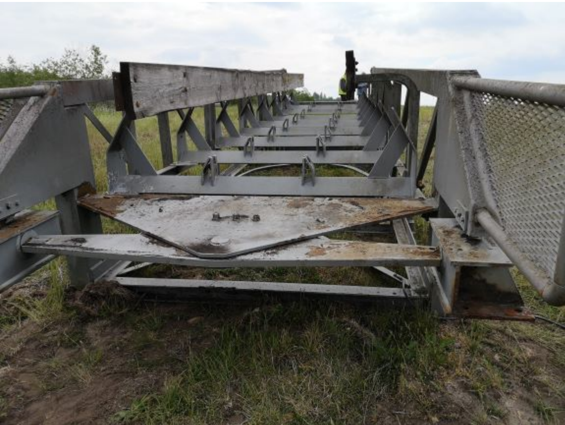
Auflaufbrücke steht am Lappwaldsee (Foto: LMBV)
