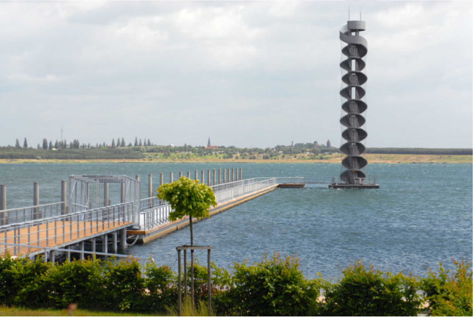
2009 präsentierte sich die Anlage rund um den Pegelturm erneuert
