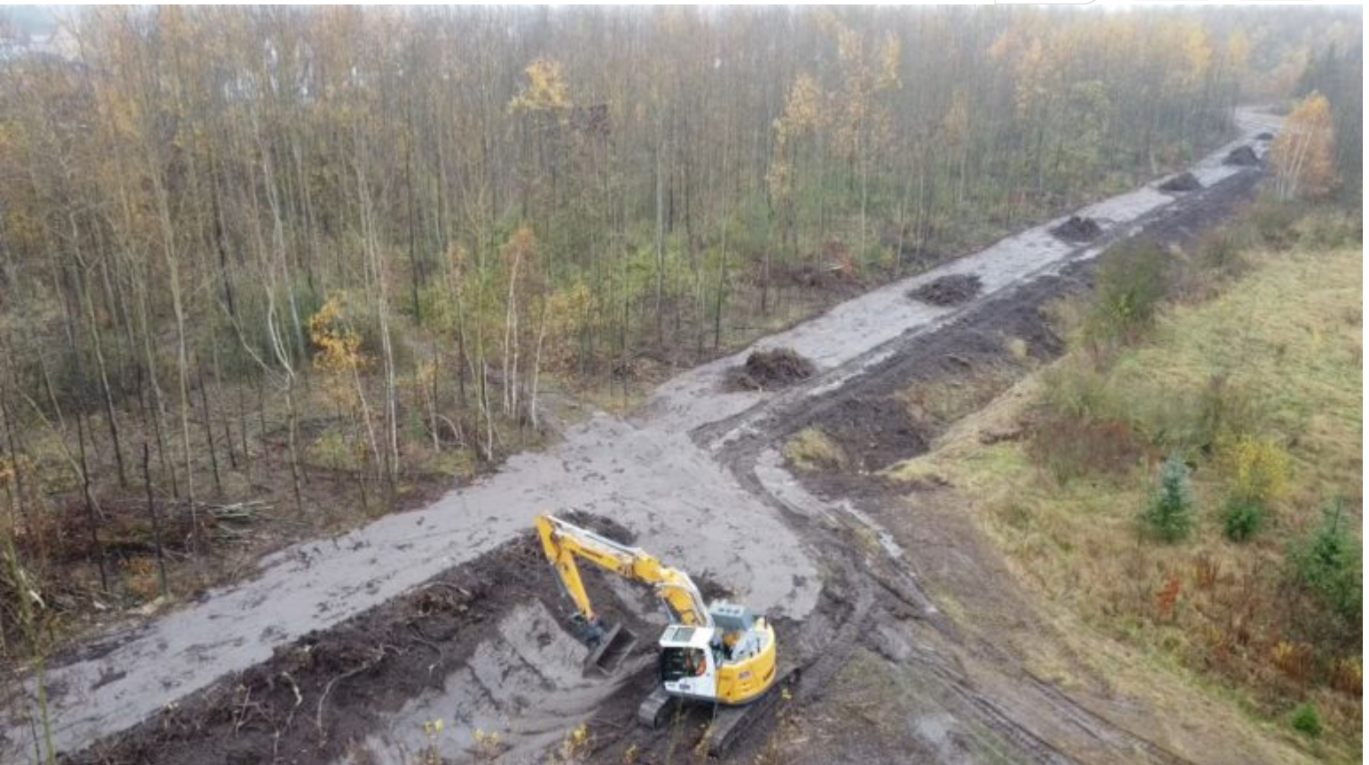
Beginn der Bauarbeiten
