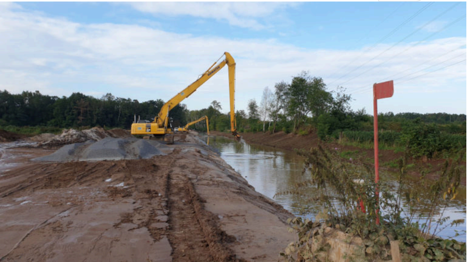
Einseitiger Ausbau der Kleinen Spree
