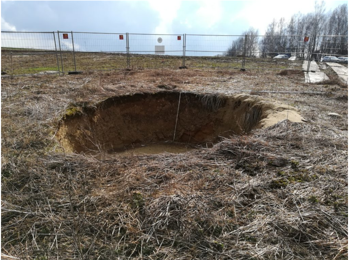
Erkundung und Verwahrung BTG Nr. 131 „GERTRUD“ vor 1945 im Bereich Tagesbruch TB-TH/19/2670
