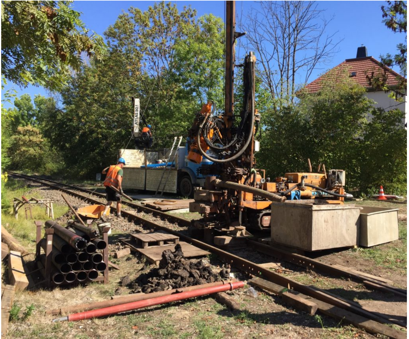
Erkundungsbohrungen Kohletraditionsbahn Meuselwitz (2018/2019)
