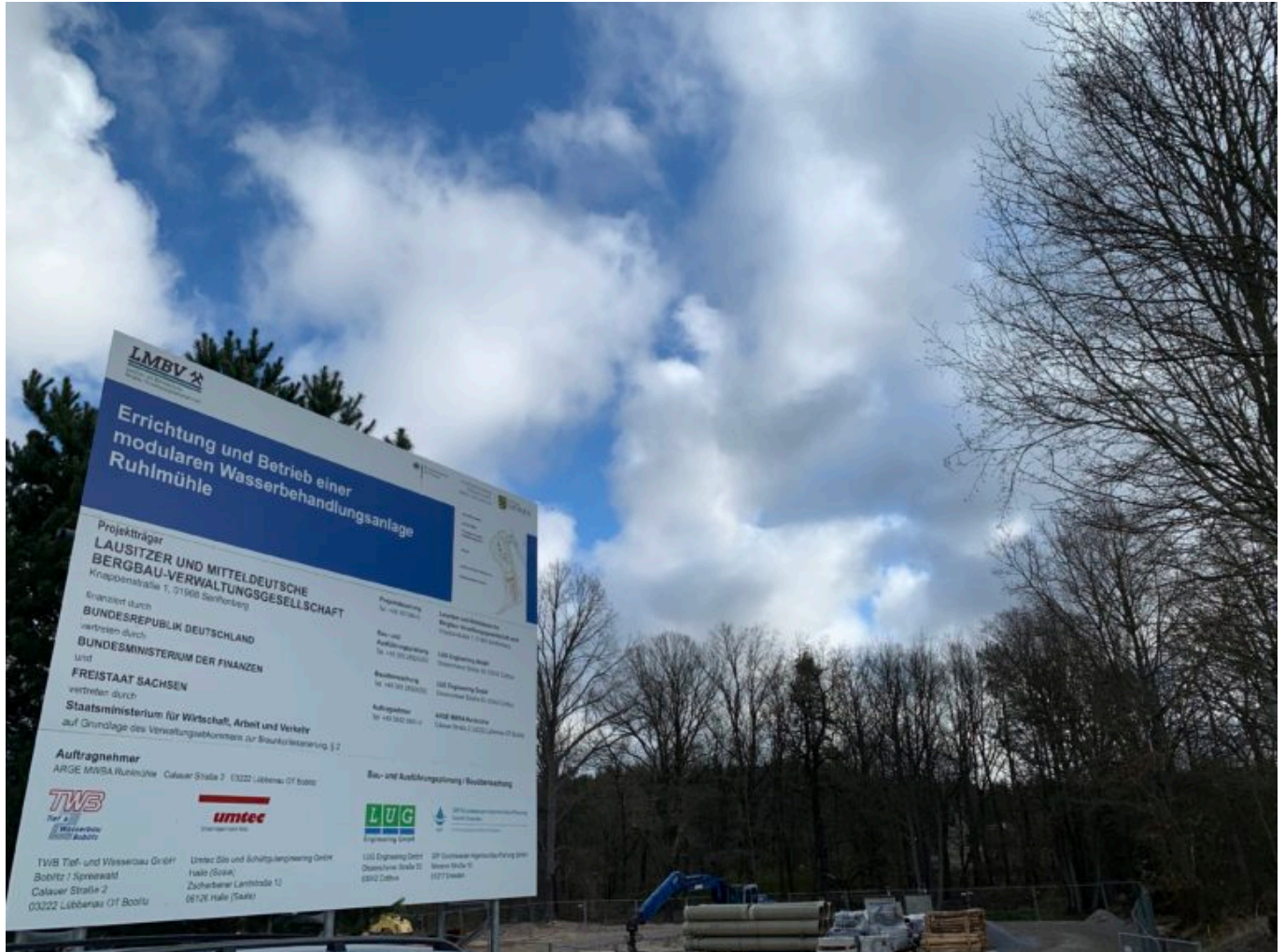
Bauschild für die im Bau befindliche MWBA Rummühle
