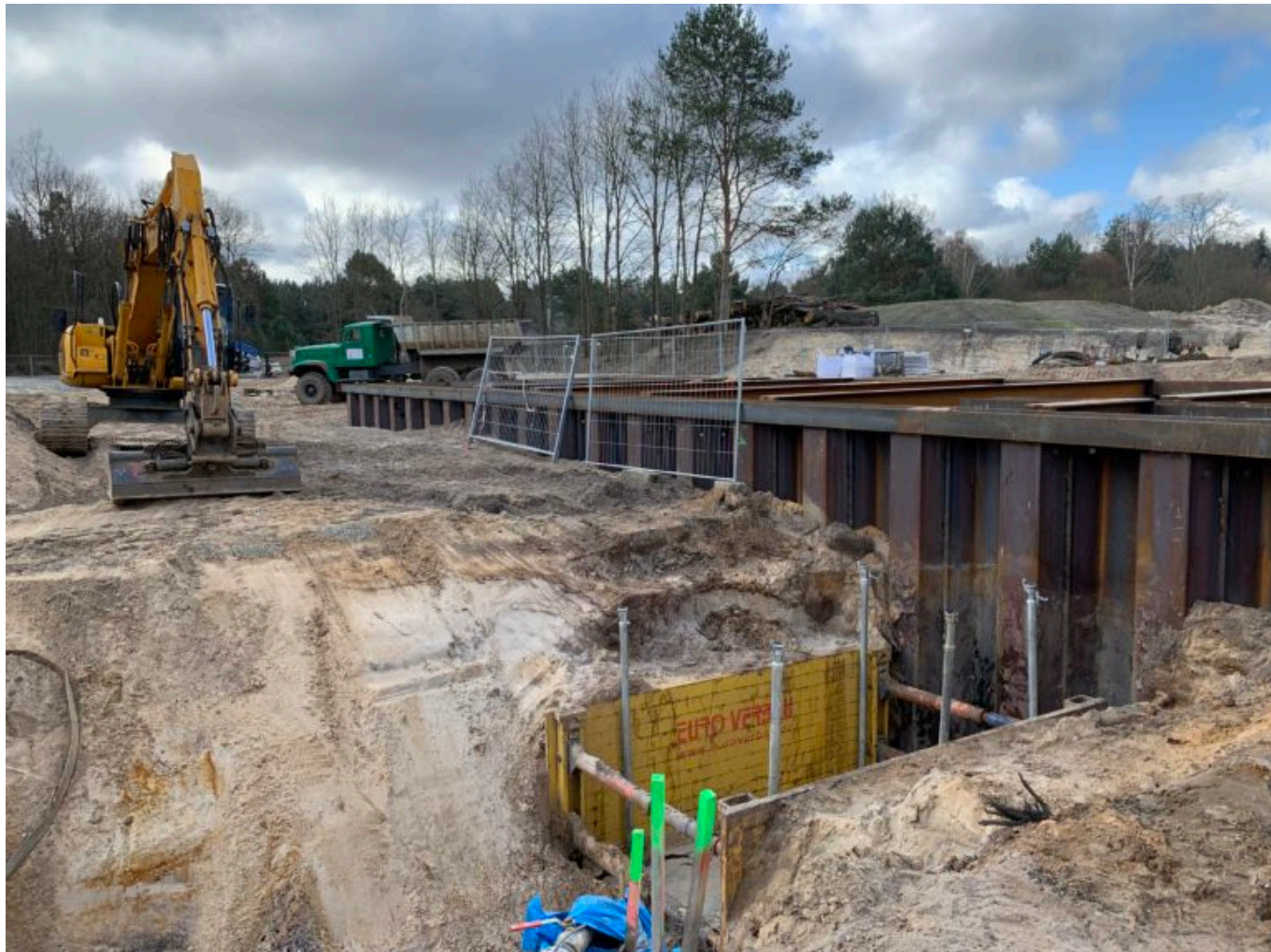
MWBA Ruhlmühle der LMBV im Aufbau
