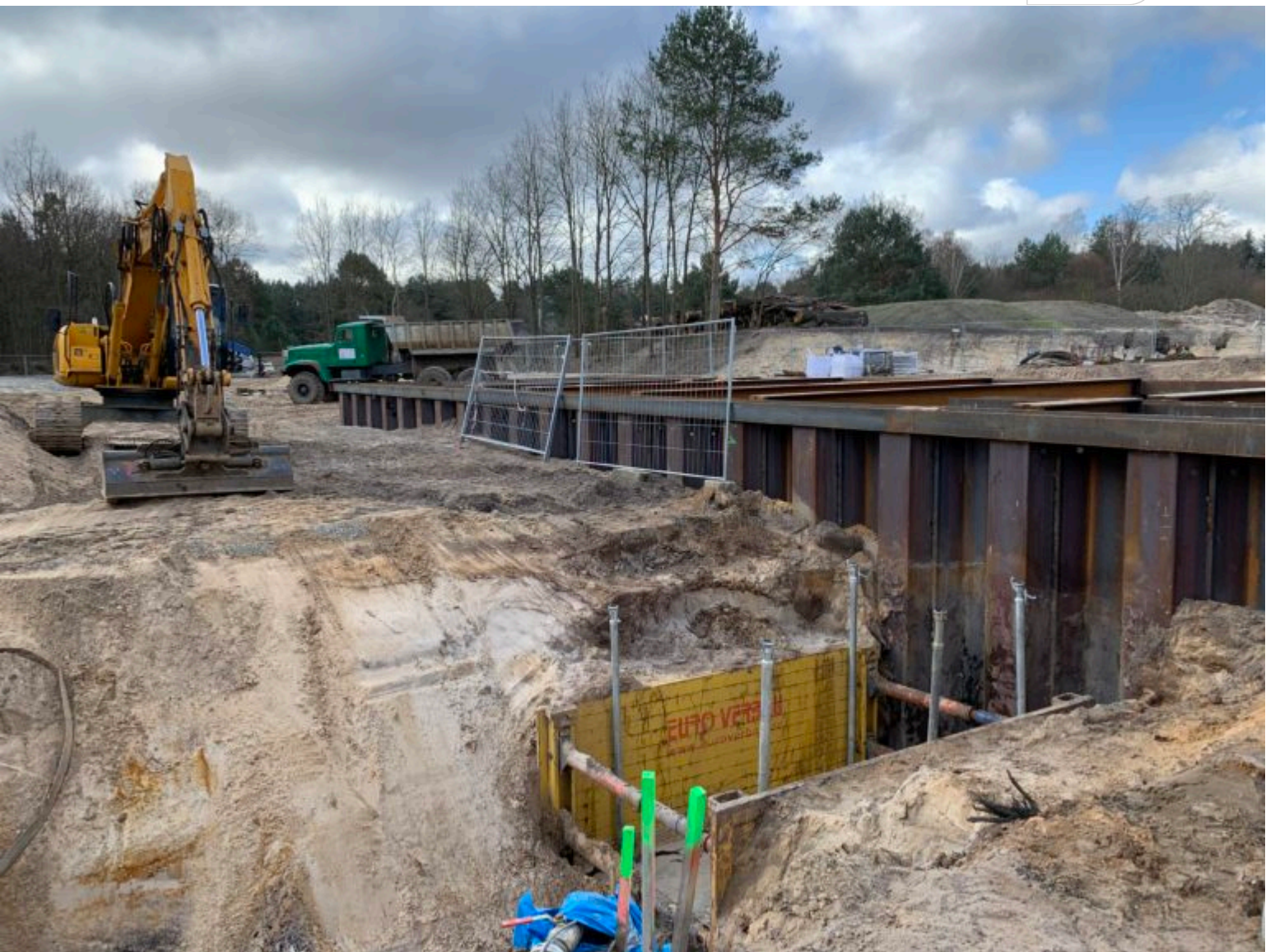
MWBA Ruhlmühle der LMBV im Aufbau
