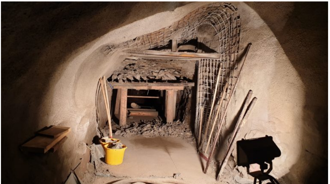
Hergestellter Ausbau in Blickrichtung Schlüsselstollen
